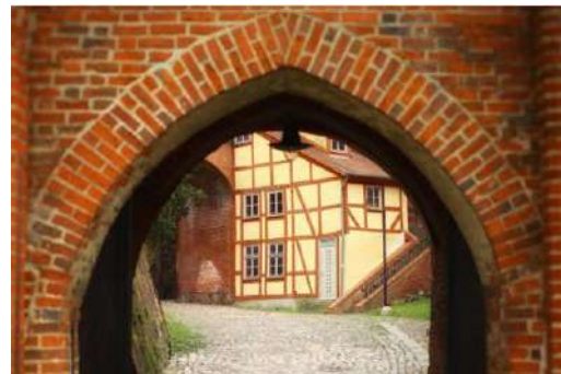
Slika 31. Izvedeni šiljasti luk od opeke zidan načinom lastin rep
