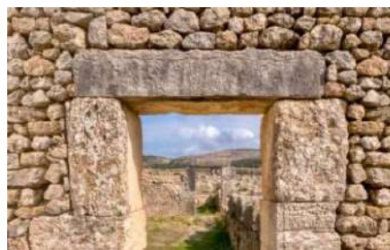
Slika 35. Izvedeni nadvoj od kamena
