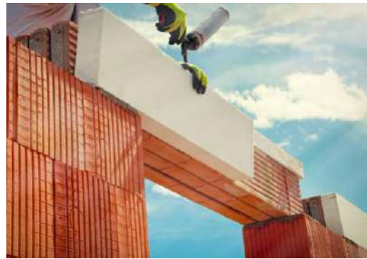
Slika 47. Izvedeni nadvoj od armirane tankostijene opeke
