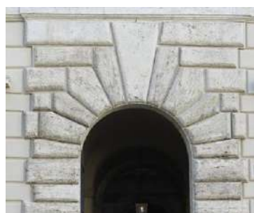
Slika 18. Izvedeni polukružni luk od kvakastih klesanaca
