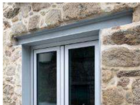
Slika 41. Izvedeni nadvoj od čeličnih traverzi
