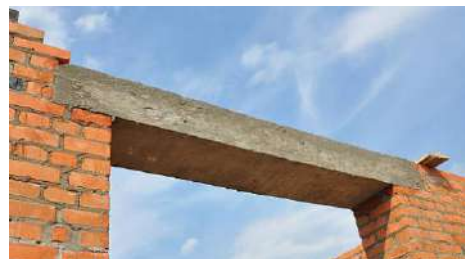
Slika 43. Izvedeni armiranobetonski nadvoj
