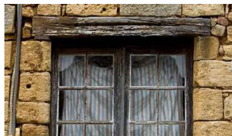
Slika 39. Izvedeni nadvoj od drvenih greda
