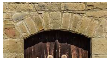
Slika 14. Izvedeni segmentni luk od kamena
