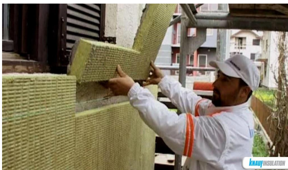
Slika 17. Postavljanje kamene vune oko otvora
