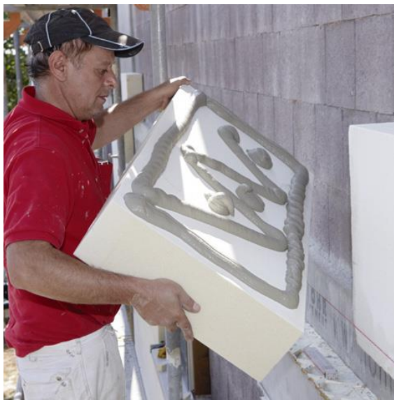
Slika 29. Nanošenje ljepila
