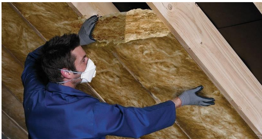
Slika 19. Postavljanje staklene vune
