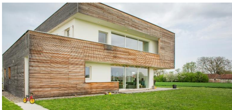
Slika 31. Južna strana kuće
