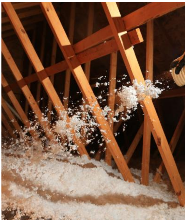
Slika 11. Izvedba toplinske izolacije celulozom
