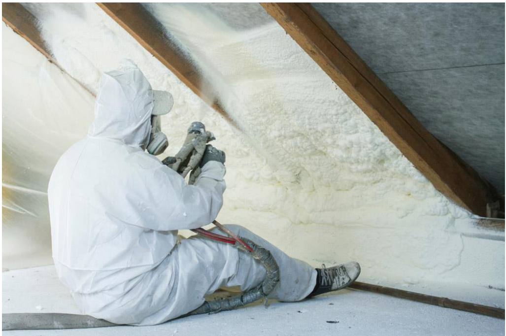
Slika 25. Izvedba izolacije poliuretanskom pjenom
