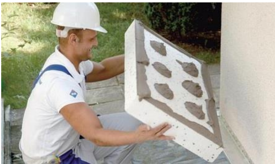
Slika 22. Lijepljenje stiropora
