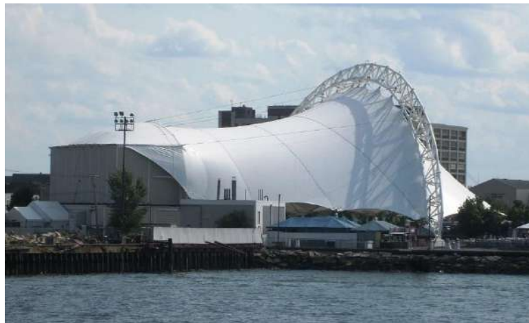
Slika 21. Primjer izvedene konstrukcije lučnog oblika
