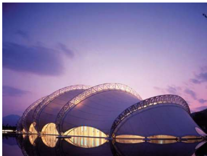
Slika 22. Primjer izvedene konstrukcije s paralelnim lukovima
