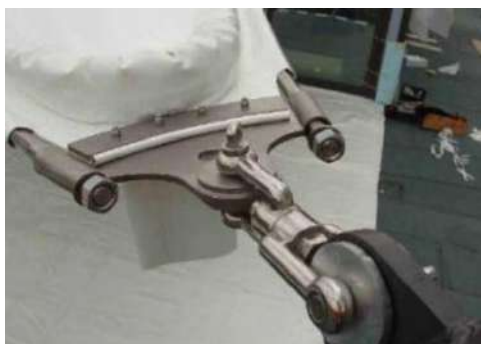
Slika 40. Spoj membrane s rubnim elementima
