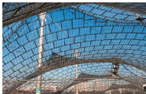
Slika 6. Krovna konstrukcija, Olimpijski stadion
