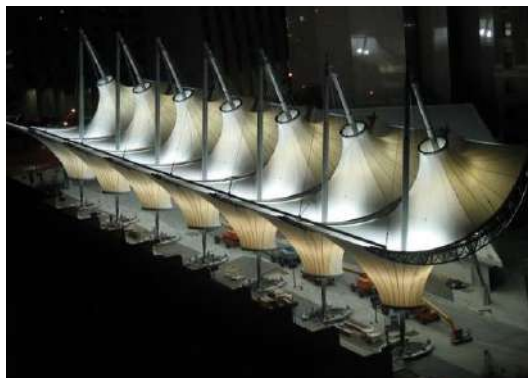
Slika 16. Primjer izvedene konstrukcije složenog stožastog oblika
