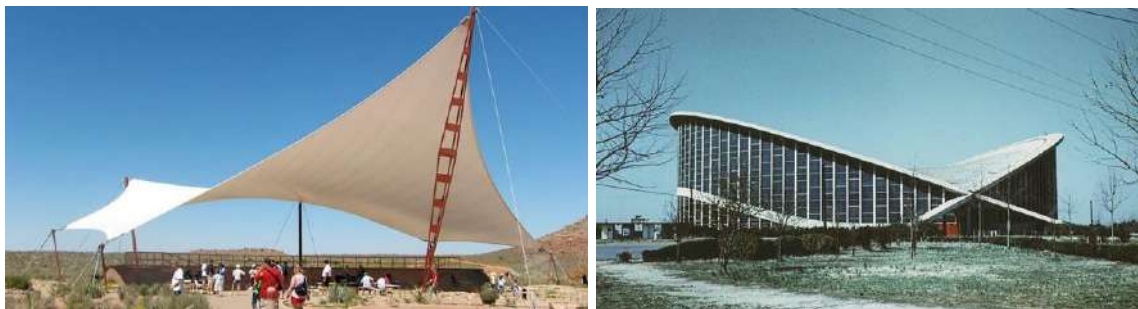
Slika 19. Primjeri izvedenih konstrukcija sedlastog oblika
