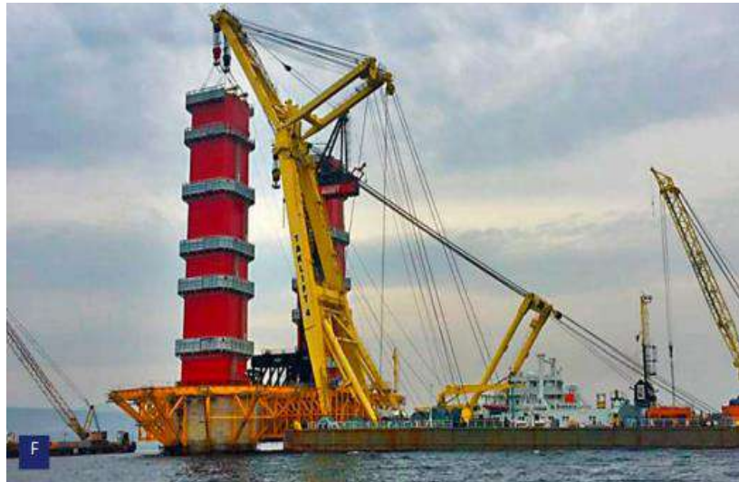
Slika 47. Primjer montaže visećeg mosta
