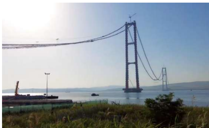
Slika 52. Početak izvedbe mosta
