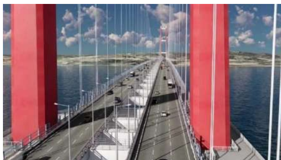
Slika 50. Prikaz prometnice na mostu
