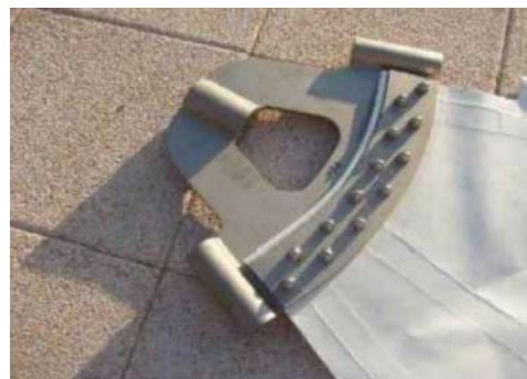
Slika 40. Spoj membrane s rubnim elementima
