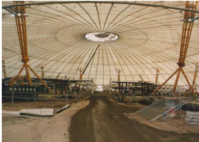
Slika 24. Primjer izvedene konstrukcije s membranskim mrežama
