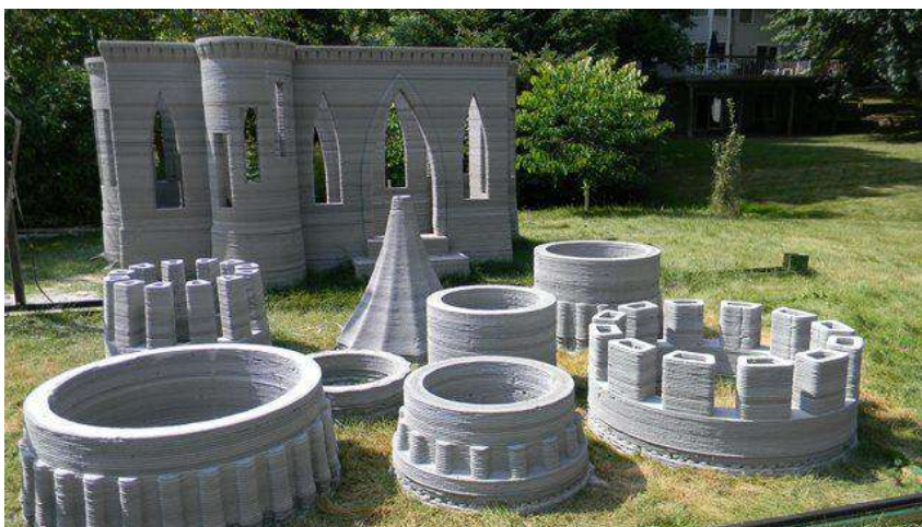
Slika 21. Prikaz replike povijesne građevine isprintan metodom Total Kustom
