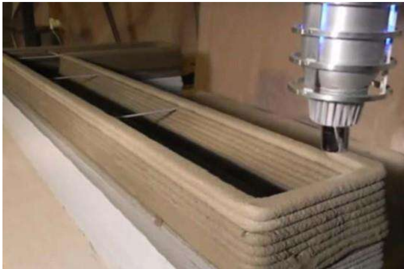
Slika 22. Printanje tankih slojeva betona
