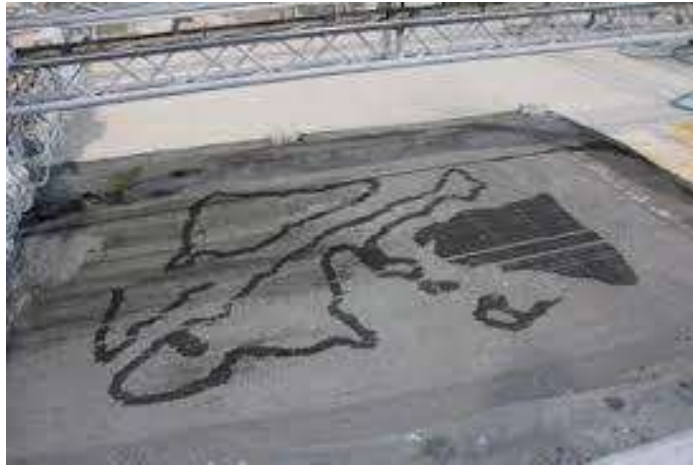
Slika 10. Nanošenje tekućeg vezivnog materijala na sloj pijeska i cementa
