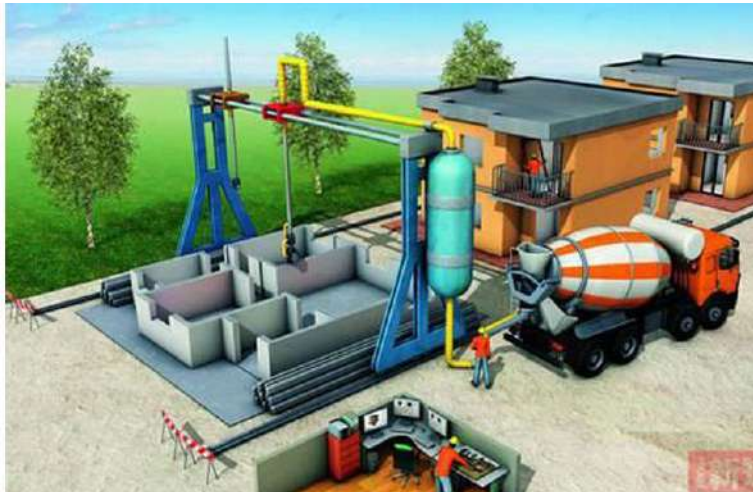
Slika 6. Proces printanja cijele zgrade
