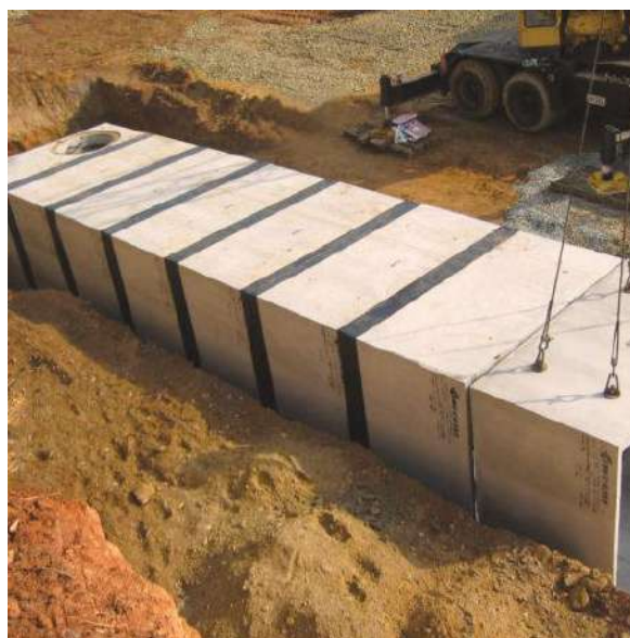
Slika 24. Spoj elemenata ljepljenjem
