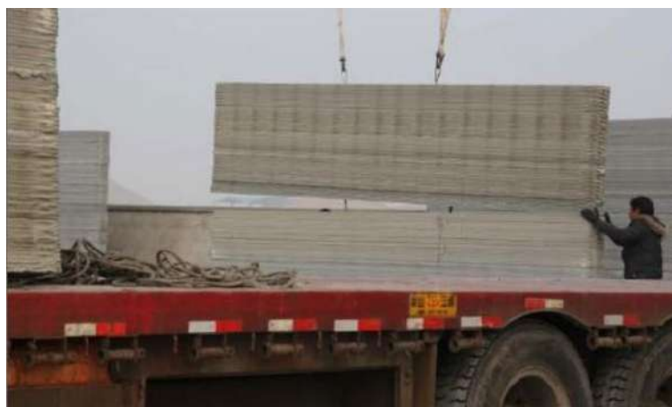
Slika 19. Spajanje predgotovljenih elemenata na gradilištu
