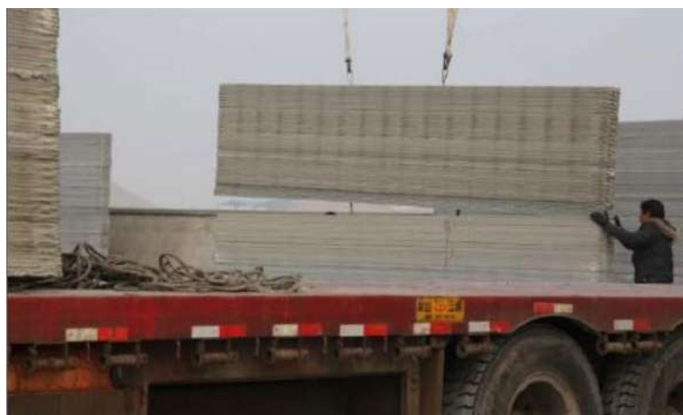
Slika 19. Spajanje predgotovljenih elemenata na gradilištu
