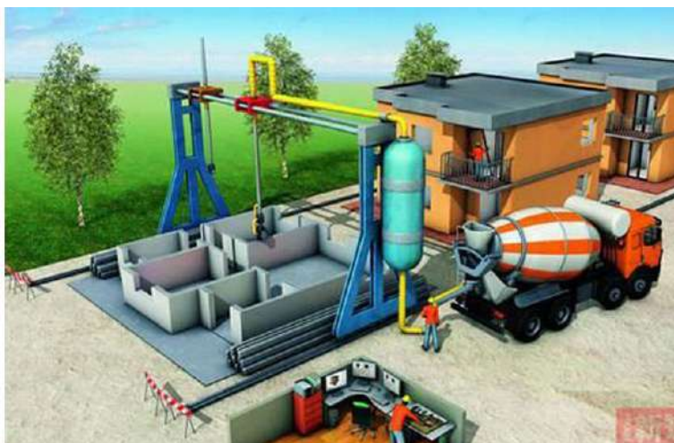
Slika 6. Proces printanja cijele zgrade
