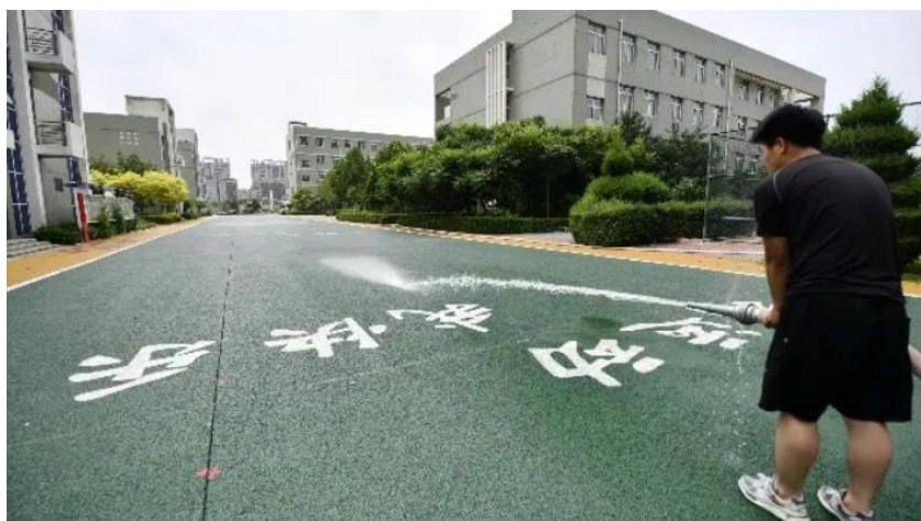
Slika 26. Prskanje propusne površine ceste tijekom ispitivanja u Qian'anu, testnom gradu spužvi koji je transformiran 2015. godine
