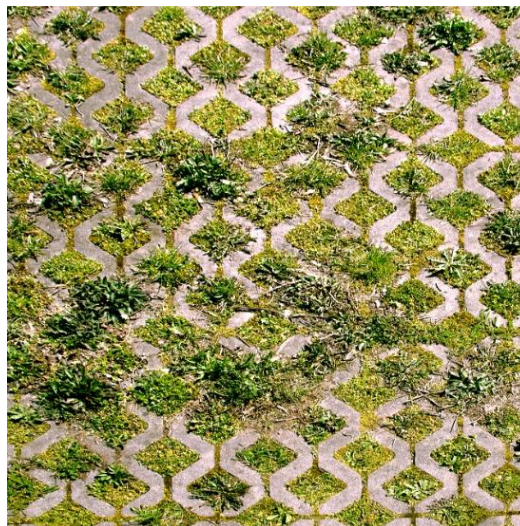
Slika 20. Propusna površina
