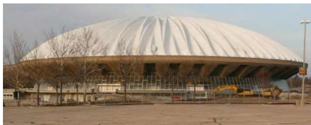
Slika 14. Assembly Hall, Illinois [11]
