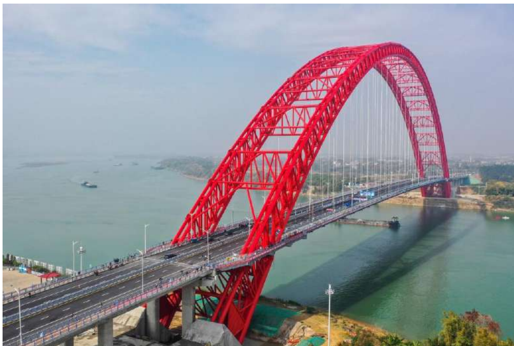
Slika 13. Most Third Pingan u Kini (lučni most najvećeg raspona na svijetu, 575 m ) ( http://www.xinhuanet.com/english/2020-12/28/c_139624586.htm )
