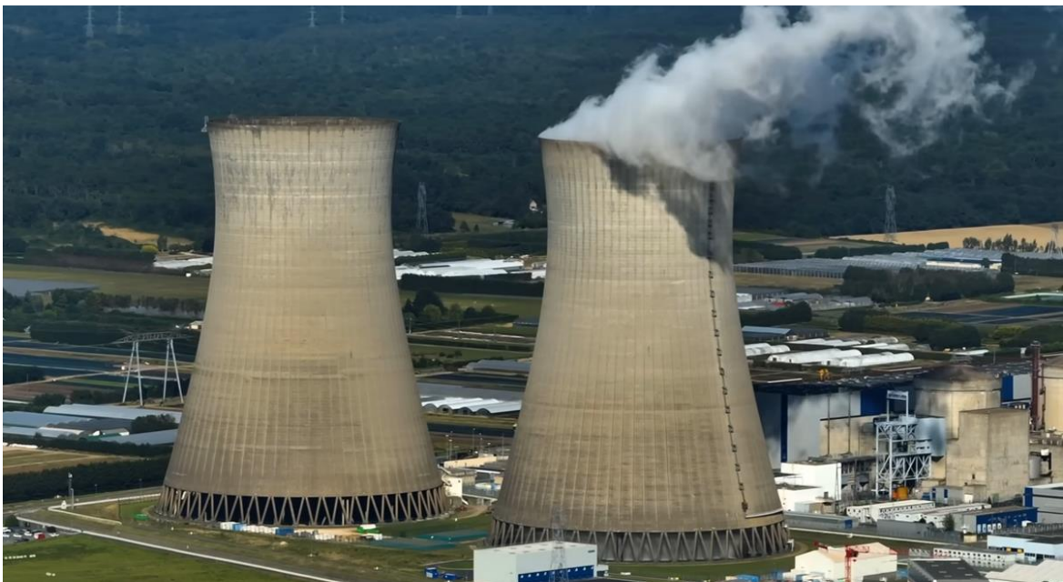
Slika 5. Dimnjak nuklearnog reaktora kao primjer rotacijskog hiperboloida [5]
