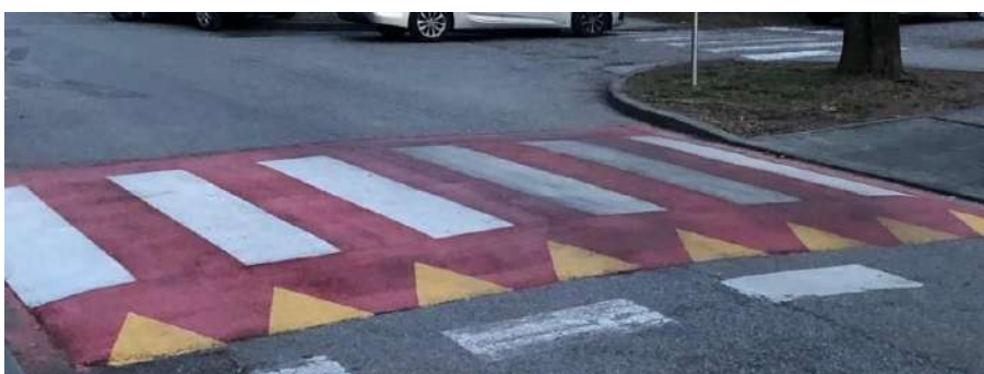
Slika 6 Primjer uzdignute plohe s pješačkim prijelazom
