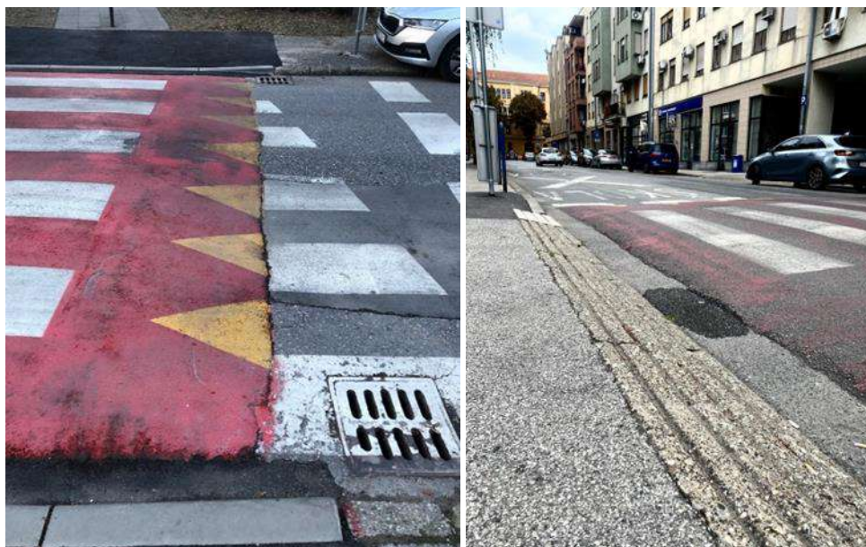
Slika 14 Detalji odvodnje na uzdignutim ploham
