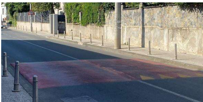
Slika 34 Prikaz uzdignute ploha u Ulici Sveti Duh (lokacija 2)
