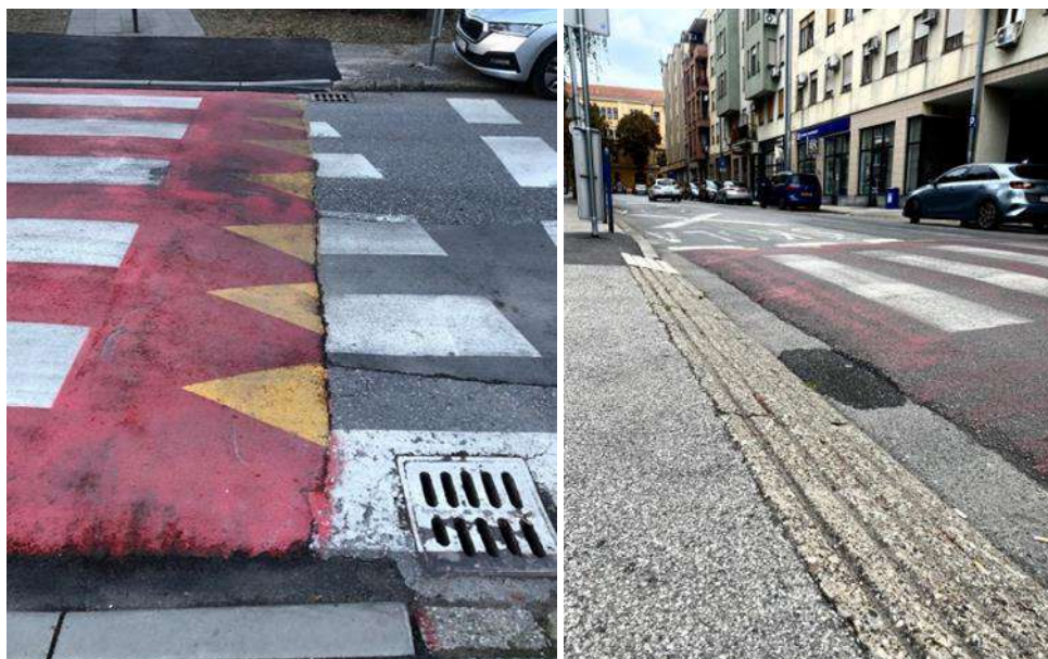
Slika 14 Detalji odvodnje na uzdignutim ploham
