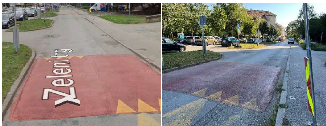
Slika 8 Primjeri uzdignutih ploha (u nizu) na pristupnim cestama uz parkirališta [13]
