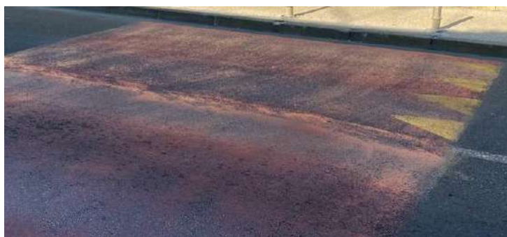
Slika 13 Spojevi asfalta na uzdignutoj plohi koja se izvodi u punoj širini kolnika u Ulici Sveti Duh
