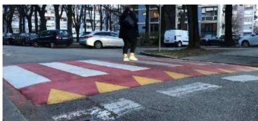
Slika 27 Detalj [5] i primjer oznake (H55-1) duž cijele uzdignute plohe
