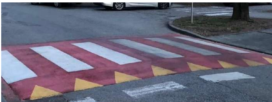
Slika 6 Primjer uzdignute plohe s pješačkim prijelazom
