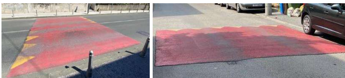
Slika 28 Primjer oznake (H55) a) odvojeno po trakovima, b) u jednosmjernoj ulici
