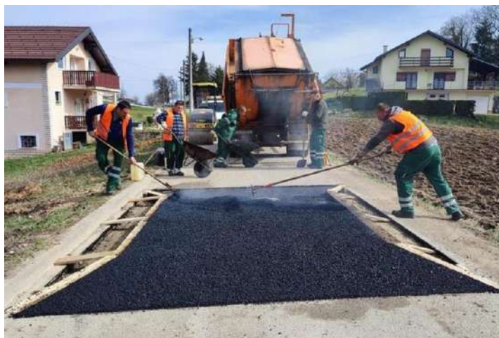
Slika 12 Primjer asfaltiranja uzdignute plohe u punoj širini kolnika [17]
