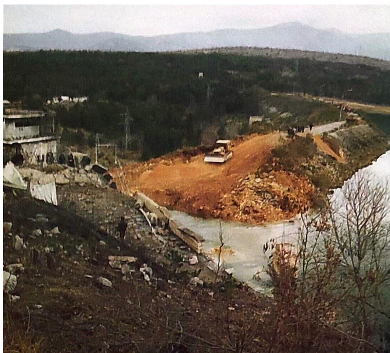
Slika 7 – Krater na lijevom boku brane [7].
