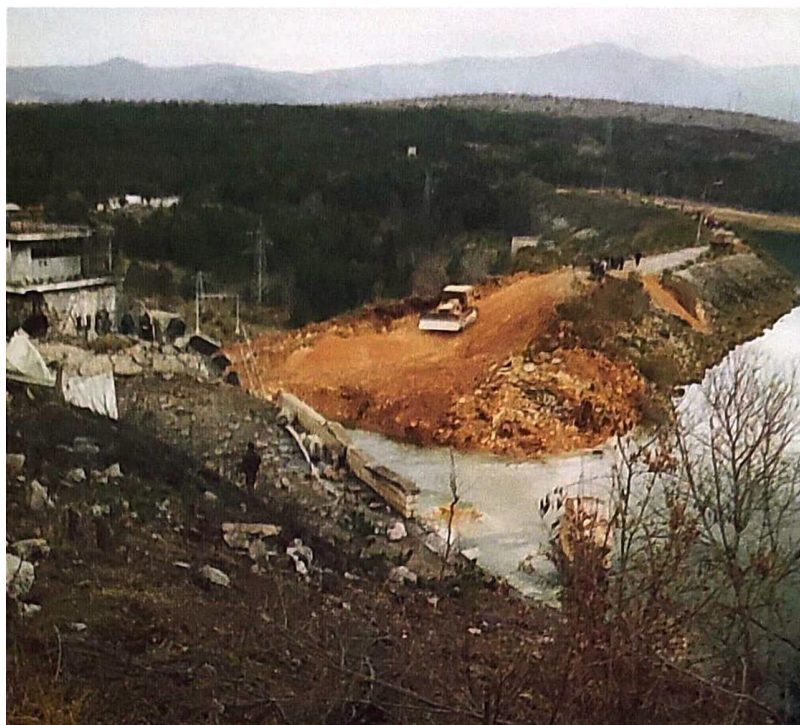
Slika 7 – Krater na lijevom boku brane [7].
