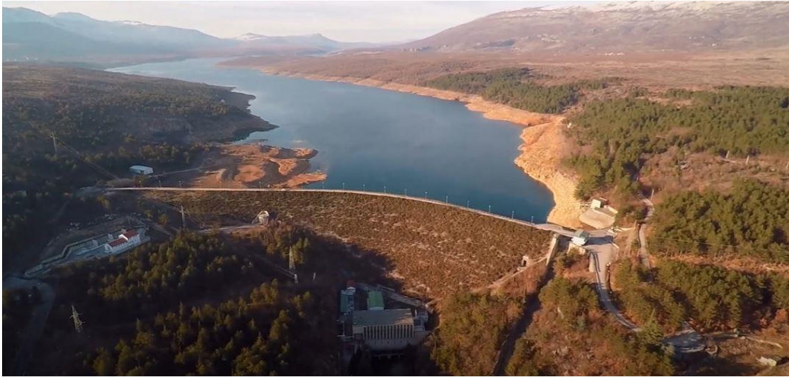
Slika 5 – Prikaz brane, akumulacije i postrojenja [8].
