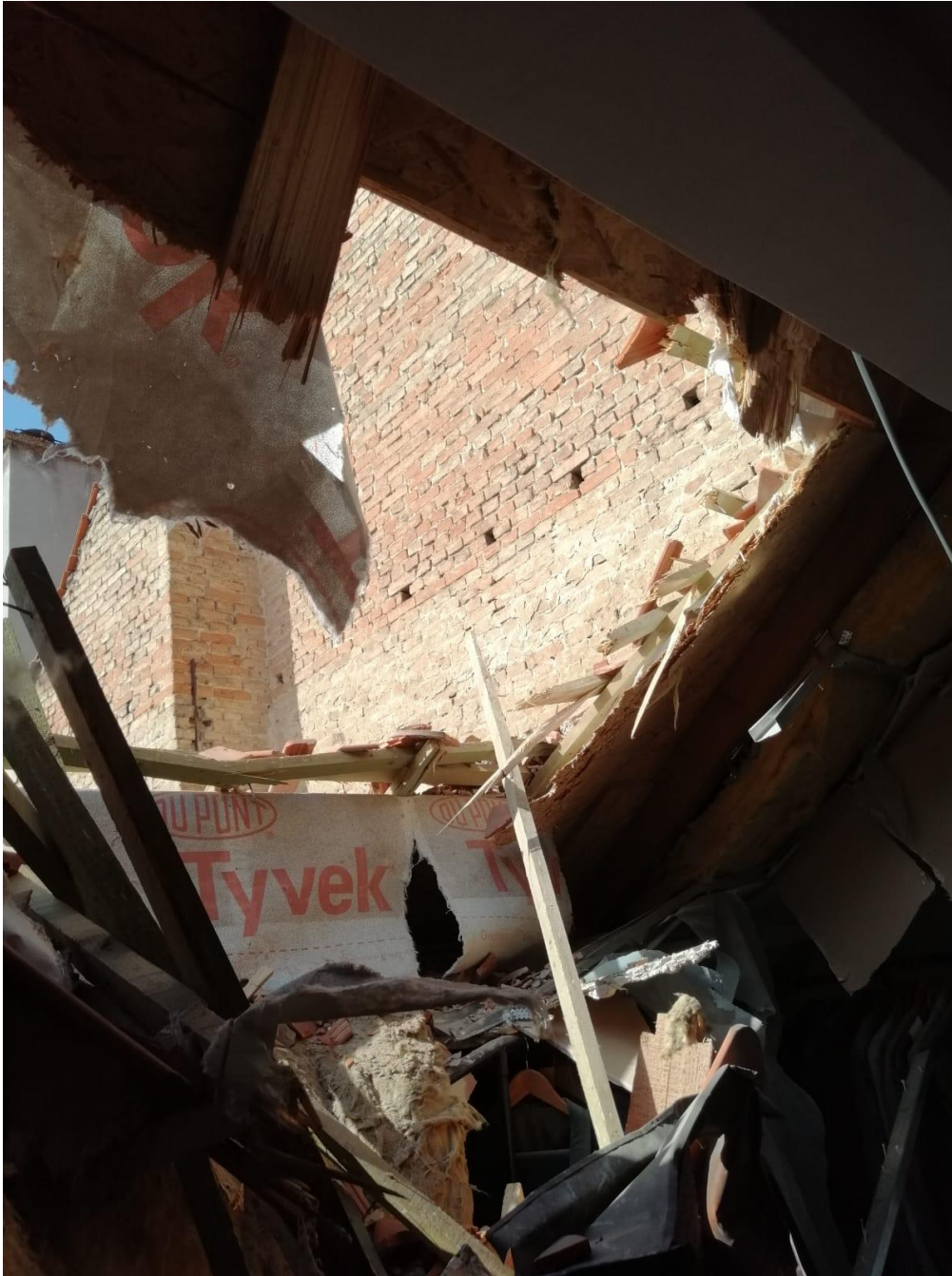
Slika 24 Pogled s unutarnje strane krovišta
