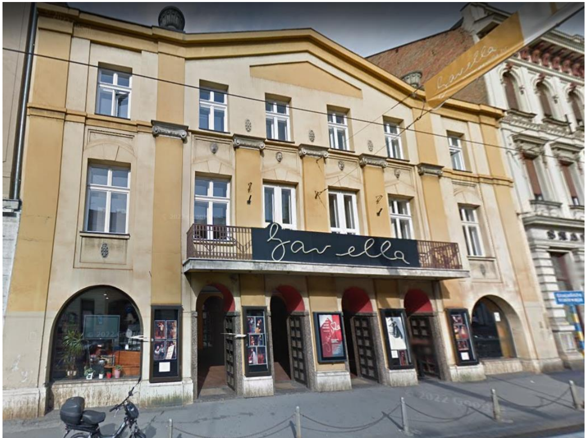
Slika 4 Pročelje prije potresa
