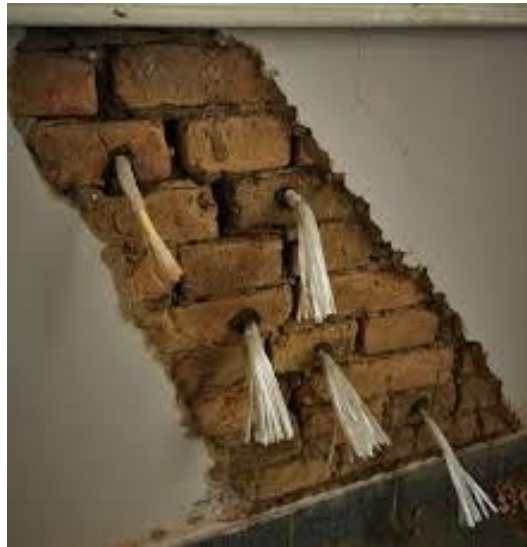
Slika 35 FRP staklena vlakna [10]
