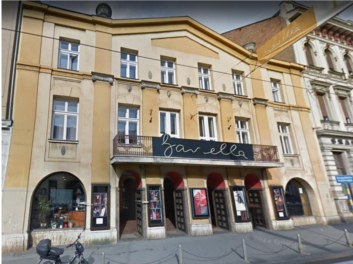
Slika 4 Pročelje prije potresa
