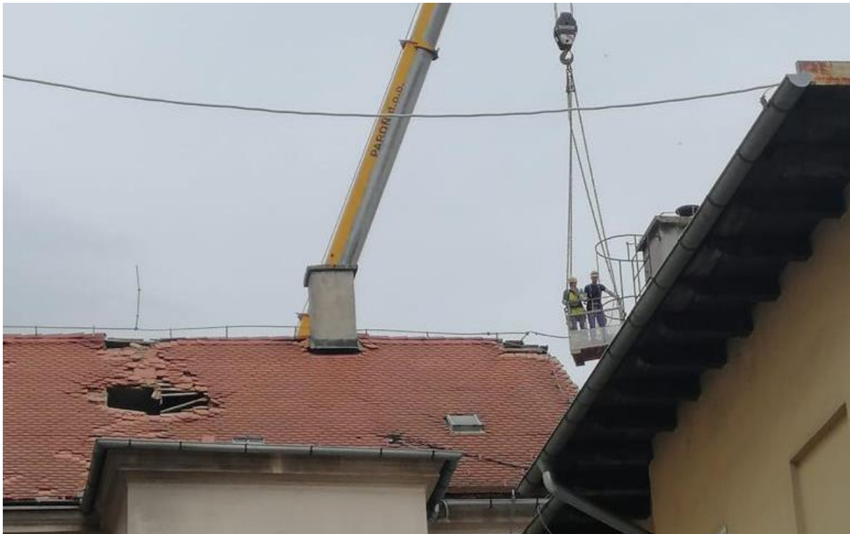
Slika 25 Sanacija krovišta i dimnjaka
