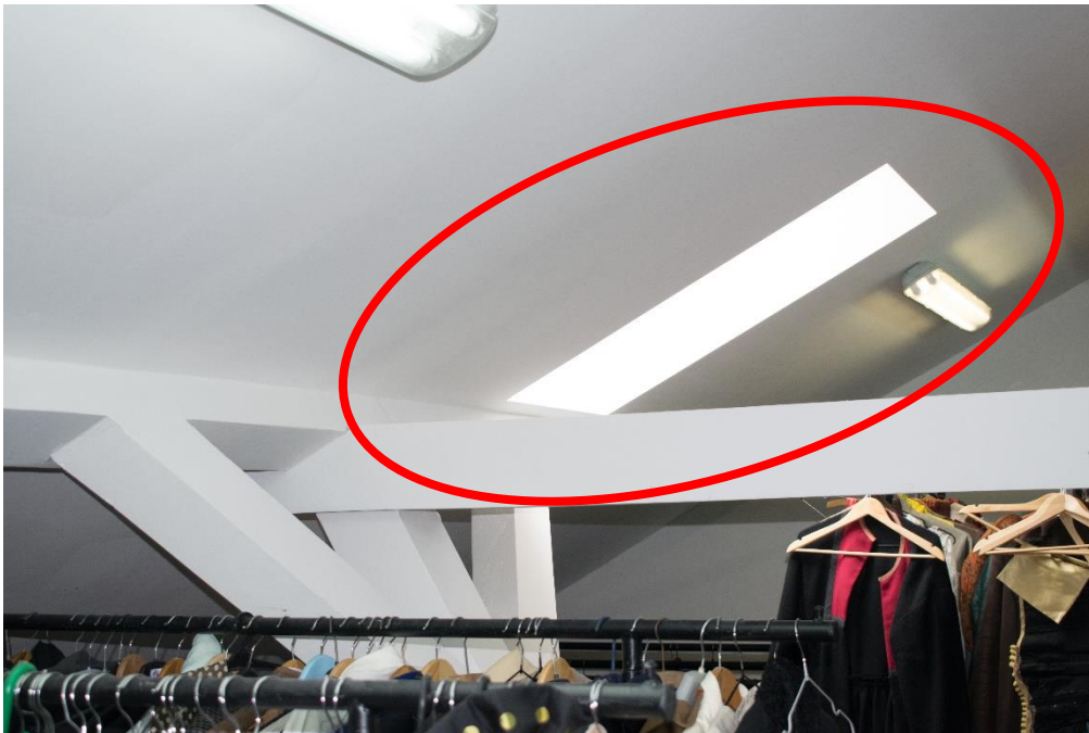
Slika 37 Dio krovišta koji je saniran
