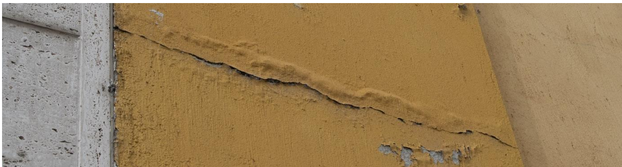
Slika 29 Horizontalna pukotina
