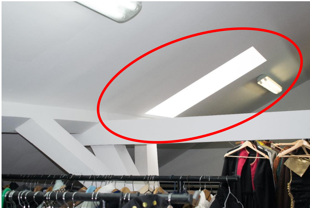
Slika 37 Dio krovišta koji je saniran
