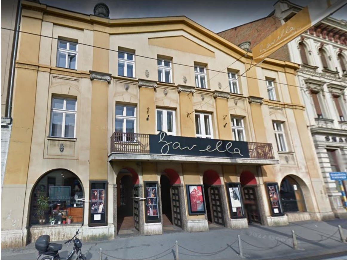
Slika 4 Pročelje prije potresa
