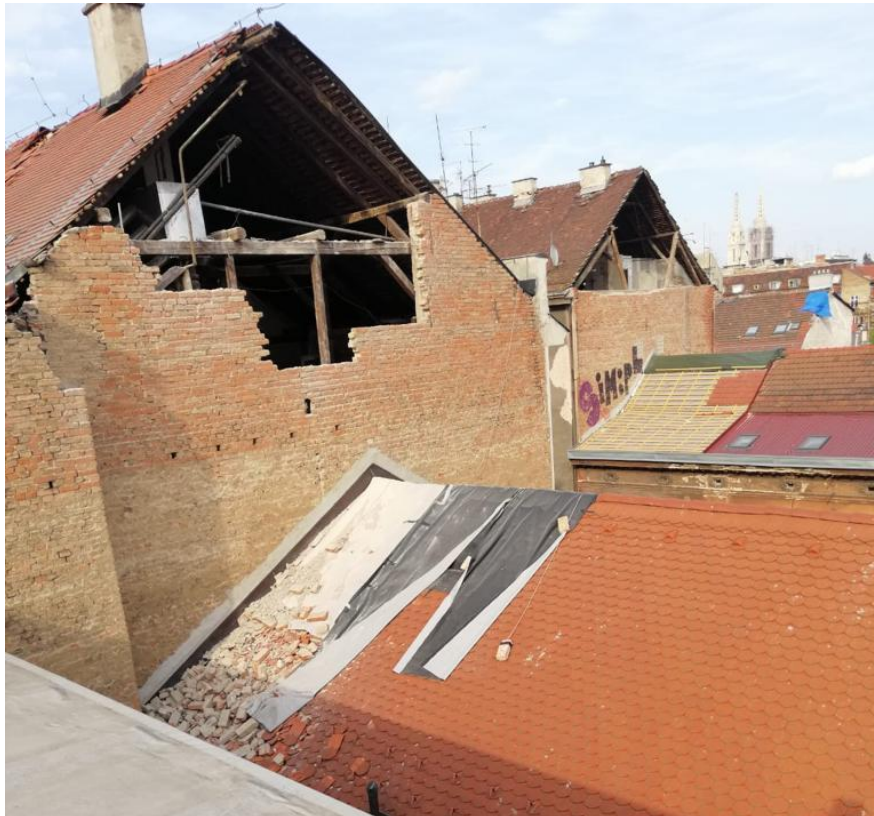
Slika 23 Zabatni zid susjedne građevine
