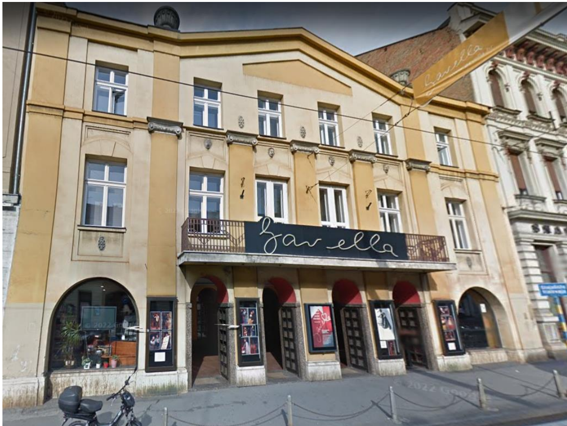
Slika 4 Pročelje prije potresa
