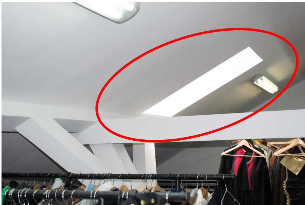
Slika 37 Dio krovišta koji je saniran
