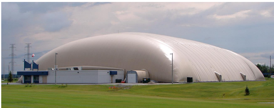
Slika 3. Primjer pneumatske konstrukcije
