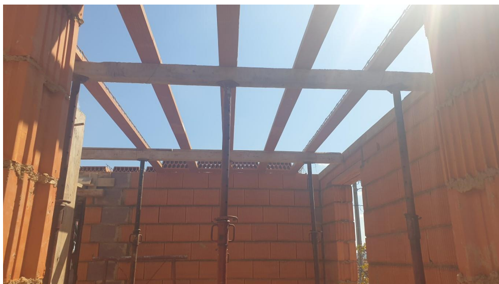
Slika 32. Postavljanje "fert" gređica i podvlake od mosnica
