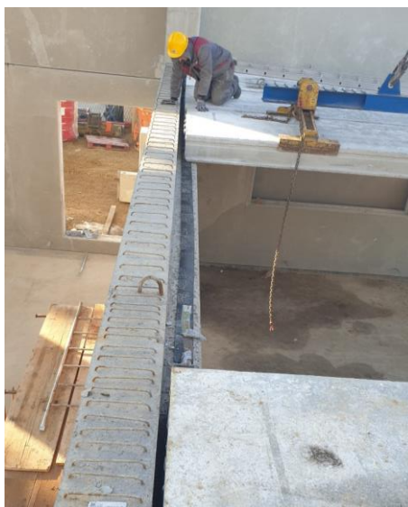
Slika 37. Oslanjanje šupljih predgotovljenih ploča na oslonce
