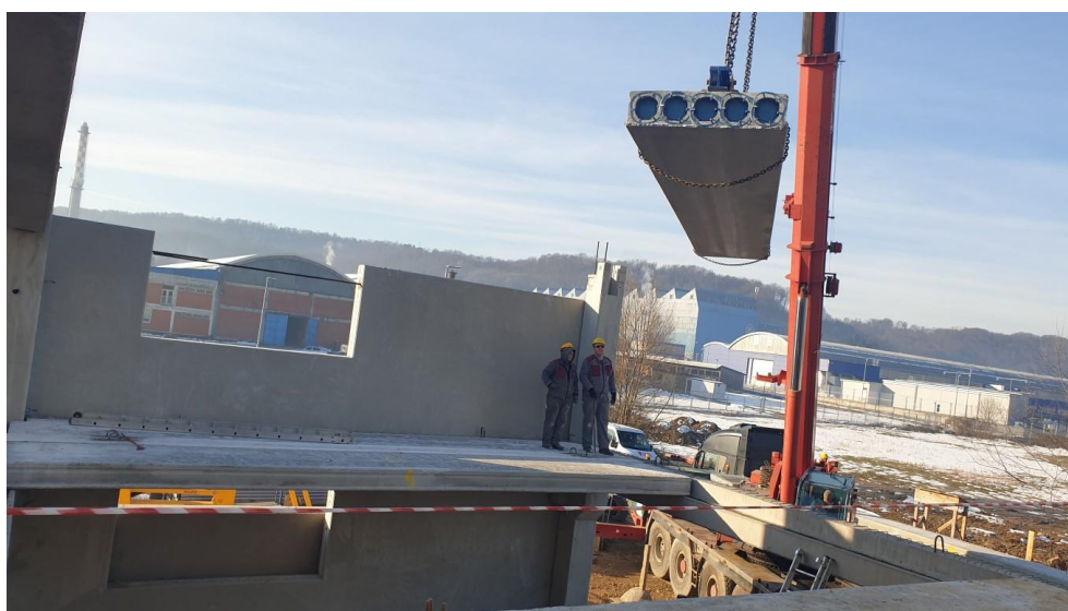
Slika 36. Transport i postavljanje šupljih predgotovljenih ploča
