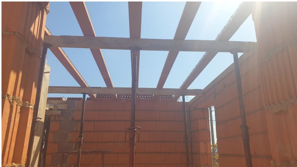
Slika 32. Postavljanje "fert" gređica i podvlake od mosnica
