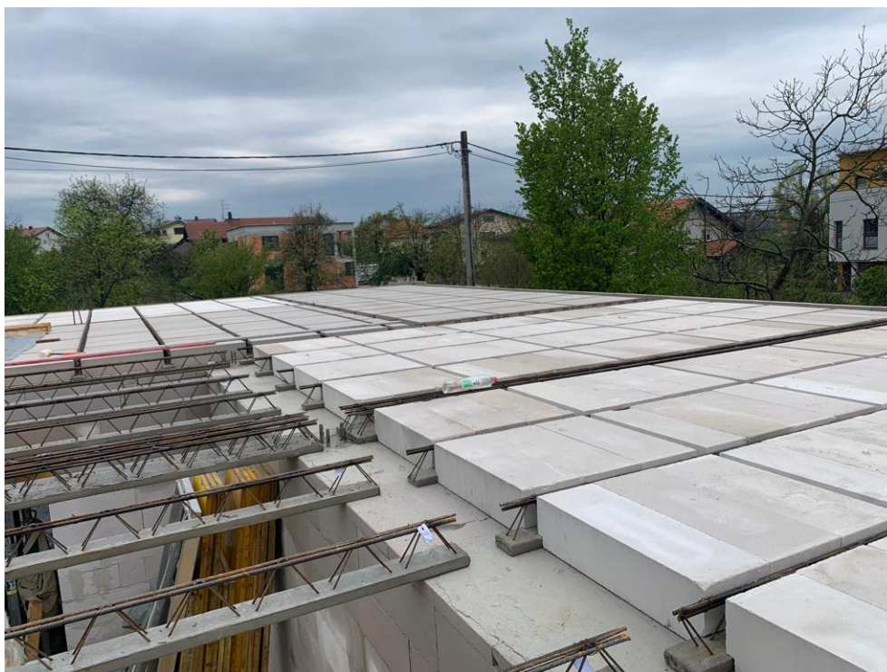
Slika 34. Sistem bijeli ("Ytong") strop u ranoj fazi izvedbe i u fazi prije završnog betoniranja rebara i premazivanja tankoslojnim mortom
