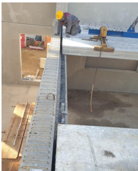
Slika 37. Oslanjanje šupljih predgotovljenih ploča na oslonce
