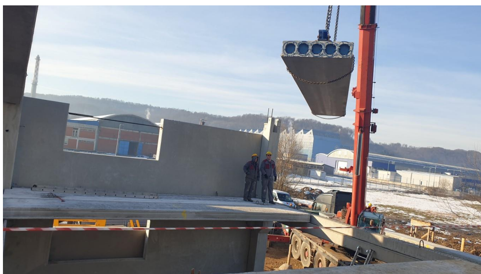
Slika 36. Transport i postavljanje šupljih predgotovljenih ploča
