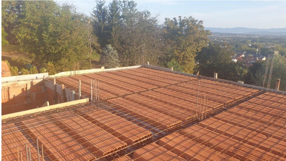
Slika 33. Strop sistema "fert" prije završnog betoniranja rebara i tlačne ploče
