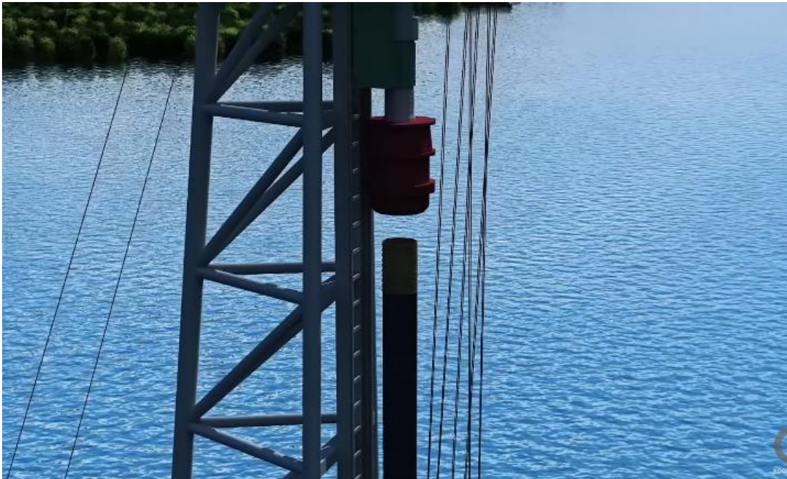
Slika 23 Zabijanje pilota čekićem
