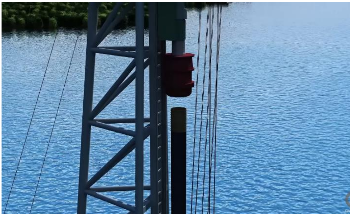
Slika 23 Zabijanje pilota čekićem
