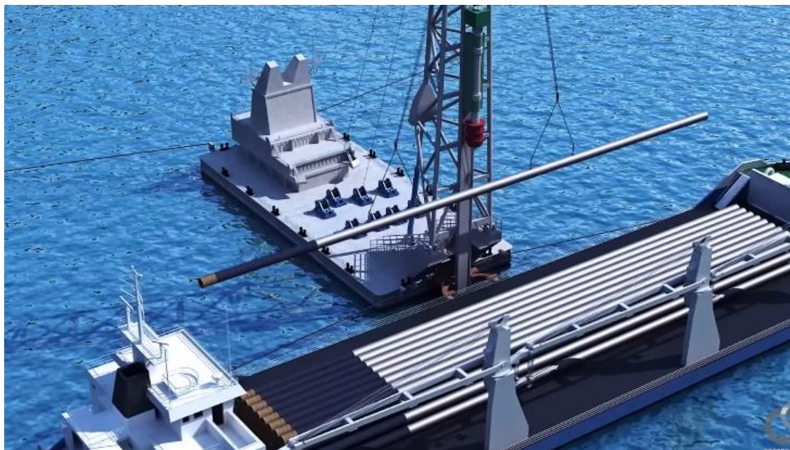
Slika 22 Specijalna dizalica koja prikazuje dizanje pilota
