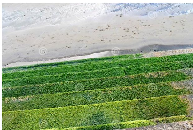
Slika 17 Alge na betonskim stepenicama
