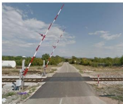
Slika 4. Osiguranje ŽCP-a branikom
