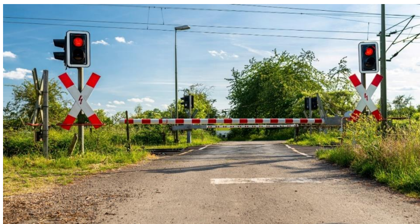
Slika 17. Primjer osiguranja ŽCP-a branicama
