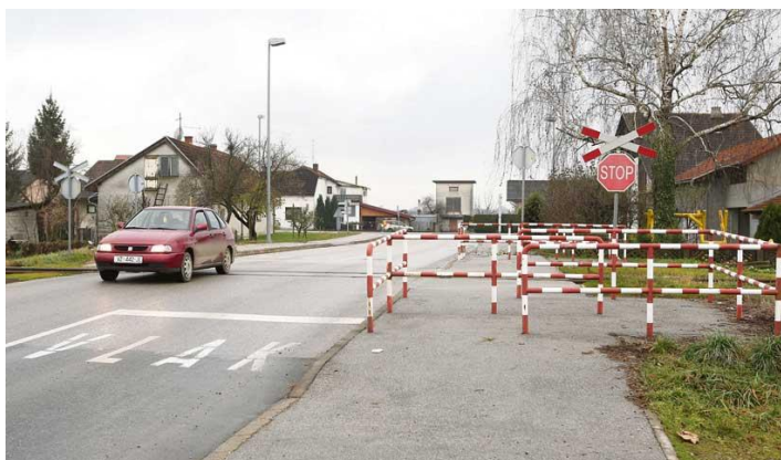
Slika 12. Pasivno osiguran željezničko-cestovni prijelaz
