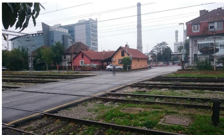
Slika 15. ŽCP osiguran punim branicima, Vodovodna ulica, Zagreb
