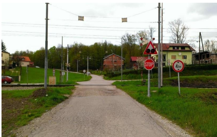
Slika 13. ŽCP „Horvati“, osiguran svjetlosno-zvučnom signalizacijom
