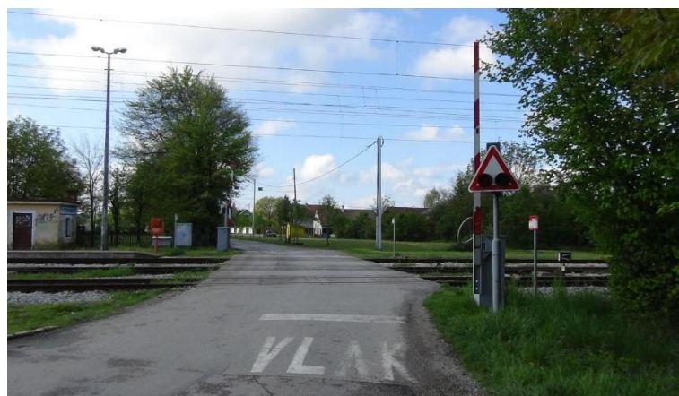
Slika 14. ŽCP sa svjetlosno-zvučnom signalizacijom i polubranicima, Savski Marof
