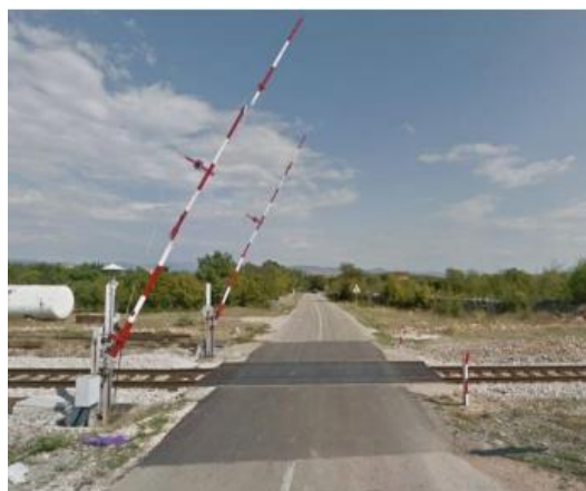
Slika 4. Osiguranje ŽCP-a branikom
