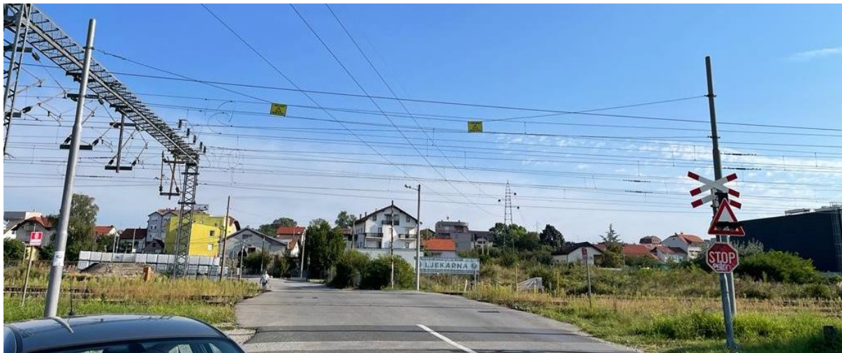
Slika 24. ŽCP Jelkovečka osiguran svjetlosno-zvučnom signalizacijom
