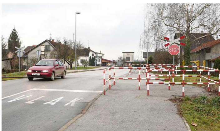
Slika 12. Pasivno osiguran željezničko-cestovni prijelaz
