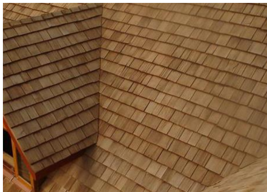
Slika 9. Ravno postavljena šindra
