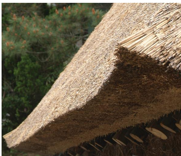
Slika 18. Streha pokrivena slamom
