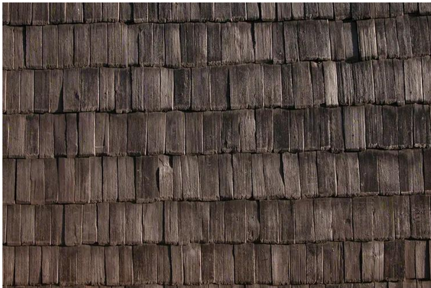
Slika 7. Drvena šindra kao pokrov
