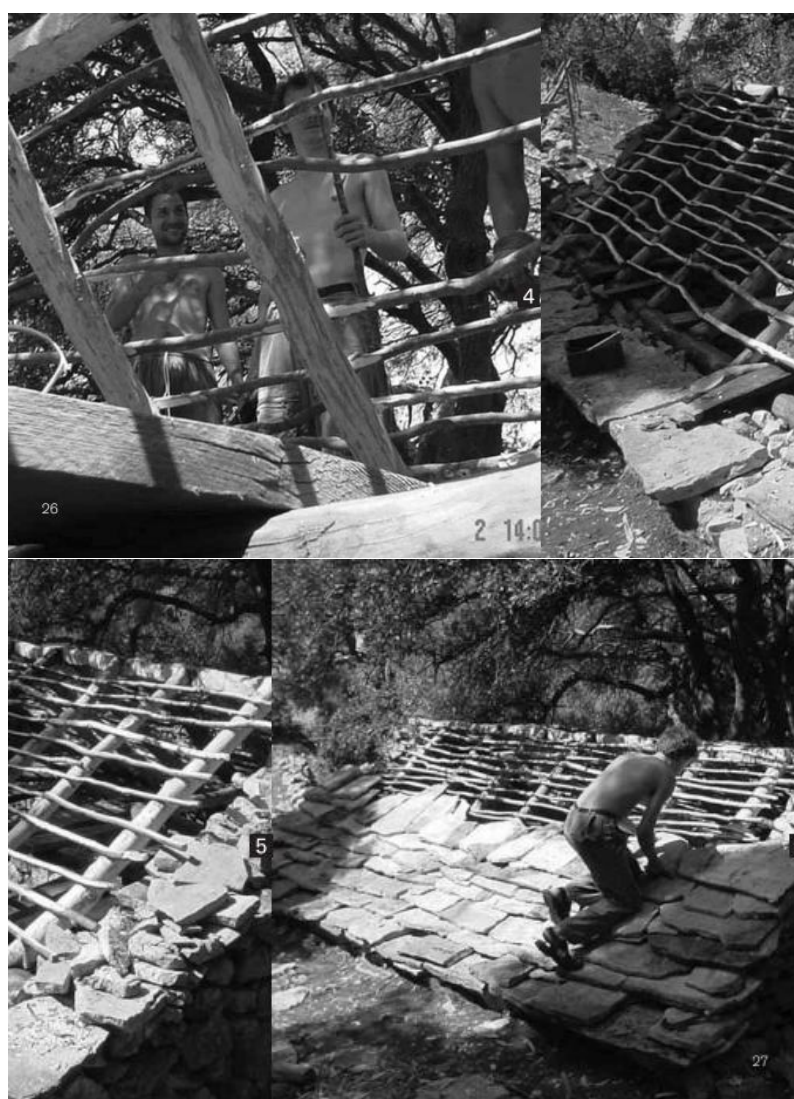
Slika 30. Izrada krovne konstrukcije i kamenog pokrova
