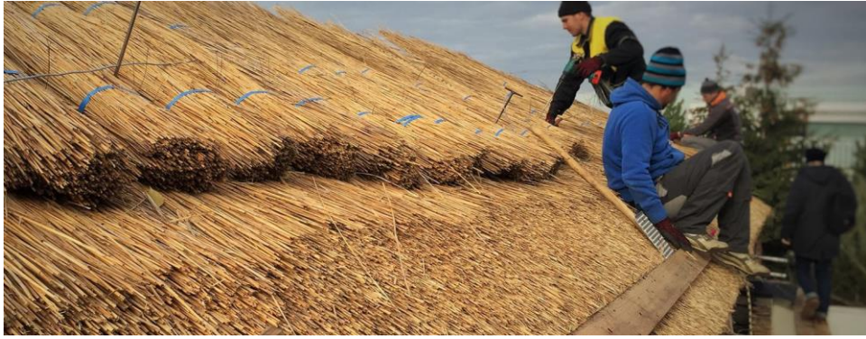
Slika 27. Pokrivanje krova trskom
