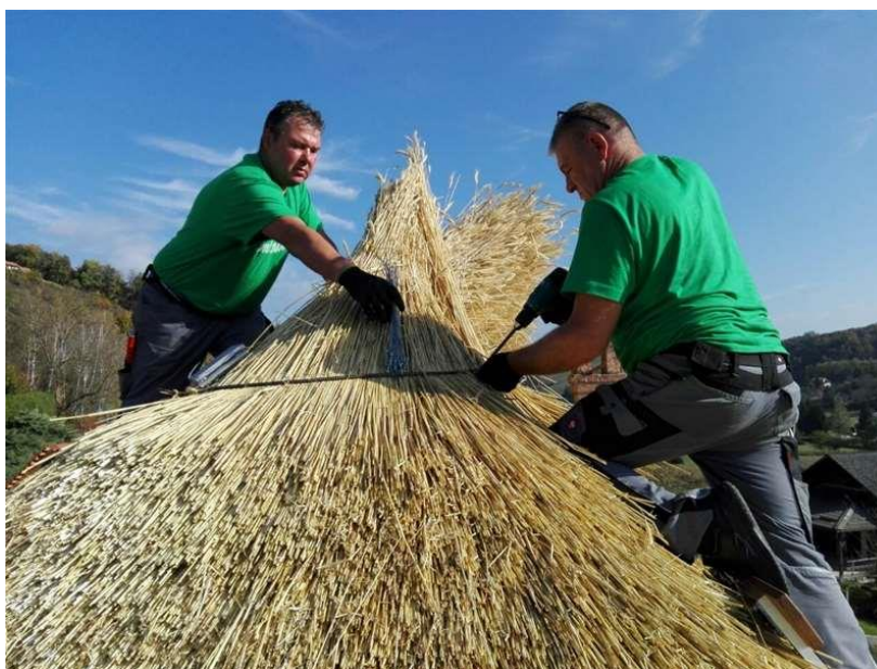
Slika 21. Edukacijska radionica pokrivanja slamom
