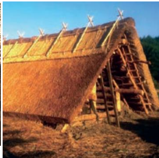
Slika 19. Pokrivanje sljemena slamom
