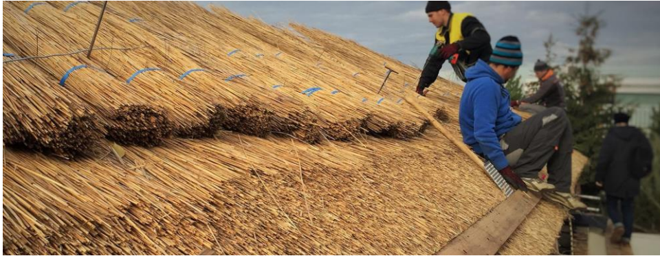
Slika 27. Pokrivanje krova trskom
