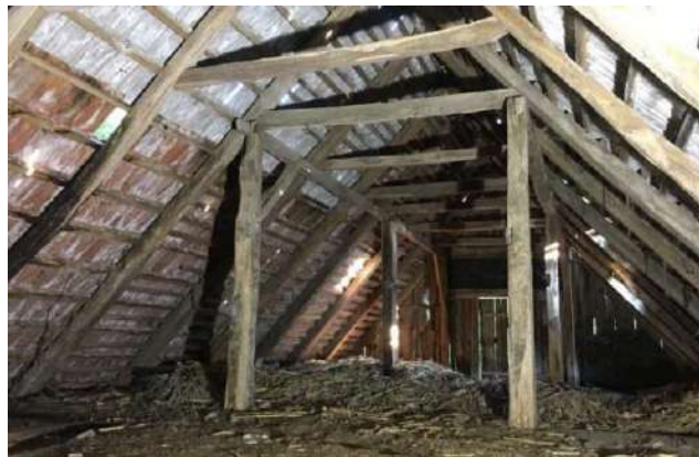
Slika 2.1 Tradicionalno drveno krovište
