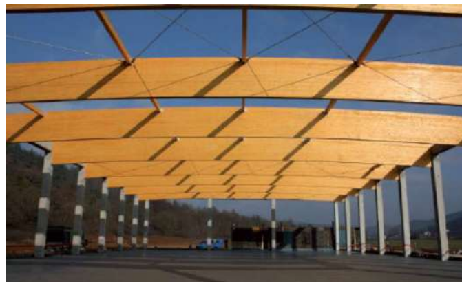
Slika 2.2 Suvremeno drveno krovište
