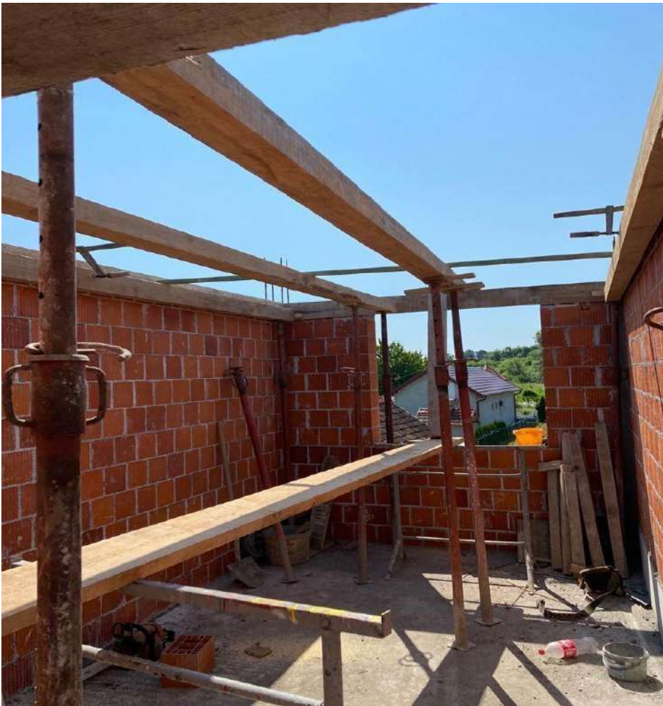
Slika 19. Postavljeni vertikalni stabilizatori i drveni rogovi
