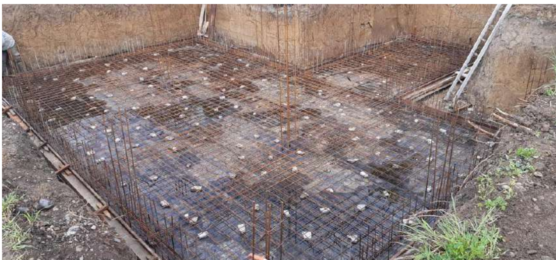
Slika 4. Hidroizolacija i postavljena armatura temeljne ploče
