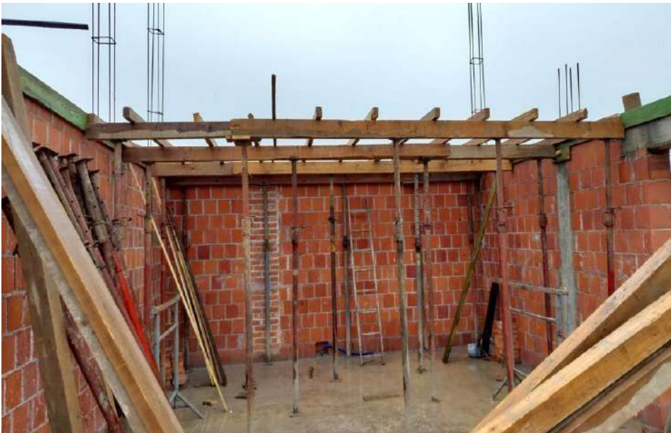
Slika 20. Postavljene drvene štifle
