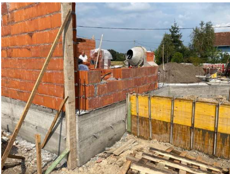
Slika 8. Zidanje nosivih zidova (prikaz s drugog gradilišta)
