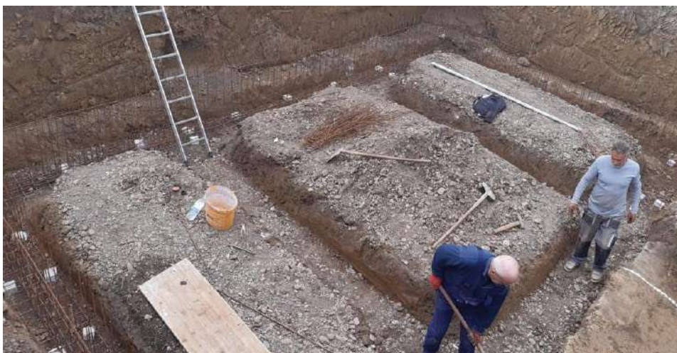
Slika 3. Građevna jama – ugradnja armature za temeljne trake
