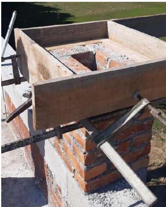
Slika 31. Oplata kape dimnjaka
