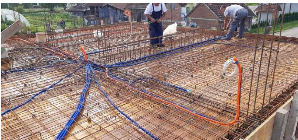
Slika 24. Armatura i oplatni sustav ploče, kontragrada i horizontalnih serklaža
