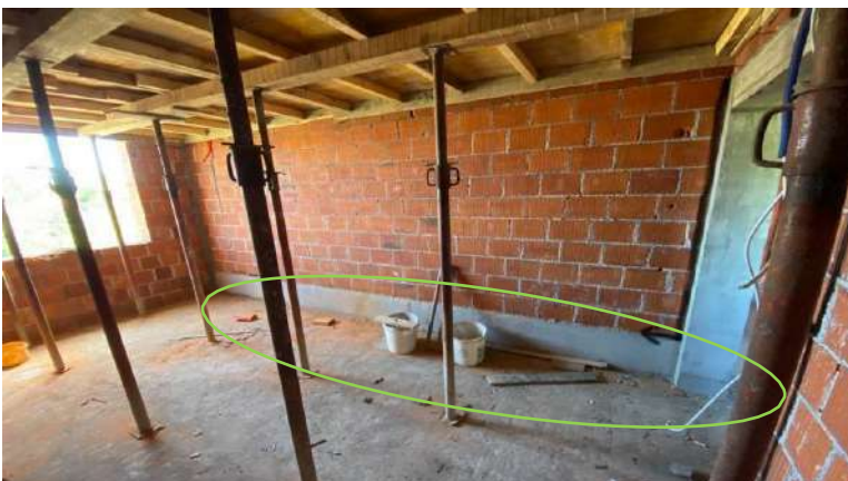
Slika 22. Izvedena kontragreda
