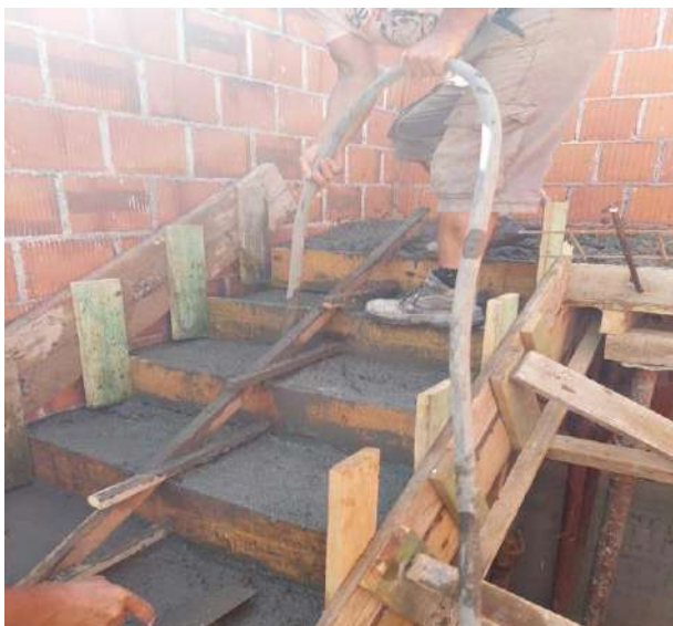
Slika 17. Betoniranje stepenica i vibriranje betona iglom
