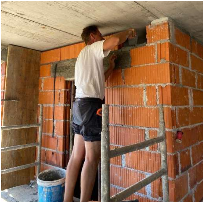
Slika 16. Zidanje iznad nadvoja
