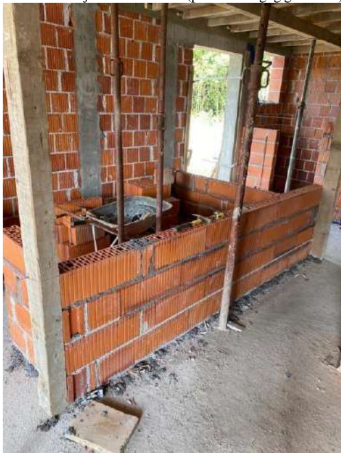
Slika 8. Zidanje nosivih zidova (prikaz s drugog gradilišta)
