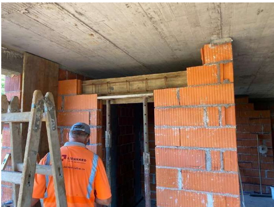
Slika 14. Postavljanje oplata nadvoja vrata
