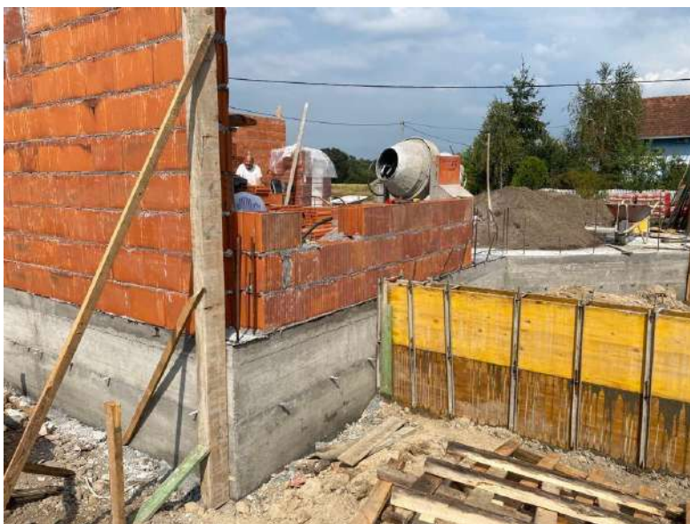
Slika 8. Zidanje nosivih zidova (prikaz s drugog gradilišta)
