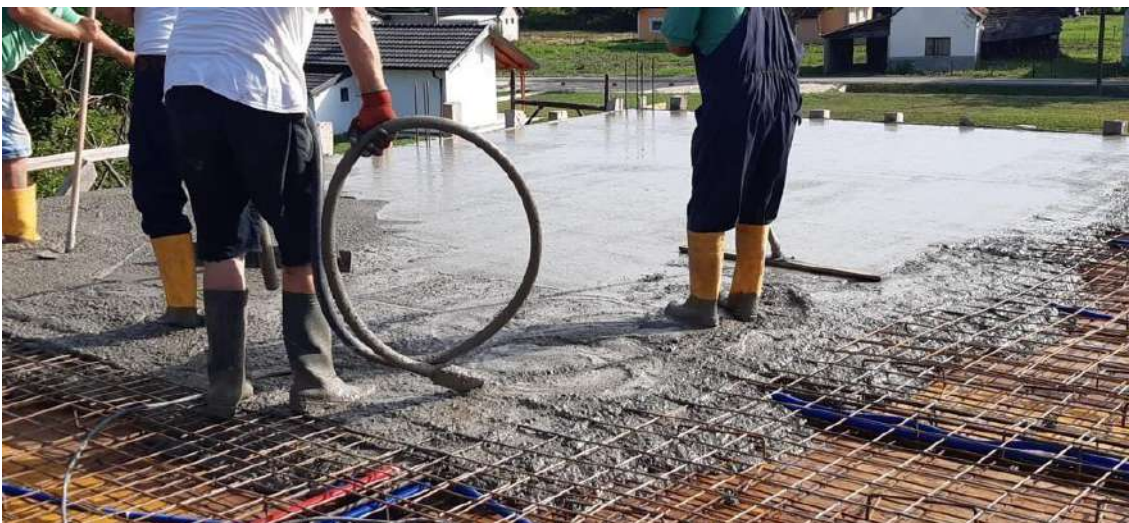
Slika 26. Vibriranje i ravnanje betona
