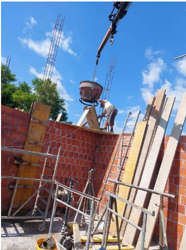
Slika 10. Ugradnja betona u vertikalni serklaž
