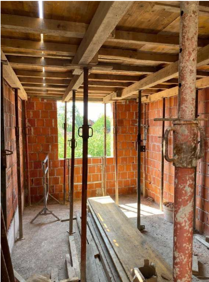
Slika 21. Kompletan oplatni sustav
