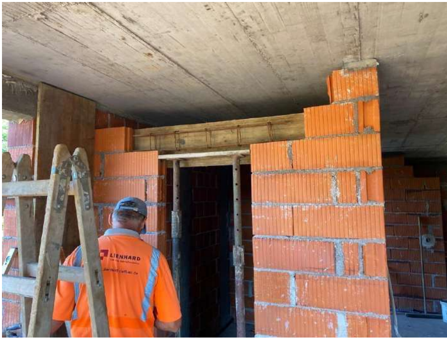
Slika 14. Postavljanje oplata nadvoja vrata
