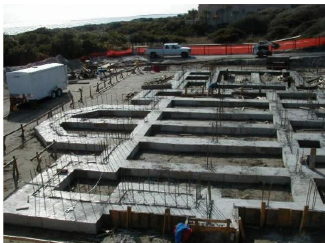
Slika 42 Postavljanje temeljnih traka
