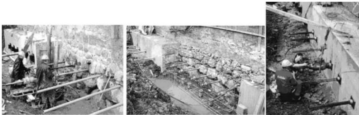
Slika 18 Detalji potpore pomoću pilota dvorca Malbork
