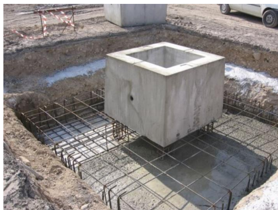
Slika 41 Predgotovljena temeljna čaka
