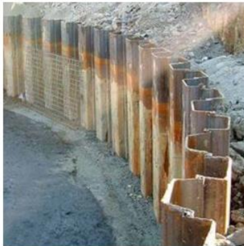
Slika 45 Pločasti piloti
