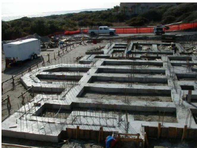
Slika 42 Postavljanje temeljnih traka
