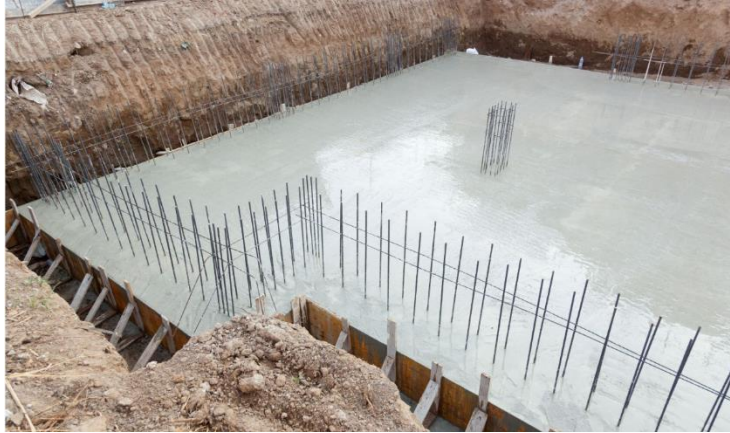
Slika 44 Temeljna ploča
