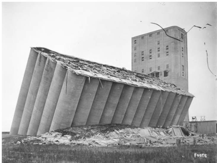
Slika 61 Kolaps Transcona Grain Elevatora
