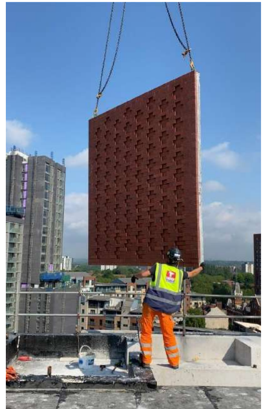
Slika 4.11. Montaža predgotovljenog panela s oblogom od opeke
