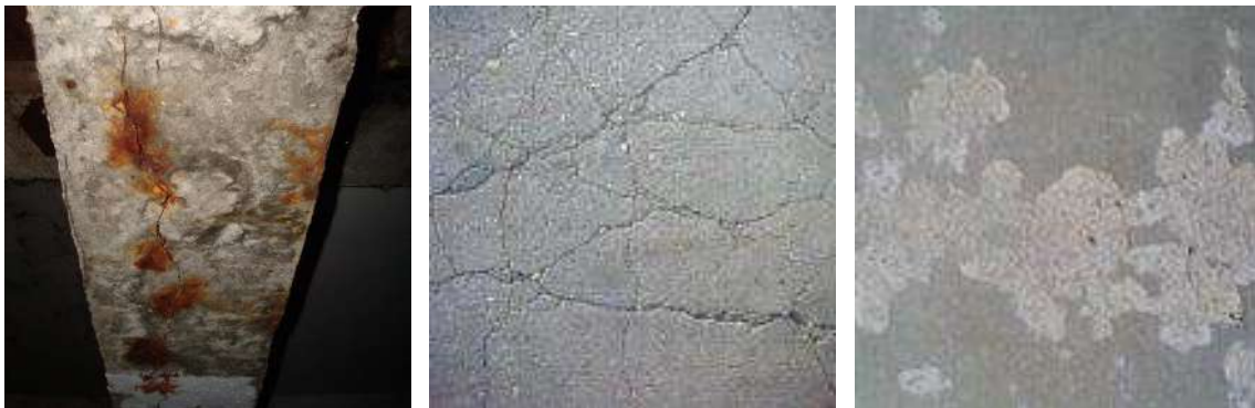
Slika 4.1. Oštećenja betona
