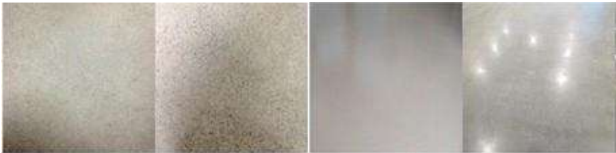
Slika 4.7. Stadiji poliranja betonskog elementa
