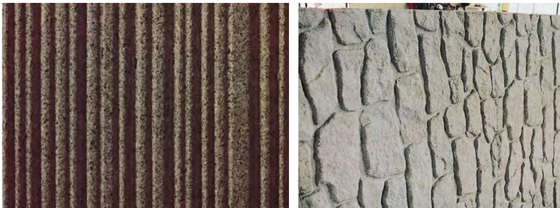
Slika 4.8. Oblikovanje površine uz pomoć silikonskih kalupa za betonske elemente
