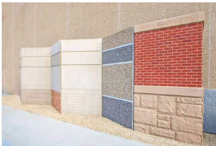
Slika 4.2. Varijacije završne obrade predgotovljenih armirano-betonskih elemenata
