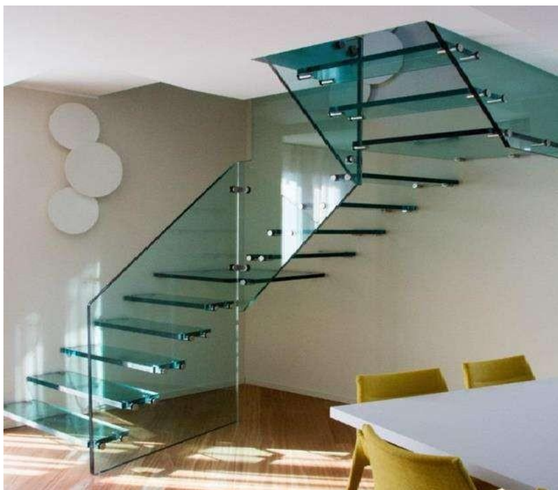
Slika 17. Primjer izvedbe ograde i gazišta od stakla [14]
