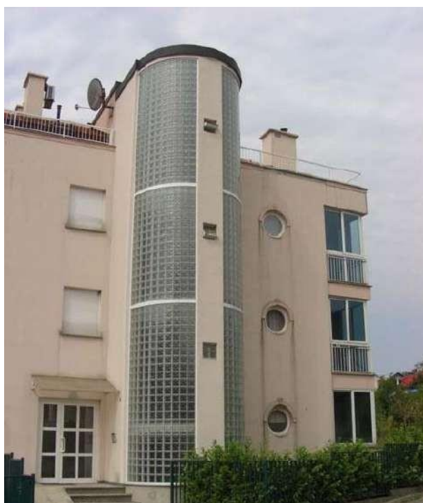
Slika 13. Dio pročelja stambene zgrade izveden od staklene opeke
