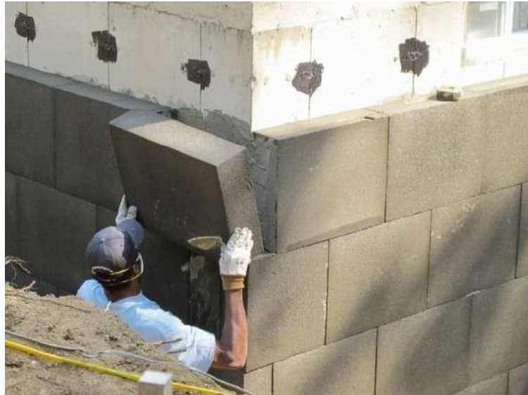
Slika 19. Izolacija fasade staklenom pjenom
