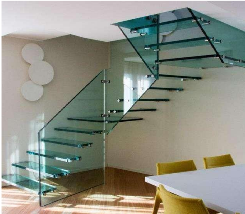
Slika 17. Primjer izvedbe ograde i gazišta od stakla [14]
