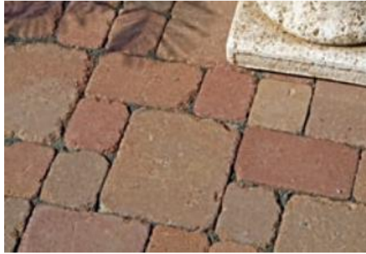
Slika 7: Otučena obrada opločnika [9]
