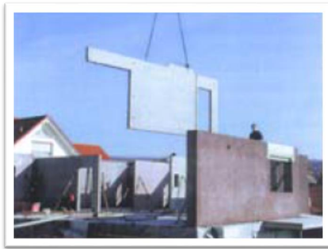
Slika 20 Predgotovljeni zidni element od laganog betona [8]
