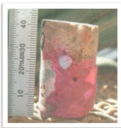
Slika 18 Ispitivanje dubine karbonatizacije fenolftaleinom [1]
