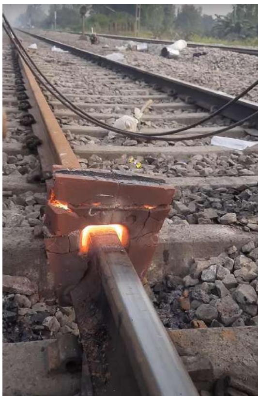
Slika 3.13. Zavareni spoj nakon skidanja kalupa [13]
