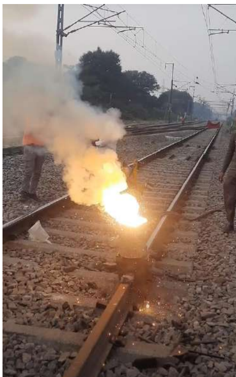
Slika 3.12. Aluminotermijski postupak zavarivanja tračnica [13]
