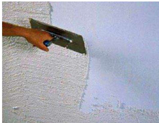
Slika 10. Nanošenje završno dekorativne žbuke
