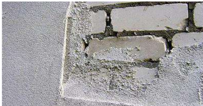
Slika 1. Vapneno – cementna žbuka
