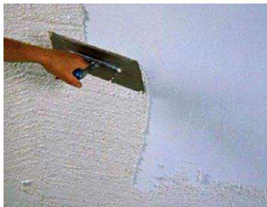
Slika 10. Nanošenje završno dekorativne žbuke
