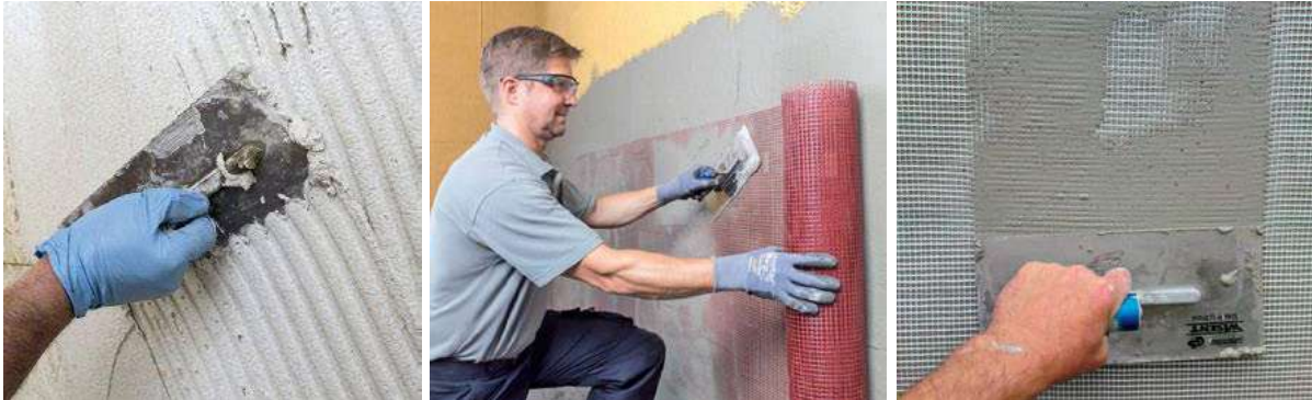
Slika 9. Nanošenje temeljnog polimer-cementnog sloja na mineralnu vunu (lijevo), utiskivanje staklene mrežice (desno)
