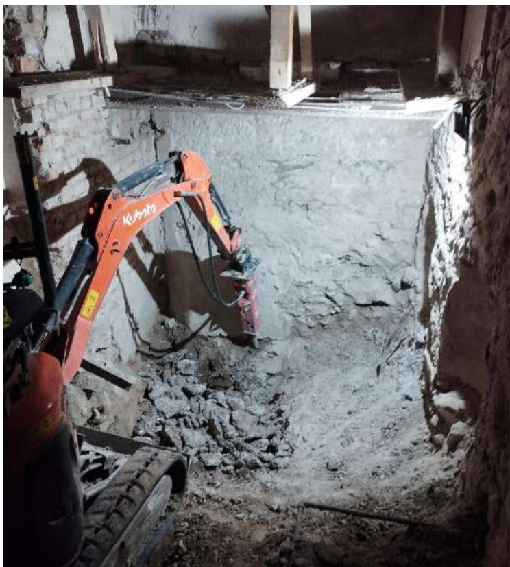
Slika 20 Tijek izvođenja nove temeljne ploče za ugradnju lifta
