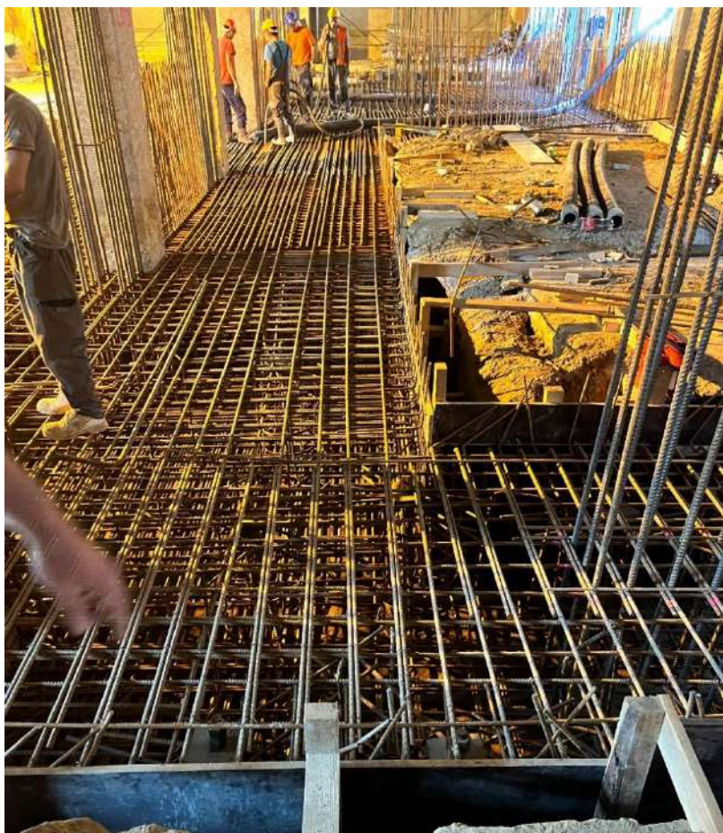
Slika 34 Armatura nove betonske ploče
