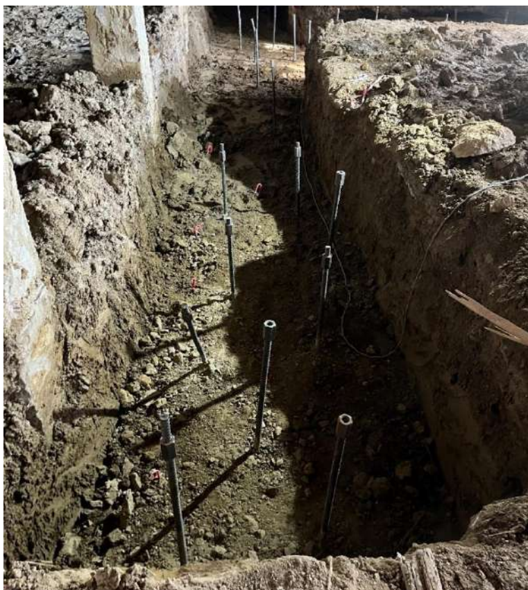
Slika 31 Armatura jet-grouting pilota
