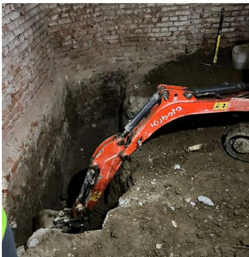
Slika 24 Iskop pomoću minibagera
