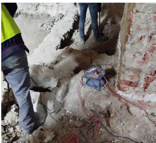
Slika 21 Uklanjanje betonske podne ploče
