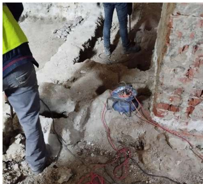
Slika 21 Uklanjanje betonske podne ploče
