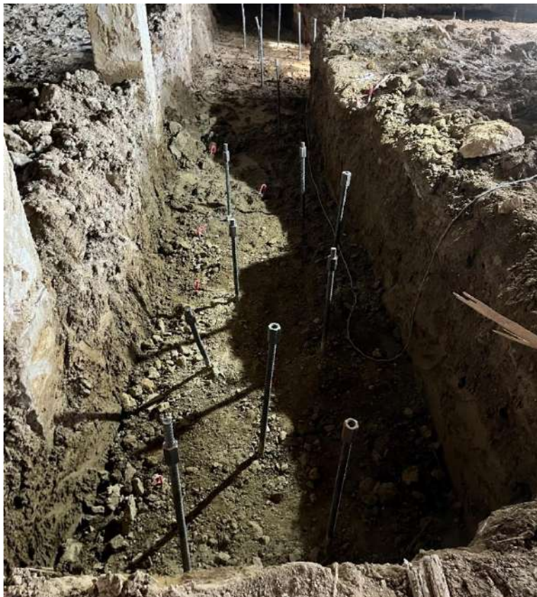
Slika 31 Armatura jet-grouting pilota
