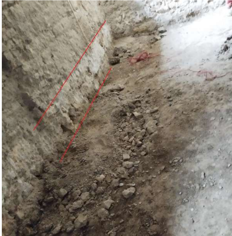
Slika 22 Prikaz stanja nakon uklonjene podne ploče
