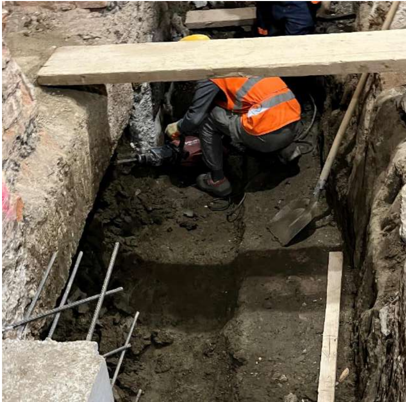
Slika 25 Ručni iskop
