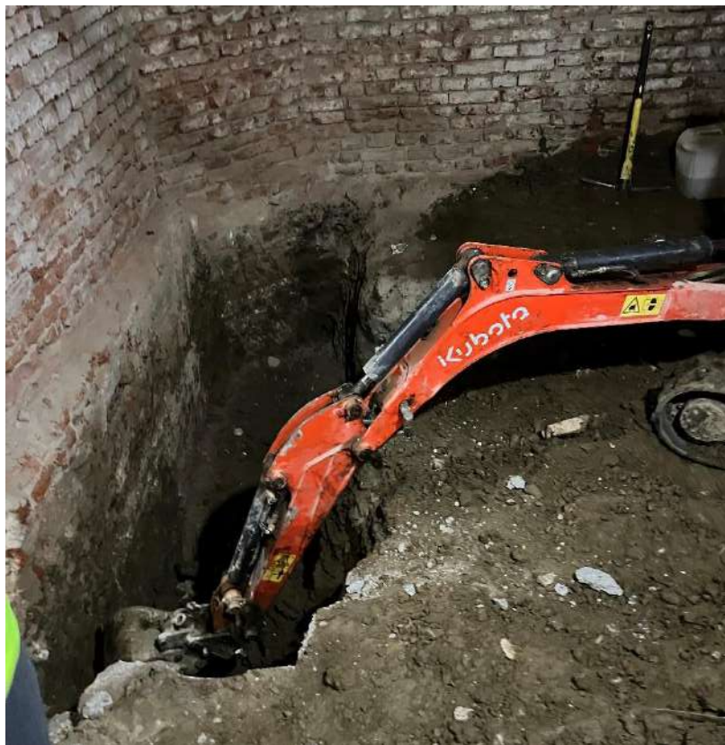
Slika 24 Iskop pomoću minibagera
