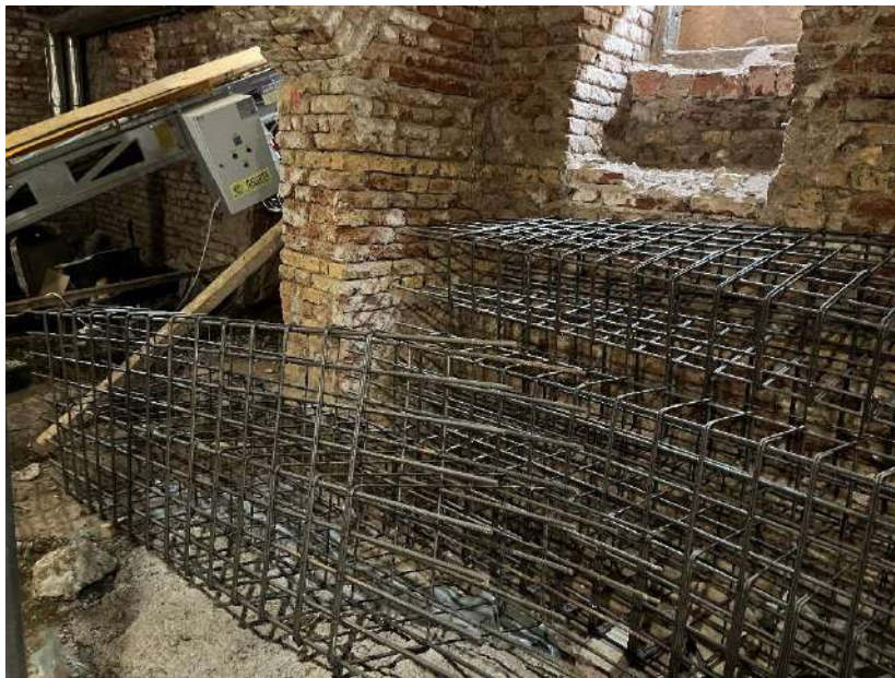
Slika 27 Armatura koja se ugrađuje
