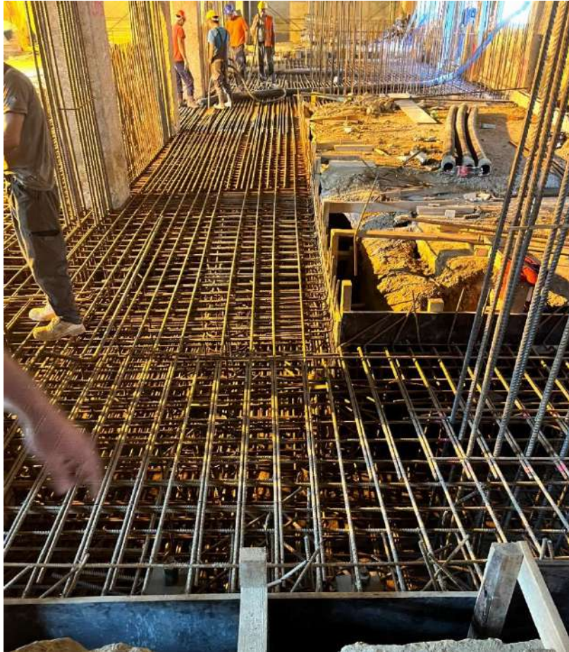
Slika 34 Armatura nove betonske ploče
