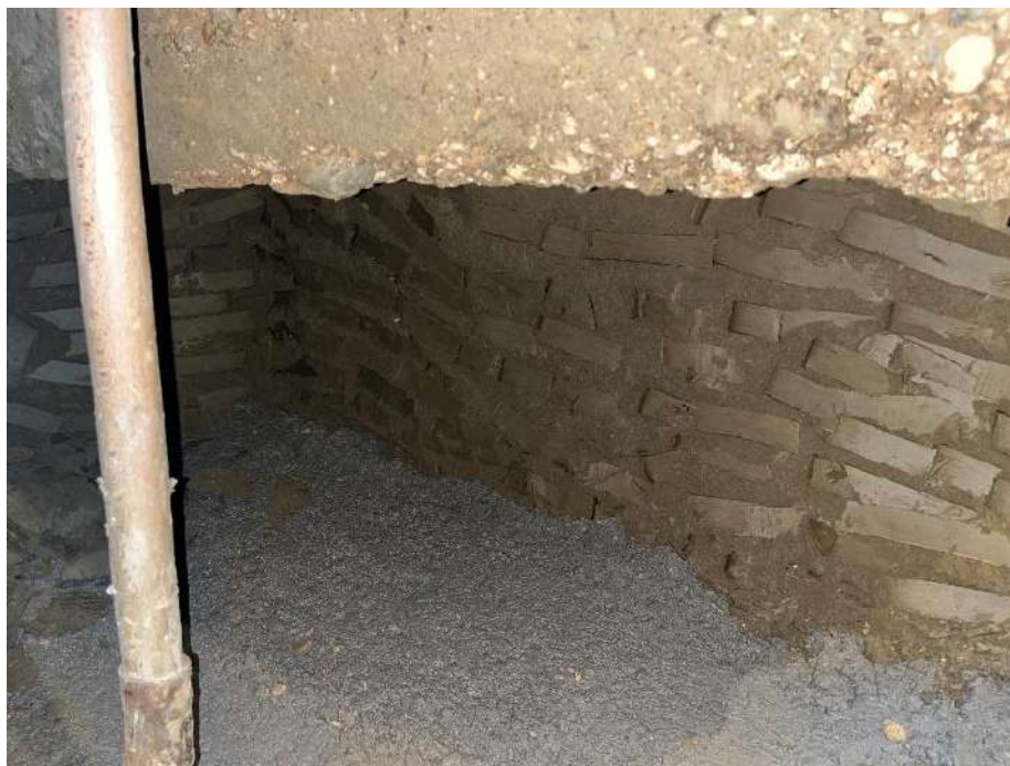
Slika 29 Iskopano područje ispod temelja
