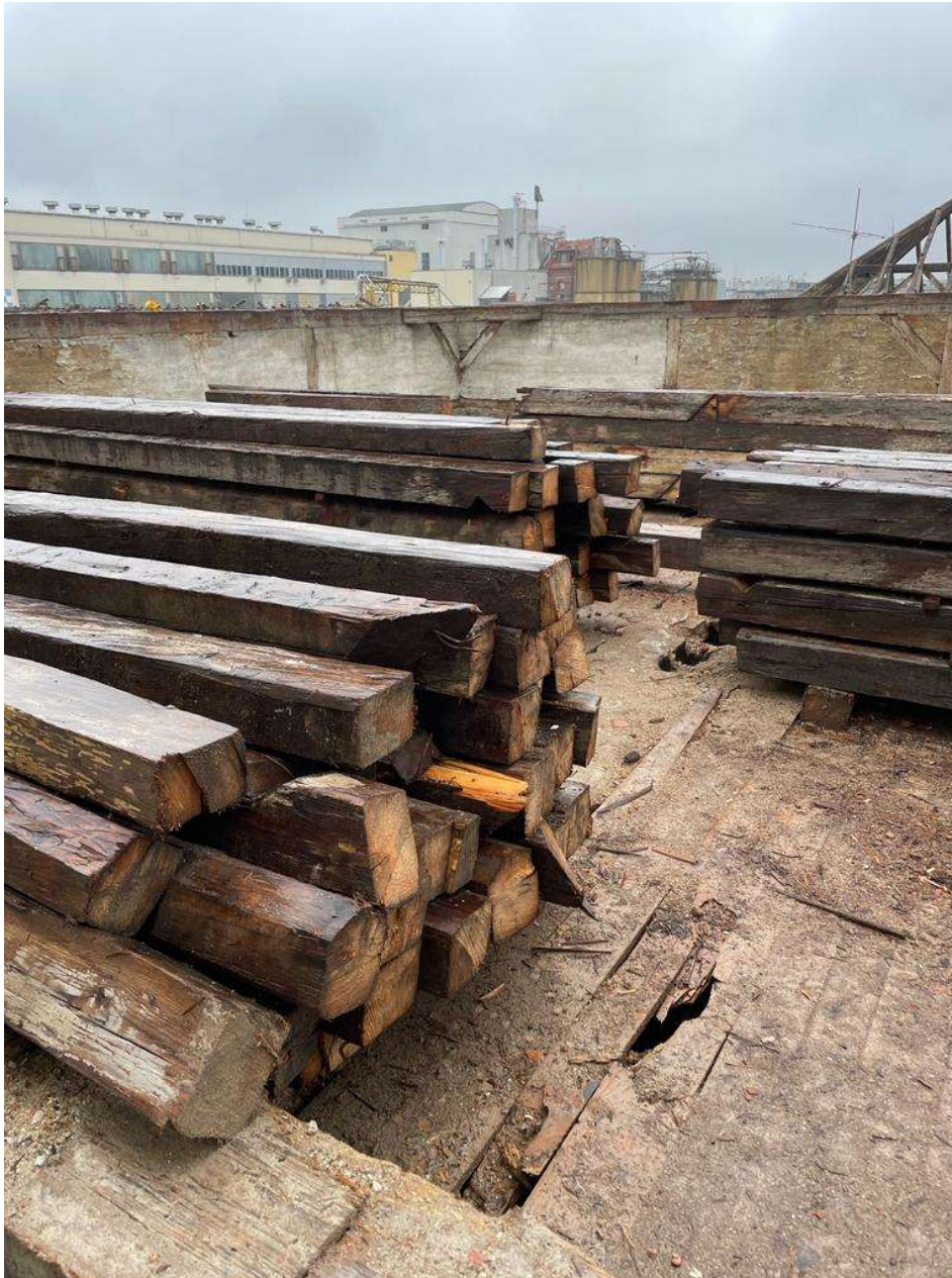
Slika 6 Drvene grede krovišta
