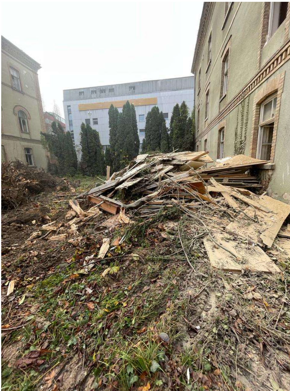
Slika 7 Razvrstavanje otpada na gradilištu 1
