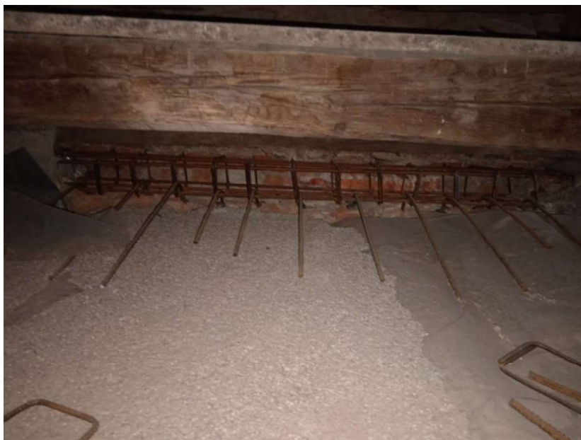
Slika 33 Armatura za horizontalne serklaže i sidrene šipke
