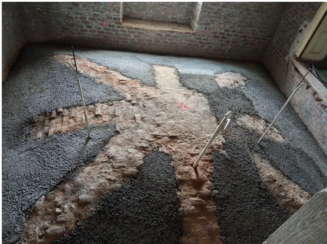
Slika 45 Popunjavanje praznina sa laganim betonom
