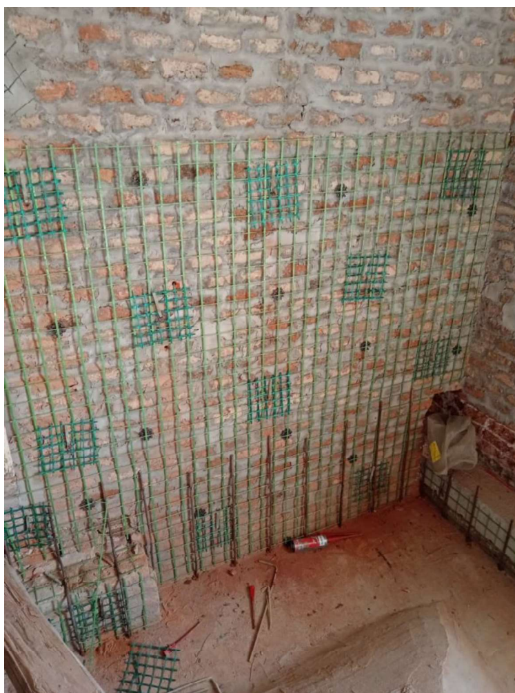
Slika 27 Postavljanje mreža i konektora na zidove
