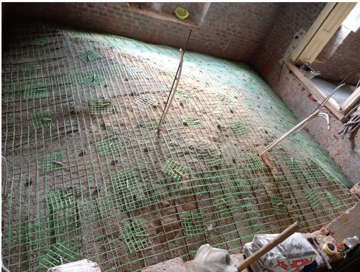
Slika 28 Postavljanje mreža i konektora na svodove
