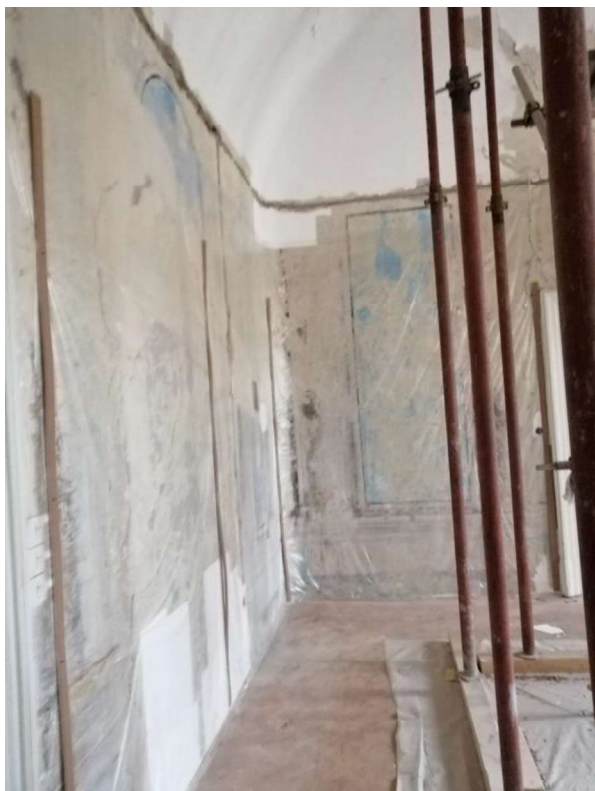
Slika 51 Zaštita oslika na zidovima
