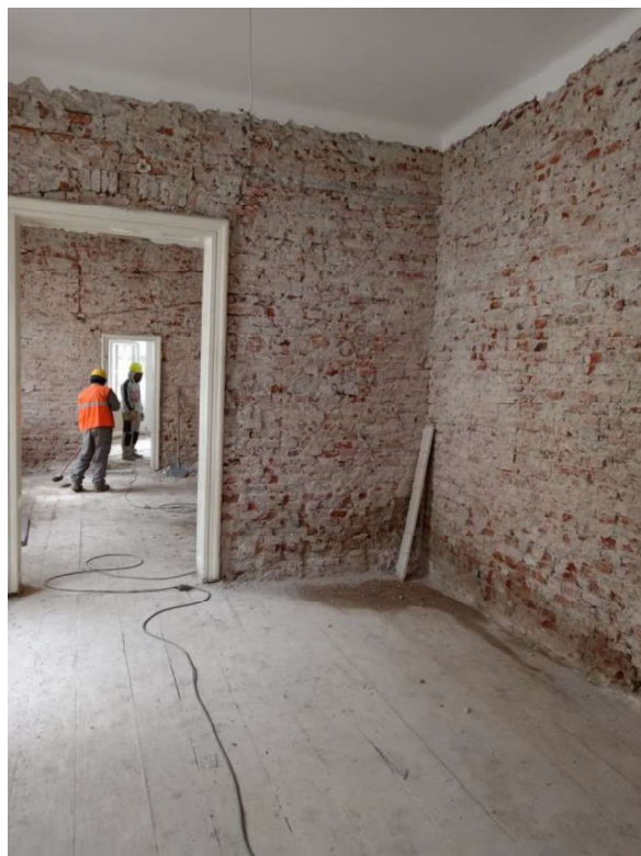
Slika 10 Obijanje žbuke na 1.katu
