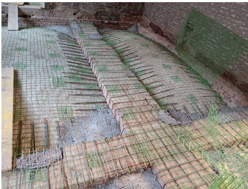
Slika 49 Prikaz rješenja CRM sustava sa dodatnim ojačanjem
