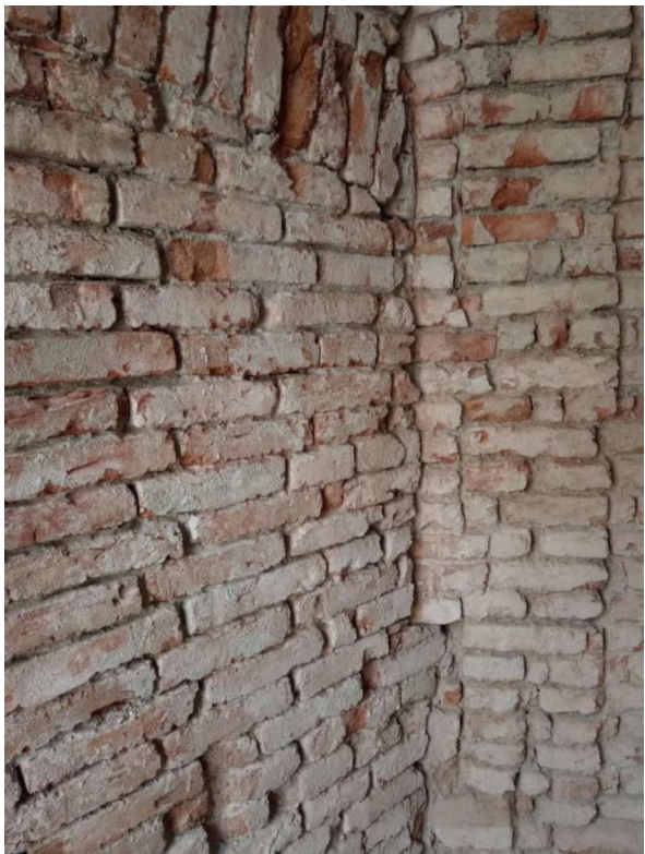
Slika 23 Čiščenje sljubnica
