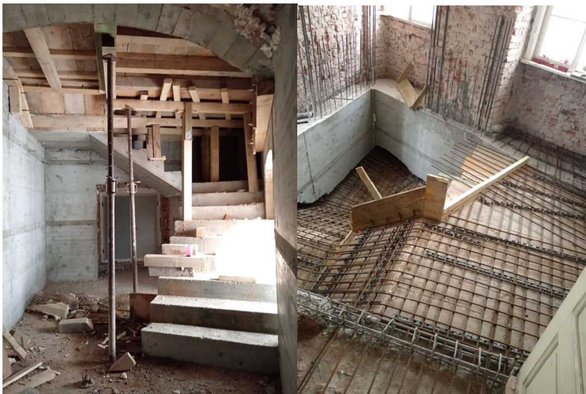
Slika 20 Prikaz izrade AB stubišta
