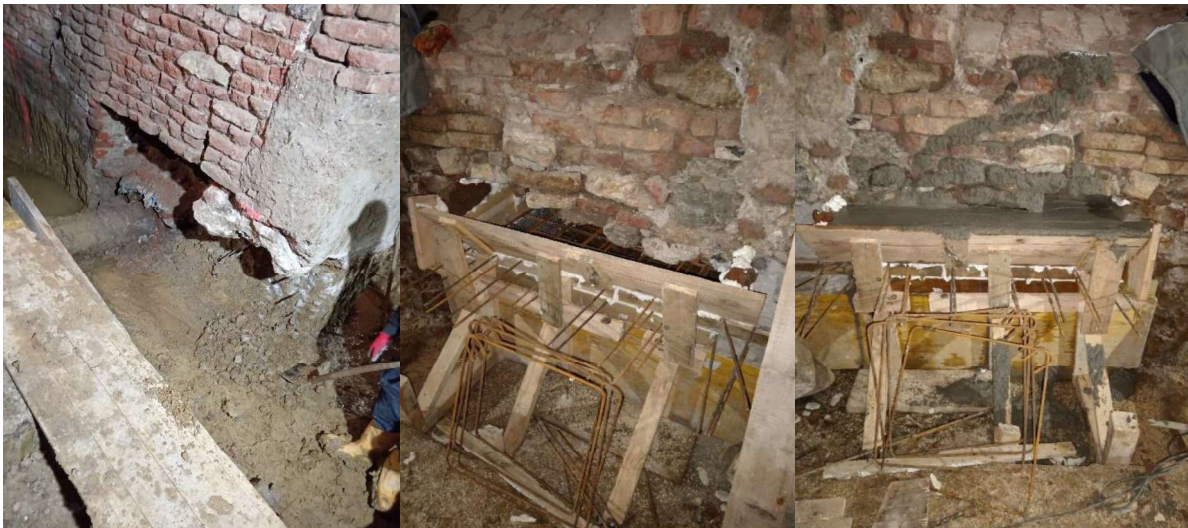
Slika 39 Slijed podbetoniranja temelja podruma
