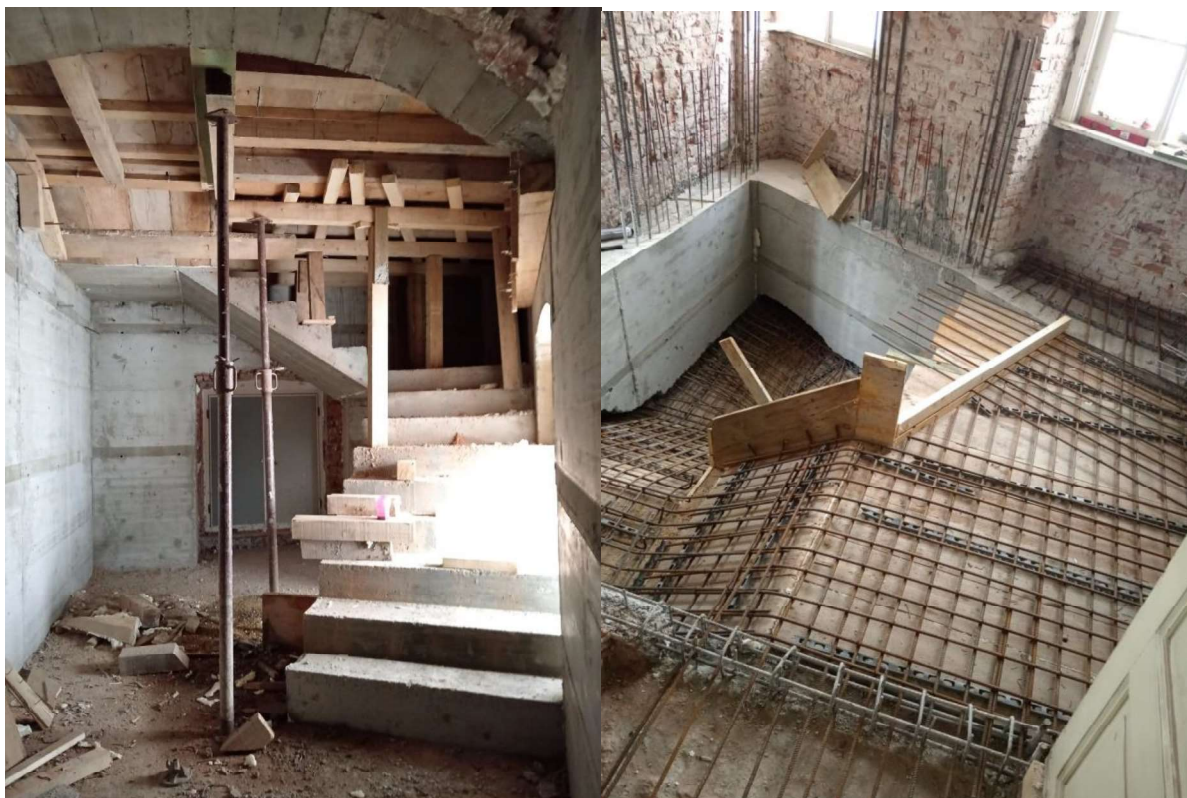
Slika 20 Prikaz izrade AB stubišta
