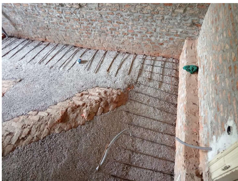
Slika 25 Čelične šipke za mreže svodova
