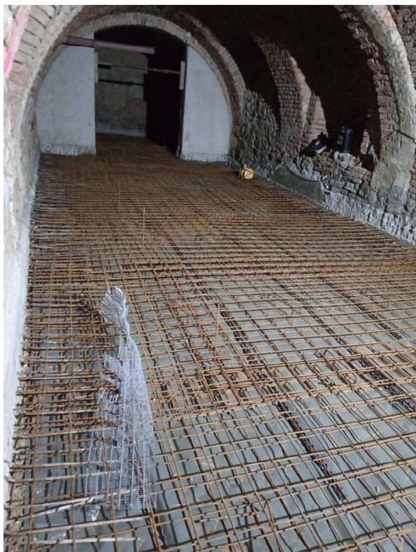
Slika 42 Armatura za betonsku ploču podruma
