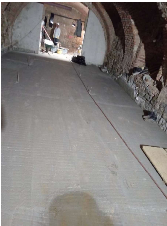
Slika 43 Betonska ploča podruma
