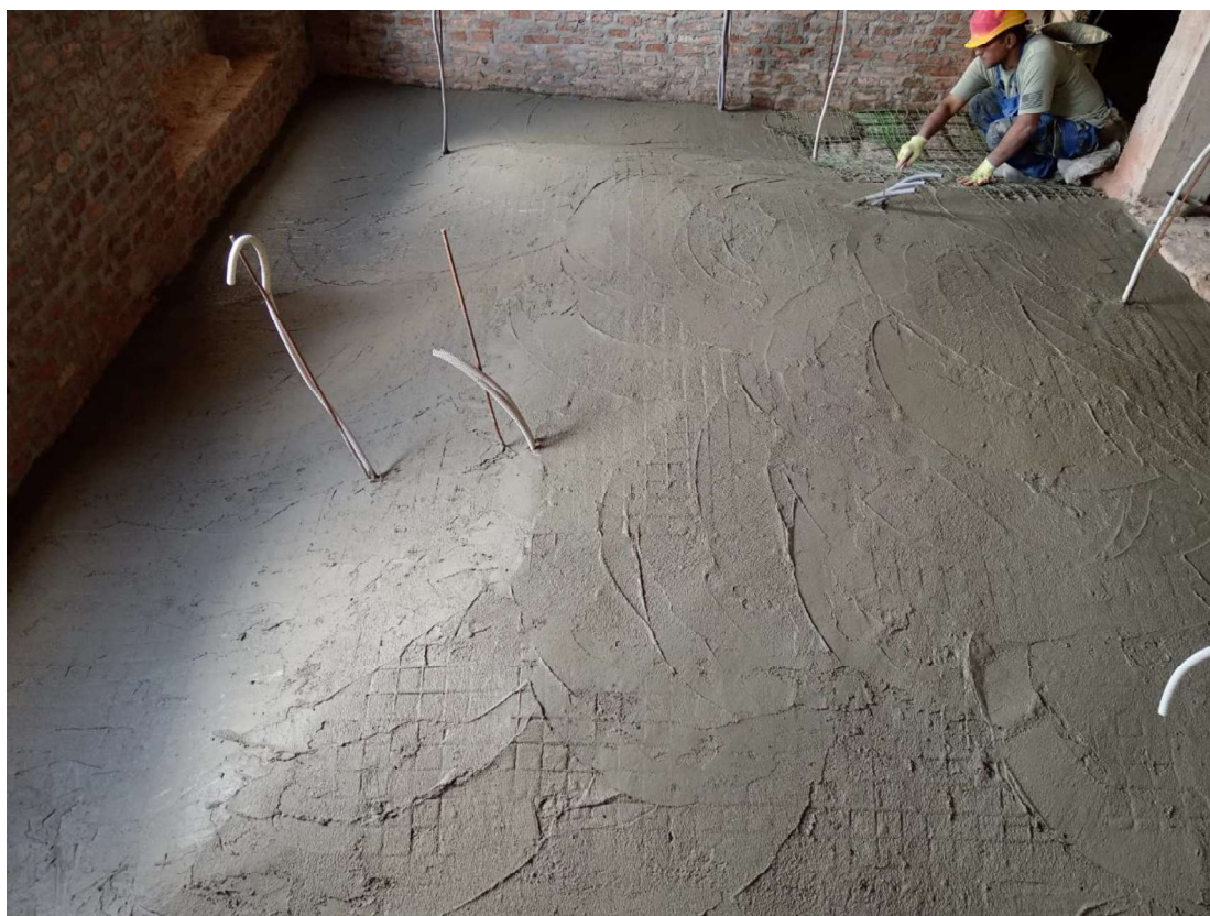
Slika 30 Nanošenje slojeva žbuke na svodove
