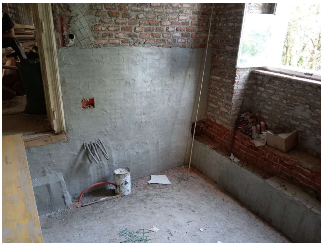
Slika 29 Nanošenje slojeva žbuke na zidove
