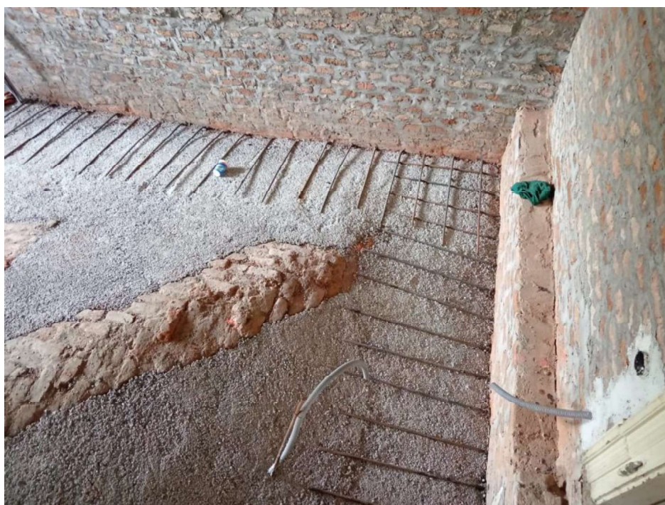
Slika 25 Čelične šipke za mreže svodova
