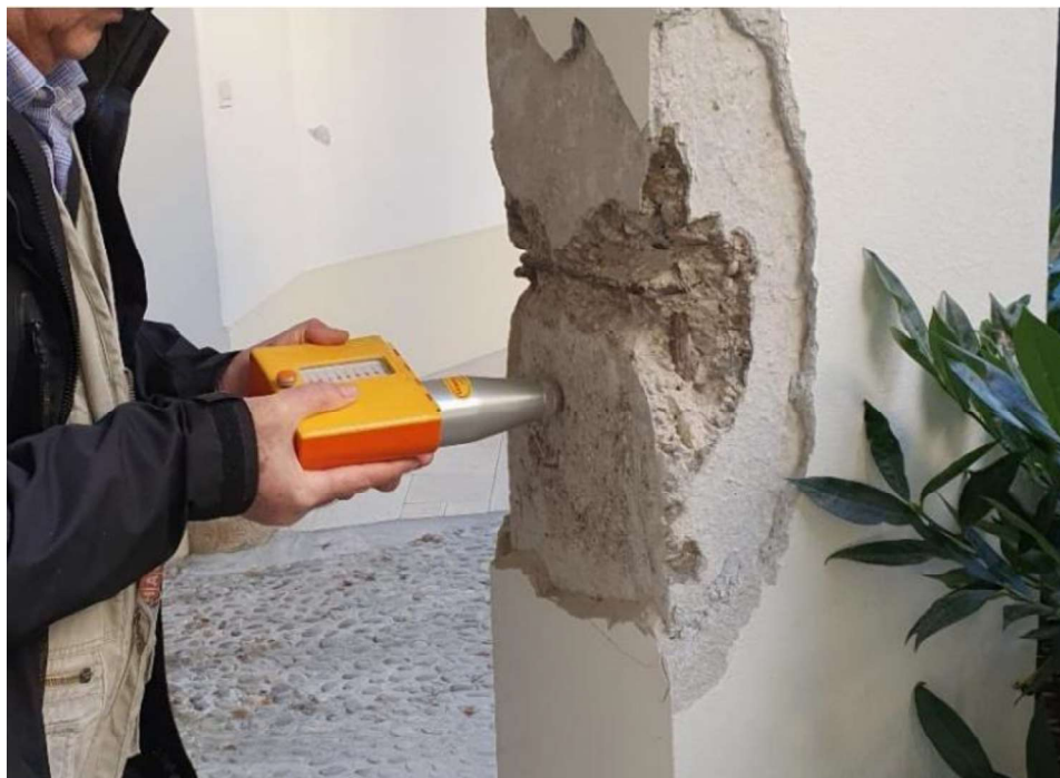
Slika 9 Ispitivanje kvalitete betona sklerometrom(Duvnjak,2021)
