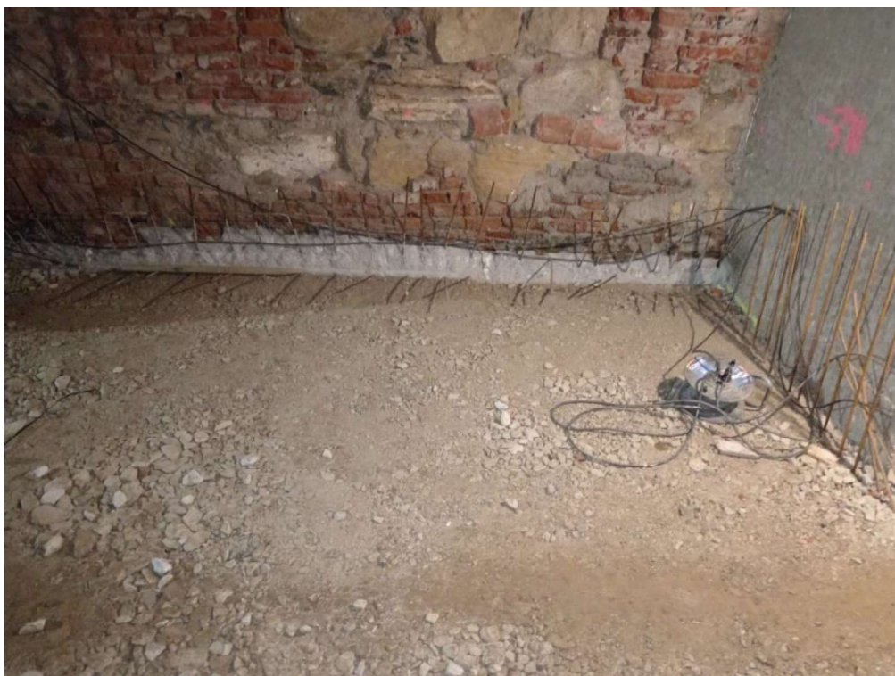
Slika 41 Priprema podloge za betoniranje ploče
