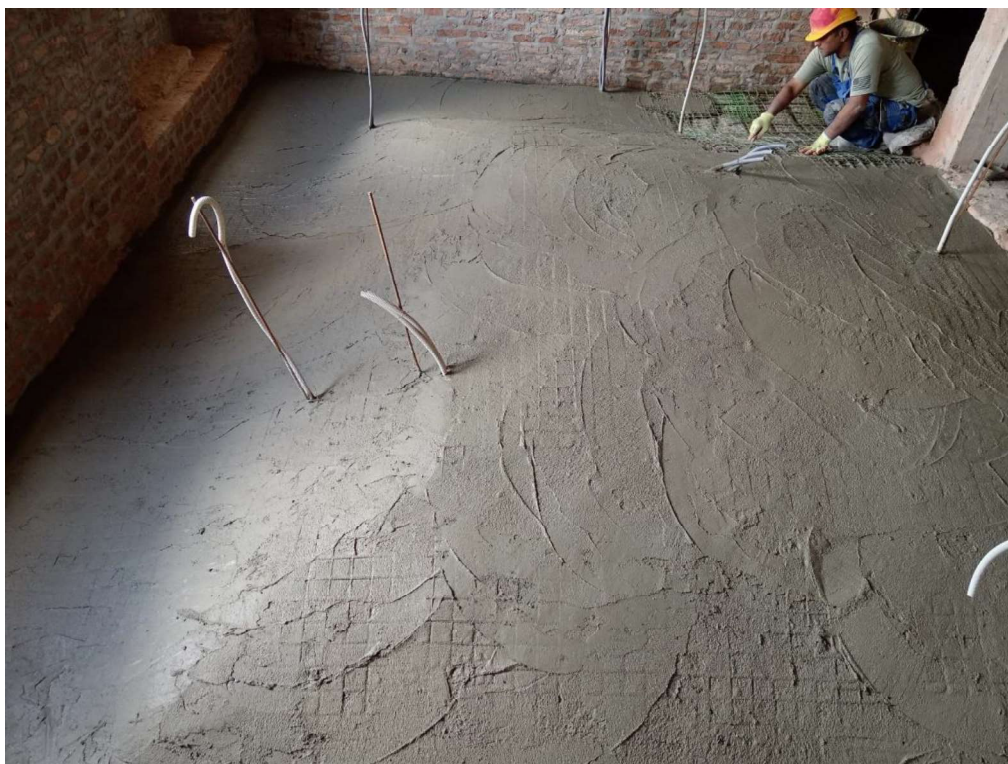
Slika 47 Završna obrada CRM sustava na svodovima
