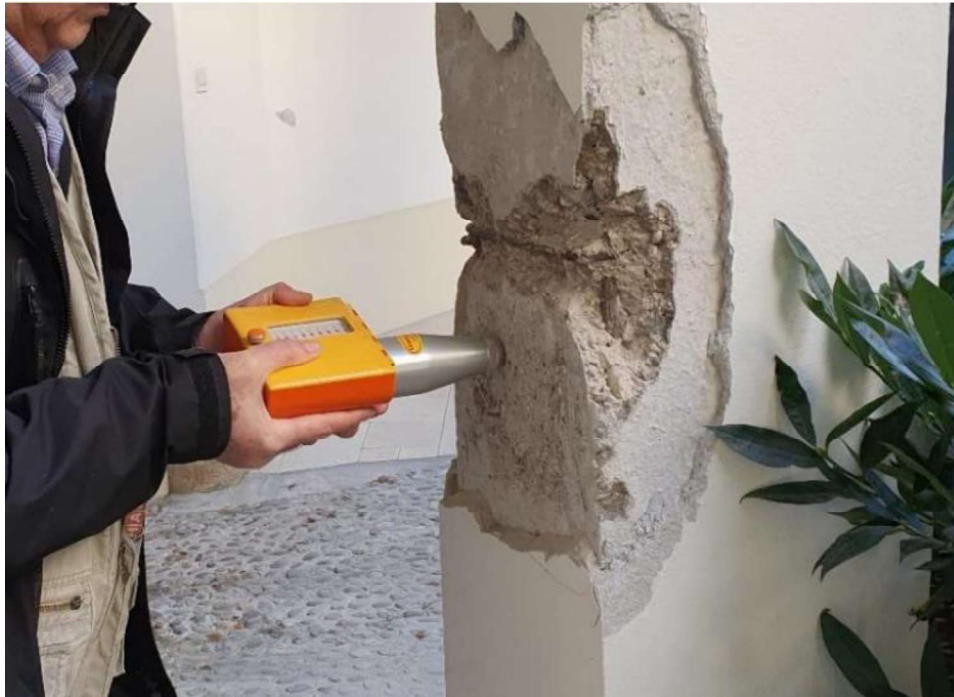
Slika 9 Ispitivanje kvalitete betona sklerometrom(Duvnjak,2021)
