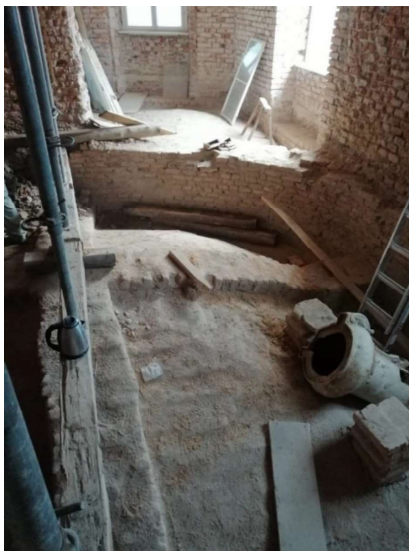
Slika 15 Proces uklanjanja šute na 2. katu
