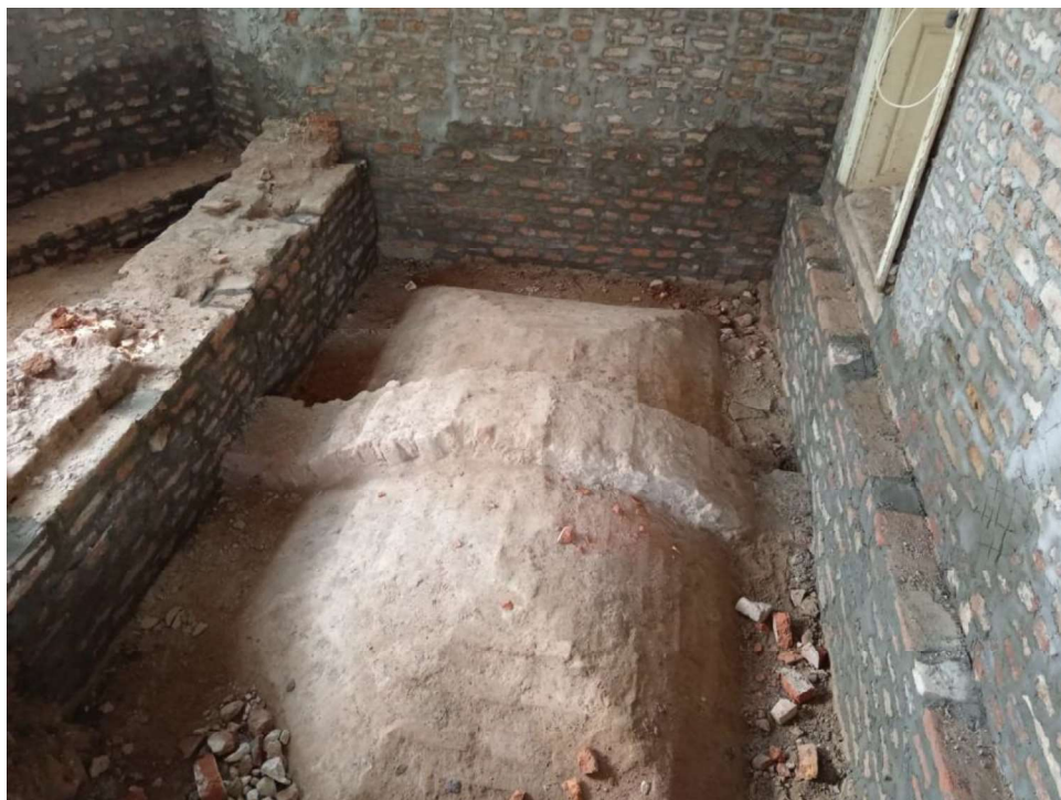
Slika 35 Uklanjanje slojeva šute na 2.katu
