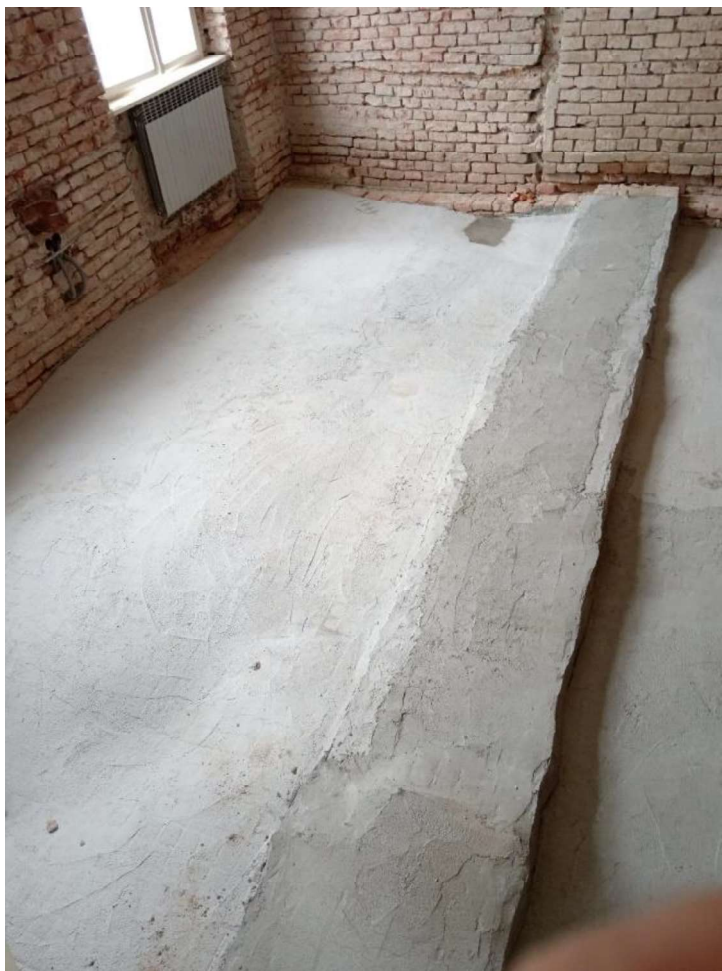
Slika 50 Završna obrada CRM sustava sa dodatnim ojačanjem
