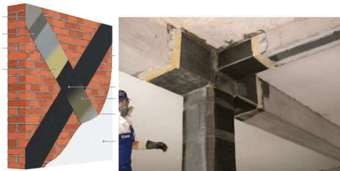
Slika 32 Primjeri ugradnje FRP sustava
