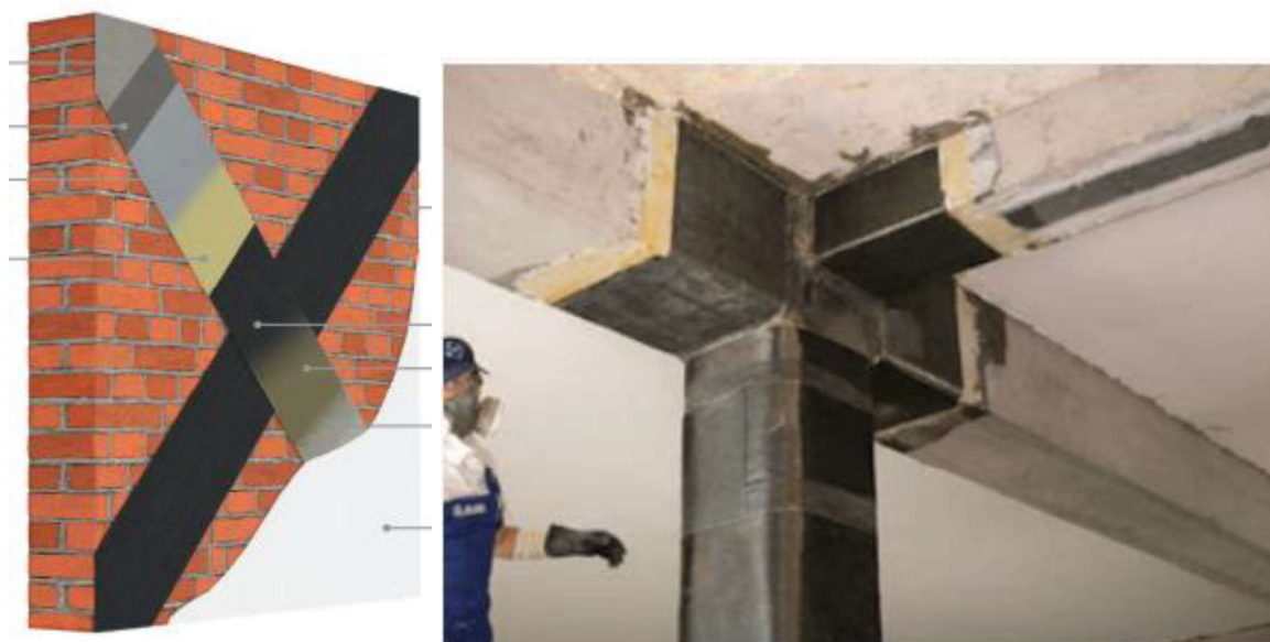
Slika 32 Primjeri ugradnje FRP sustava
