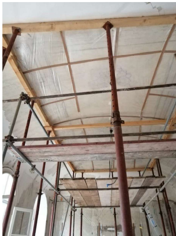
Slika 52 Zaštita oslika na stropovima
