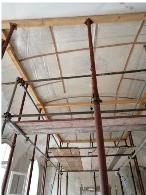
Slika 11 Zaštita oslika na stropu 1.kata
