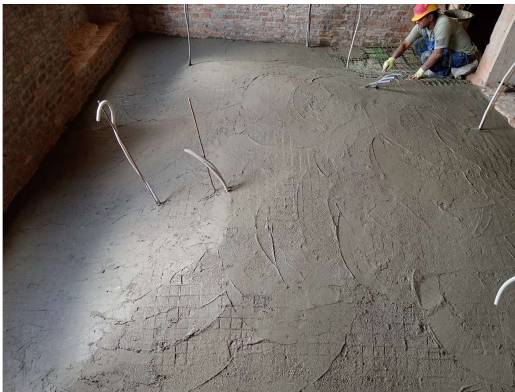
Slika 47 Završna obrada CRM sustava na svodovima
