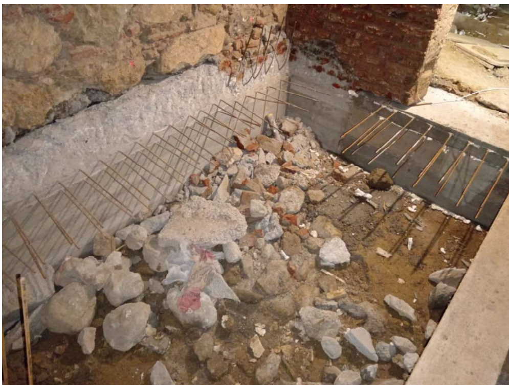
Slika 40 Završetak podbetoniranja
