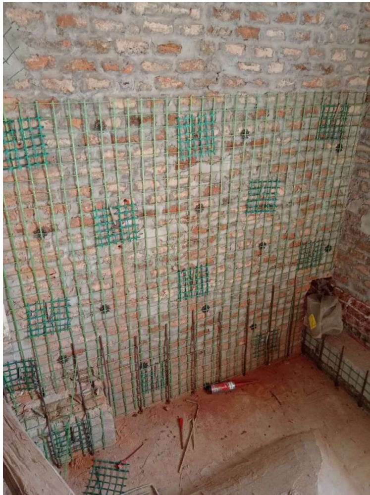
Slika 27 Postavljanje mreža i konektora na zidove
