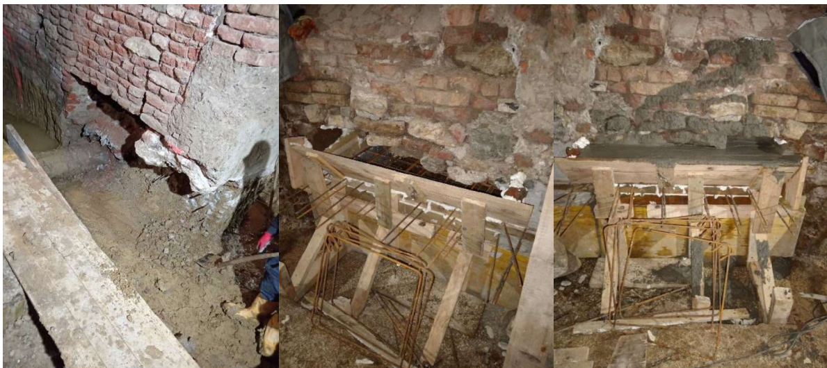
Slika 39 Slijed podbetoniranja temelja podruma
