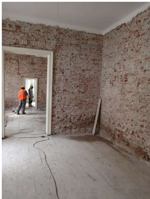
Slika 10 Obijanje žbuke na 1.katu
