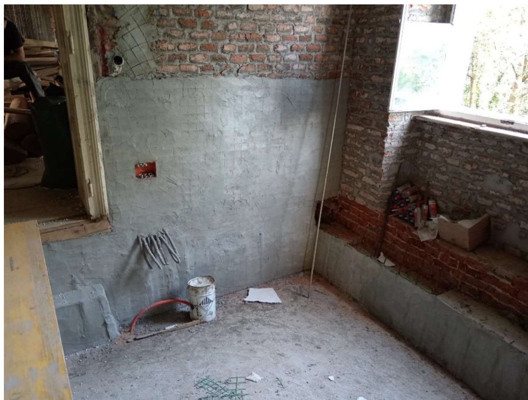
Slika 29 Nanošenje slojeva žbuke na zidove
