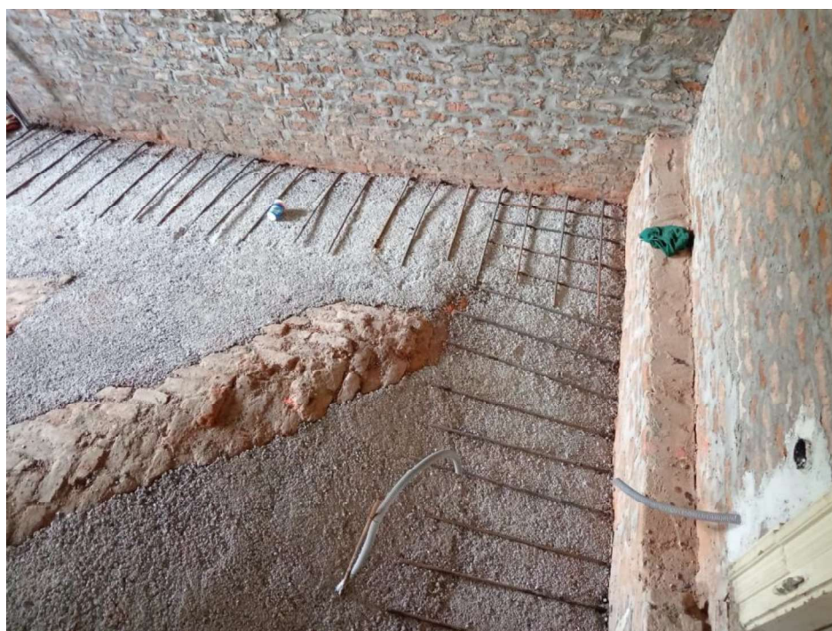
Slika 25 Čelične šipke za mreže svodova
