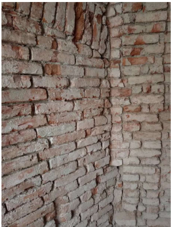
Slika 23 Čiščenje sljubnica
