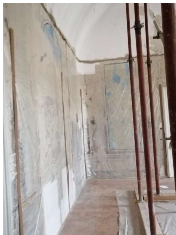
Slika 12 Zaštita oslika na zidovima 1.kata
