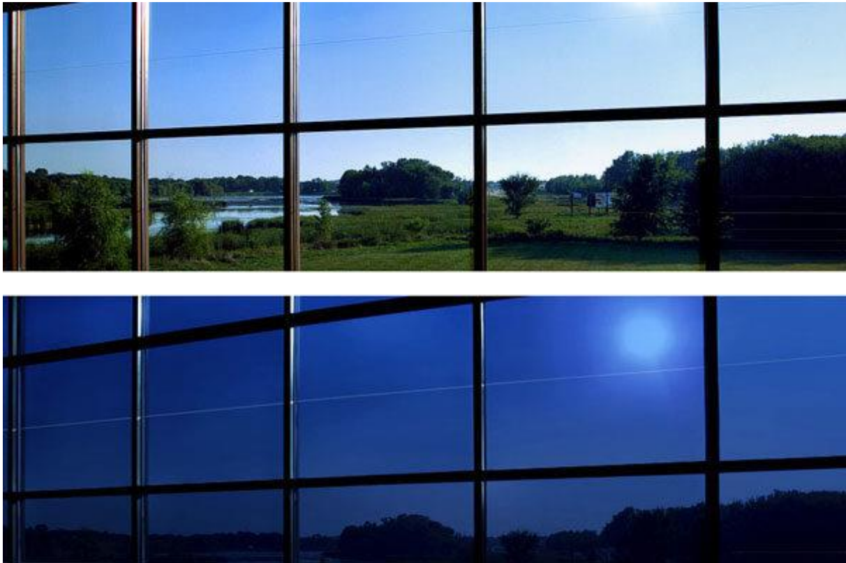
Slika 50 Prikaz SPD uključenog i isključenog stakla [57]
