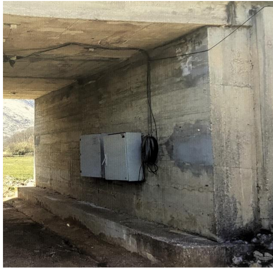
Slika 7 Instalirani prijenosni SiWIM uređaj na mostu [1]
