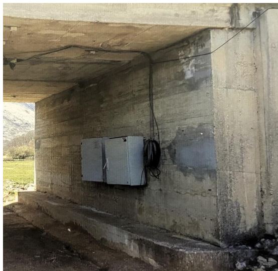
Slika 7 Instalirani prijenosni SiWIM uređaj na mostu [1]
