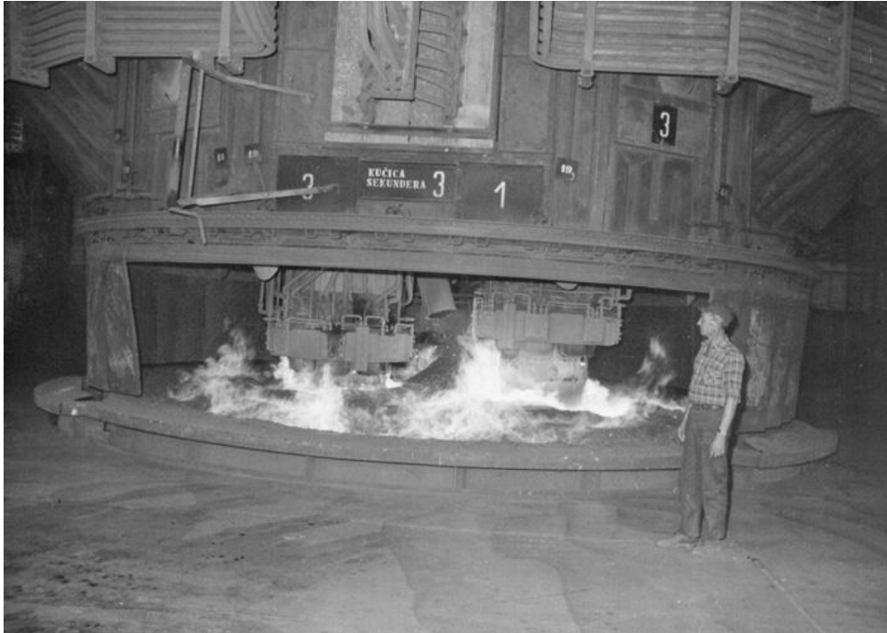
Sl. 2 Gornji sloj peći za proizvodnju ferolegura, druga polovica XX. st
