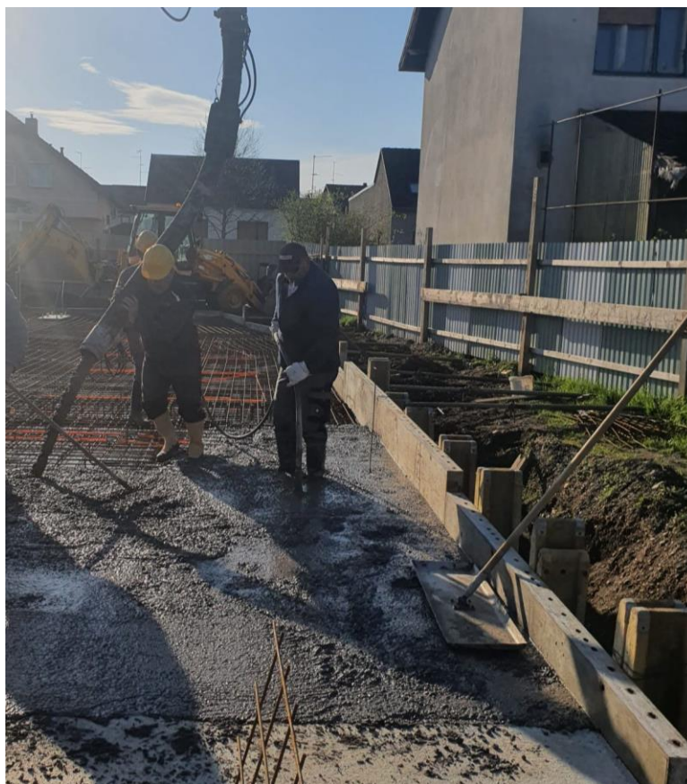
Slika 45. Vibriranje betonske mase
