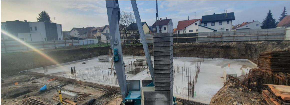
Slika 28. Izbetonirana temeljna ploča prvog dijela
