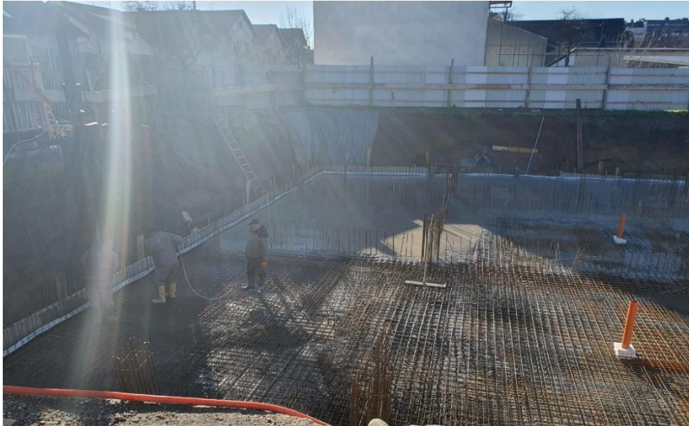
Slika 26. Betoniranje drugog dijela temeljne ploče ujutro
