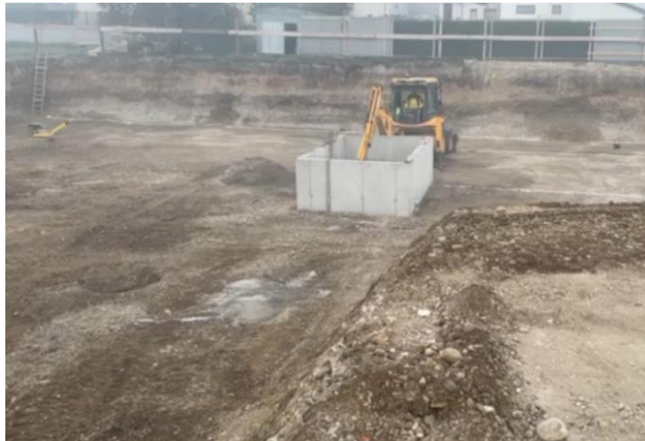
Slika 21. Kopanje unutar izbetoniranog okna dizala
