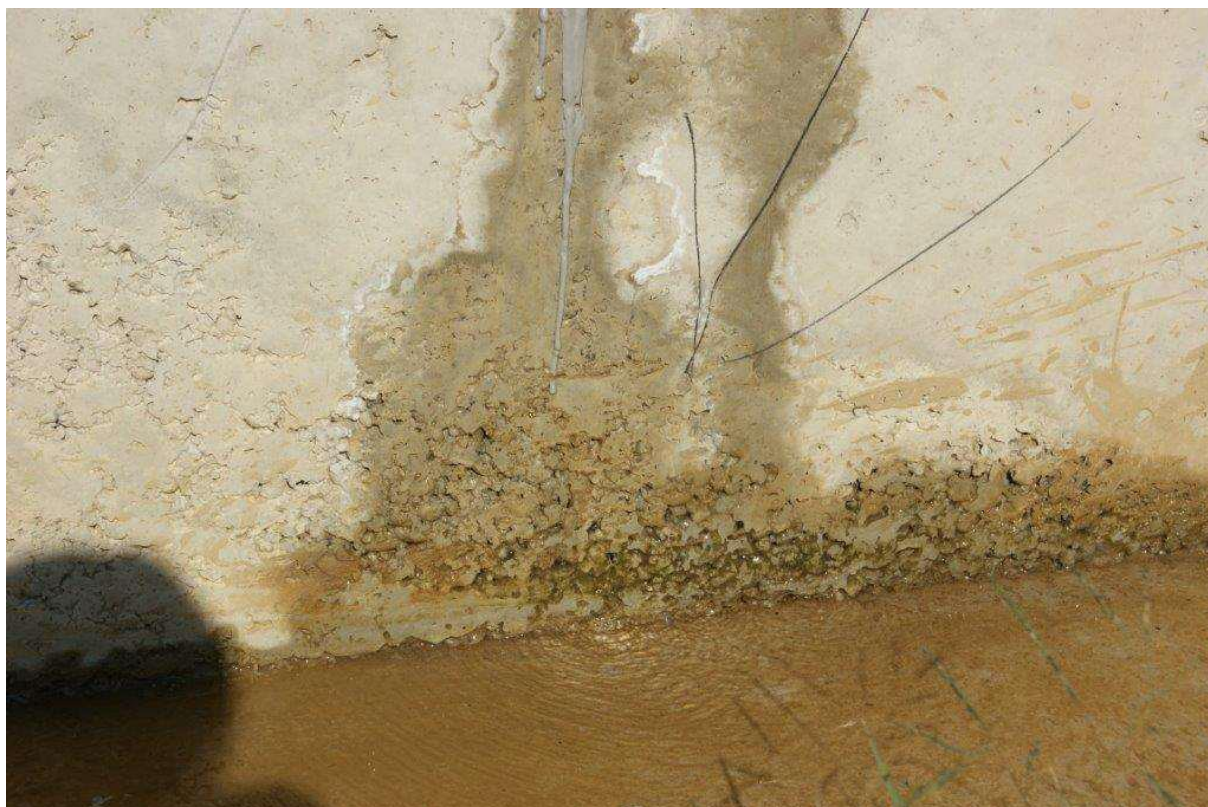
Slika 8. Segregacija betona
