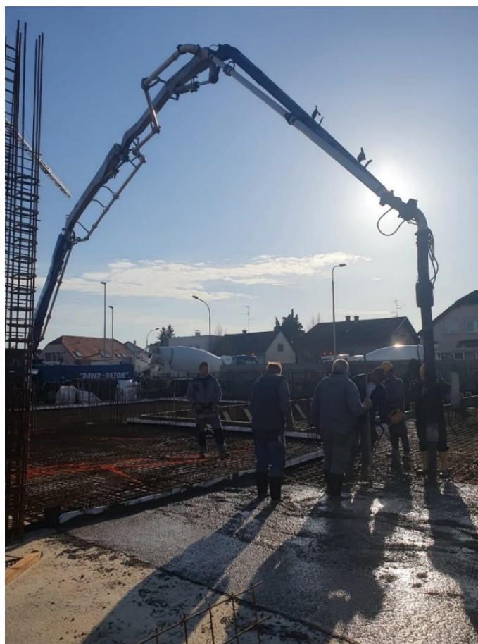
Slika 62. Pumpa za beton i automiješalica
