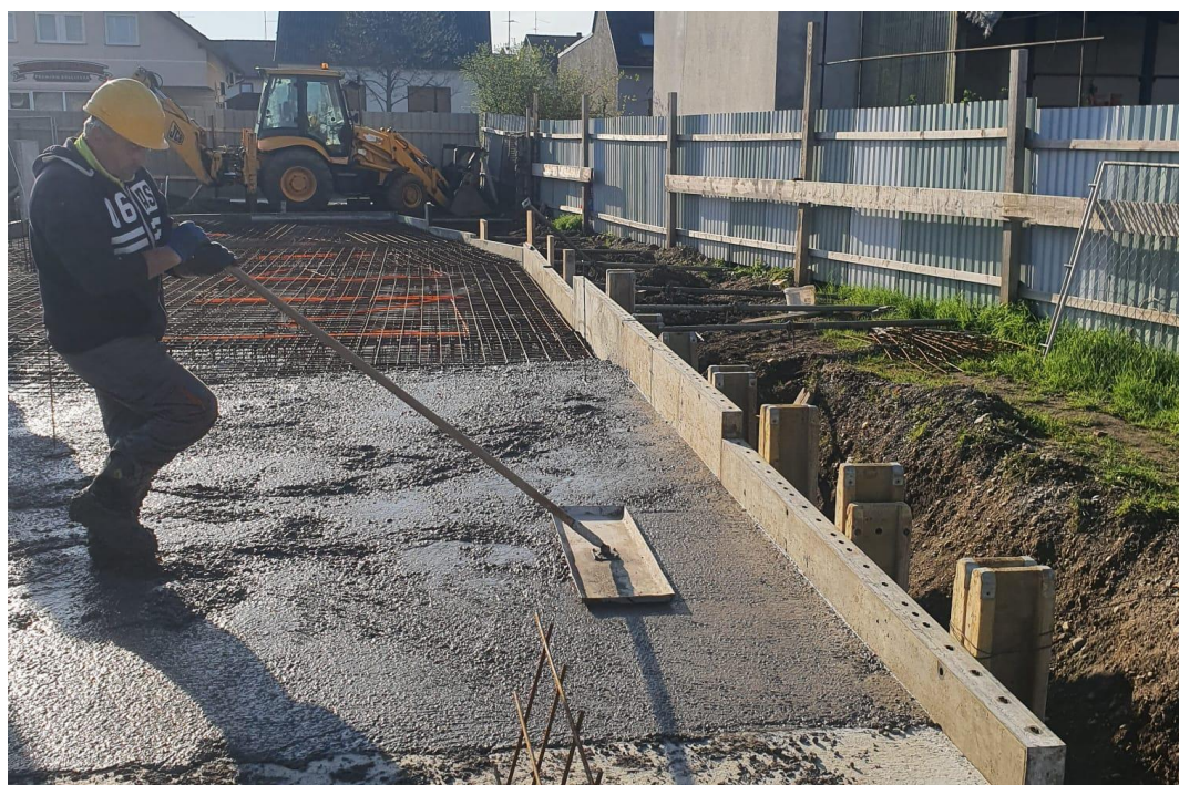
Slika 48. Ravnanje betona
