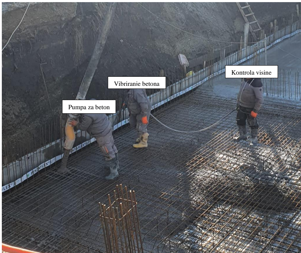
Slika 25. Betoniranje drugog dijela temeljne ploče ujutro
