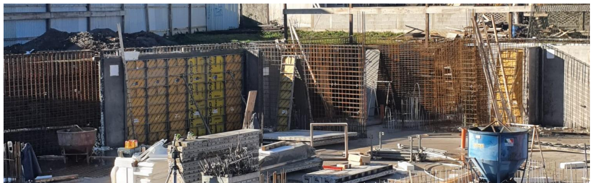
Slika 30. Oplata za vanjske zidove podzemne garaže
