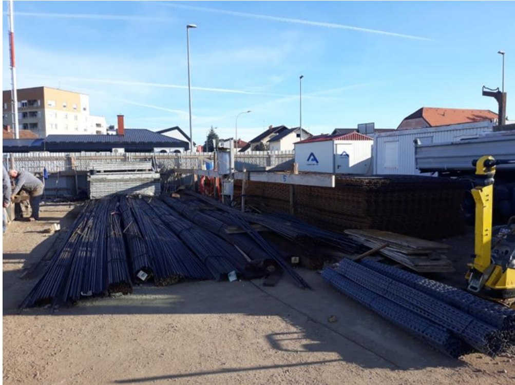
Slika 22. Šipkasta armatura skladištena na gradilištu
