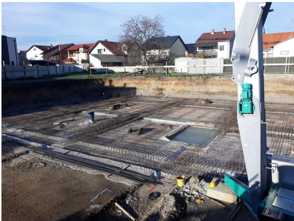
Slika 23. Postavljanje armature za temeljnu ploču
