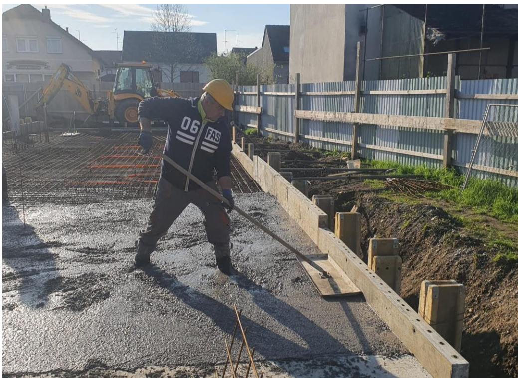
Slika 47. Ravnanje betona
