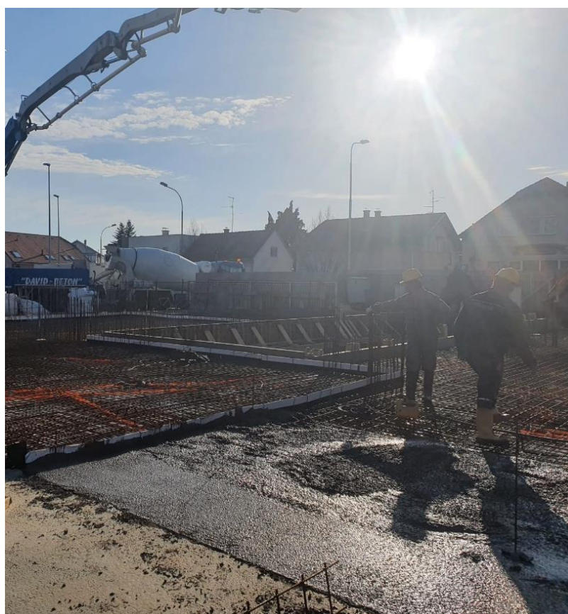
Slika 42. Automiješalica kojom je dovezen beton
