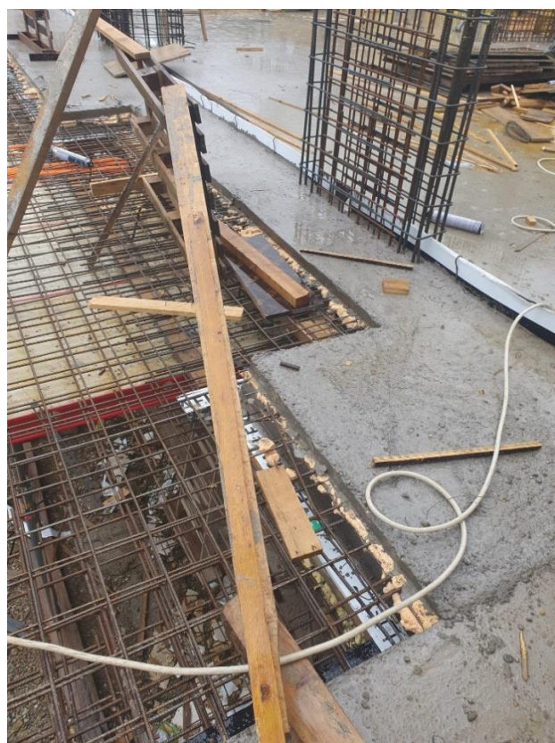
Slika 59. Pentaflex brtveni lim
