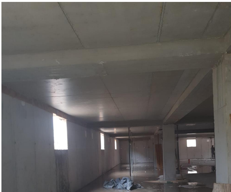
Slika 55. Izbetonirana podzemna garaža prvi dio
