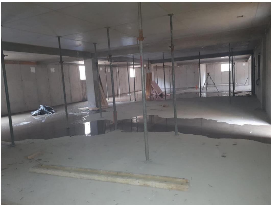
Slika 54. Izbetonirana podzemna garaža prvi dio
