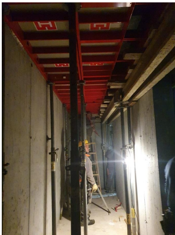
Slika 51. Skidanje stropne oplata na području podzemne garaže objekta
