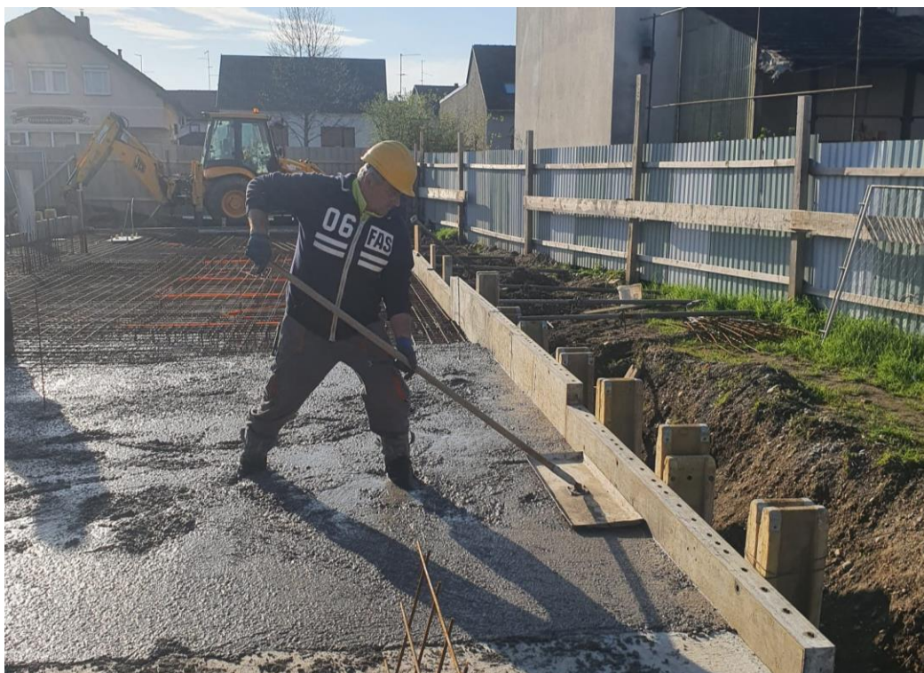
Slika 47. Ravnanje betona
