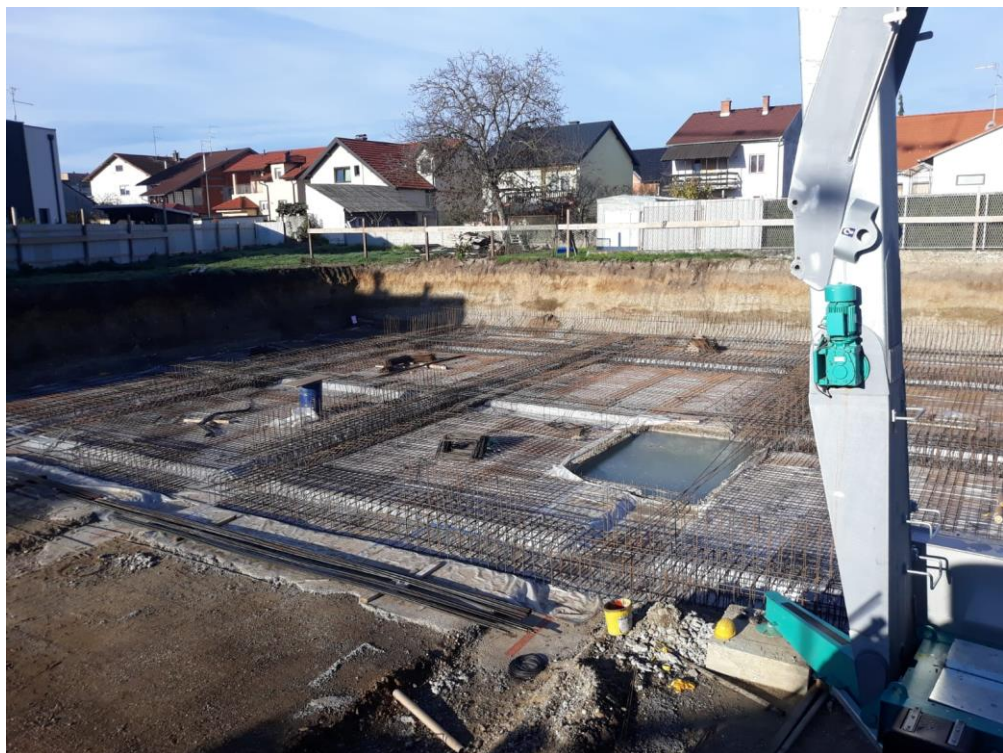
Slika 23. Postavljanje armature za temeljnu ploču
