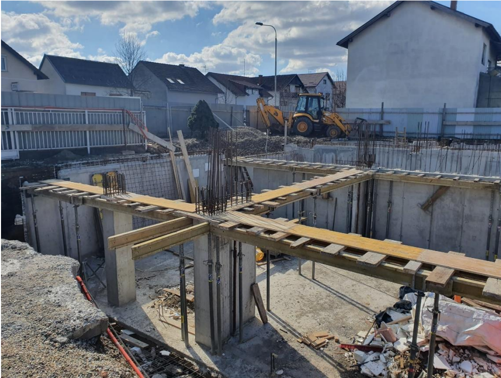
Slika 33. Oplata greda podruma zadnja trećina
