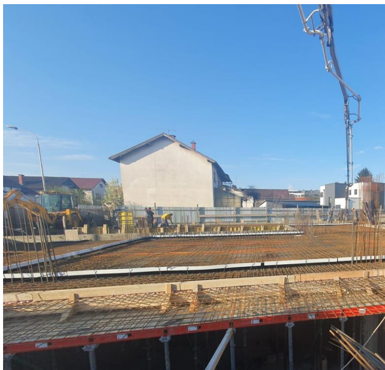
Slika 43. Početak betoniranja stropne ploče podruma zadnje trećine pumpom za beton
