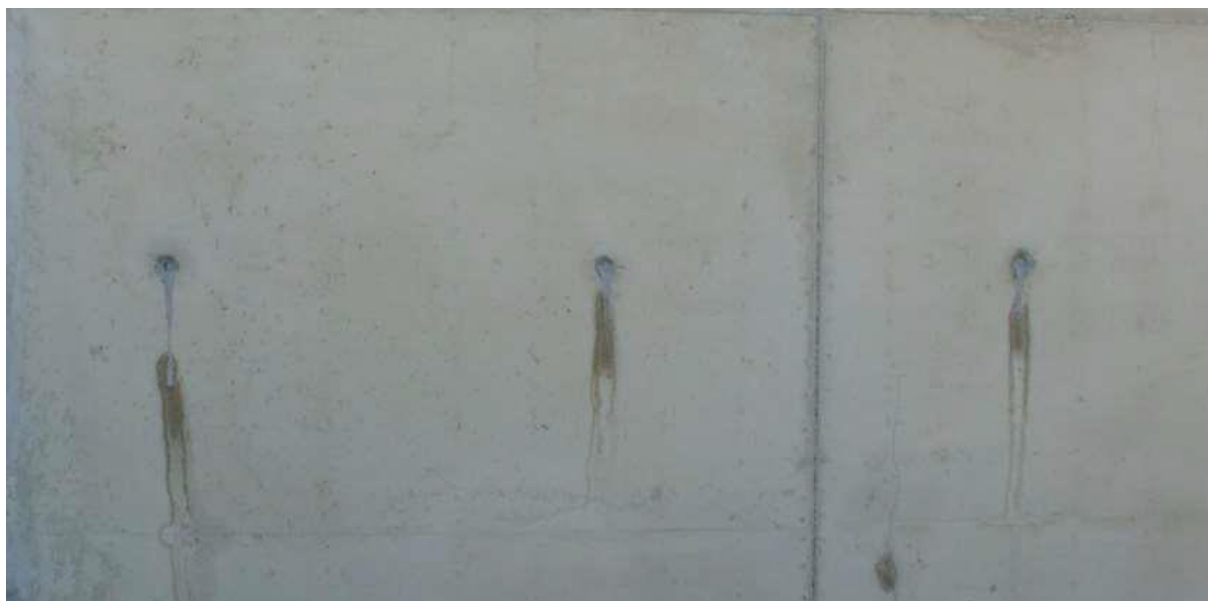
Slika 6. Pukotine prilikom skupljanja u vrijeme očvršćivanja betona
