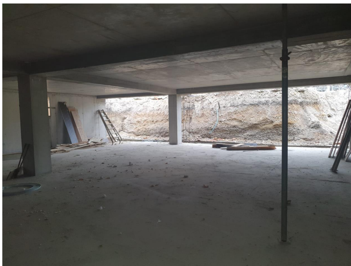
Slika 56. Izbetonirana podzemna garaža prvi dio
