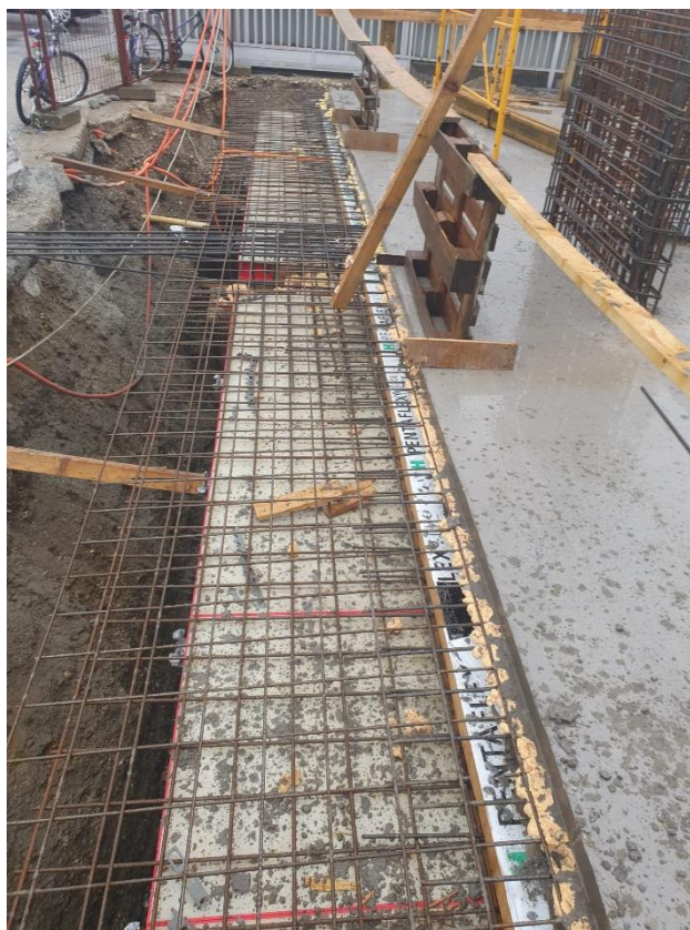
Slika 58. Pentaflex brtveni lim
