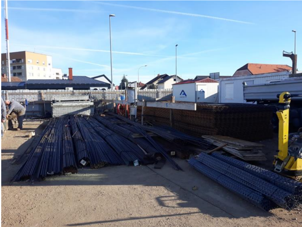
Slika 22. Šipkasta armatura skladištena na gradilištu
