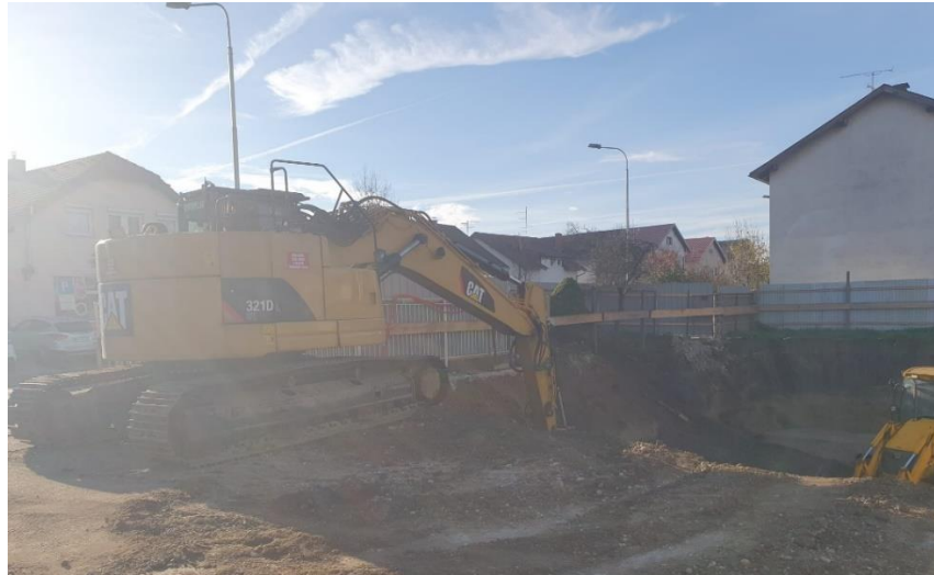
Slika 19. Bager prilikom iskopa građevne jame
