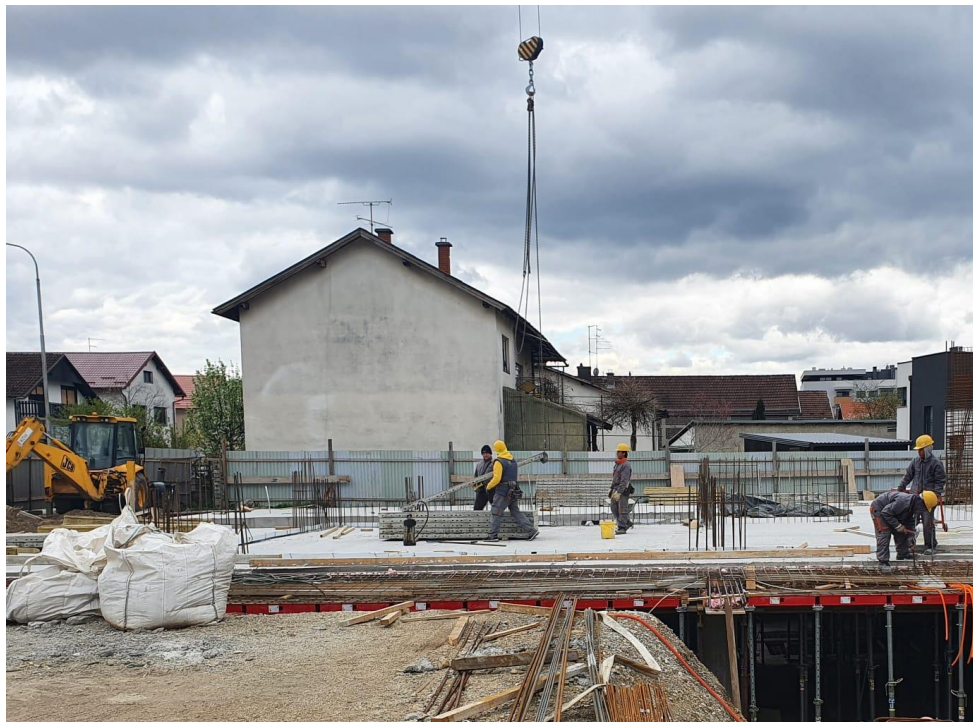
Slika 50. Stropna ploča podruma zadnje trećine par dana nakon betoniranja
