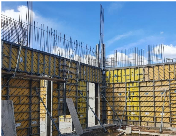
Slika 65. Zidna oplata Frami xlife proizvođač Doka
