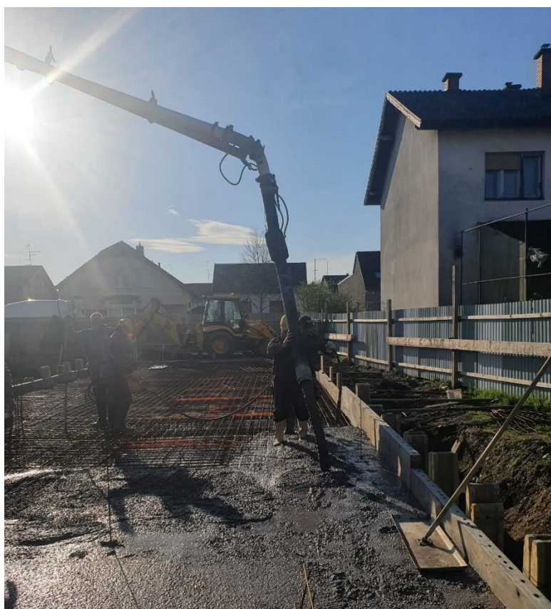
Slika 44. Ugradnja betona pumpom za beton
