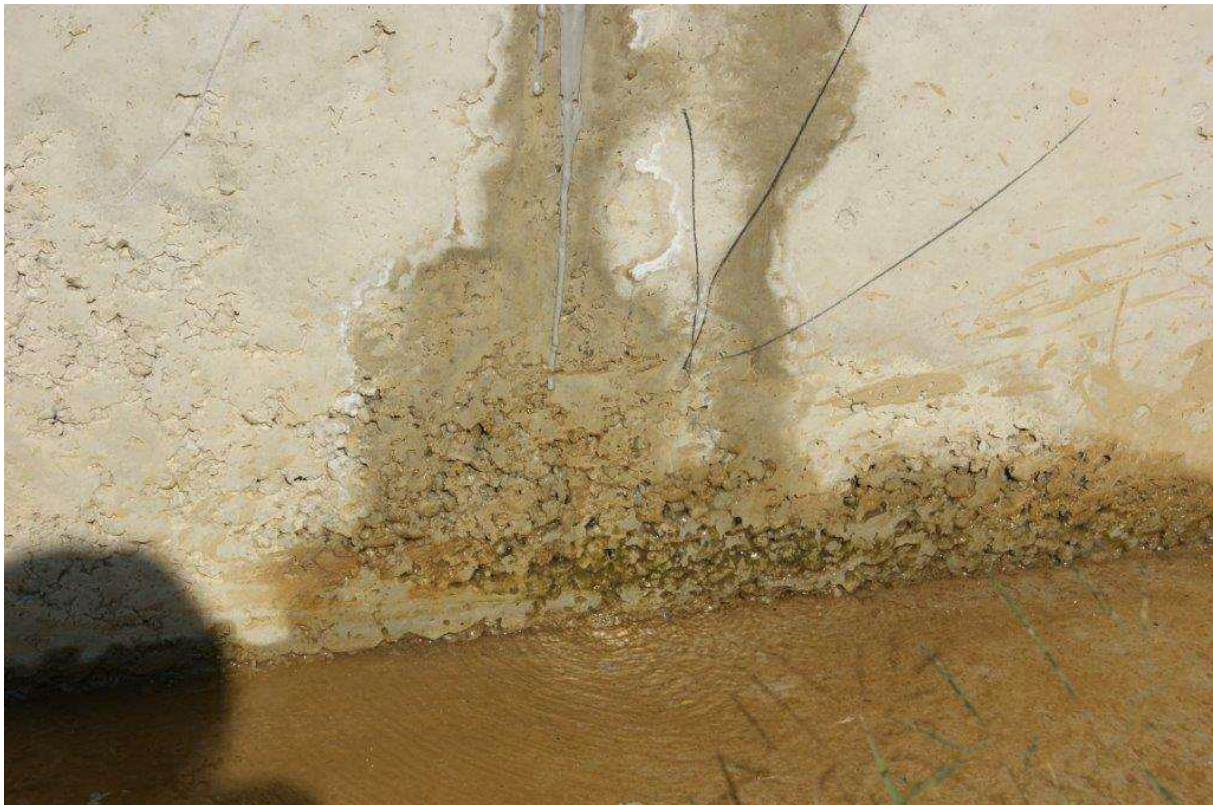
Slika 8. Segregacija betona
