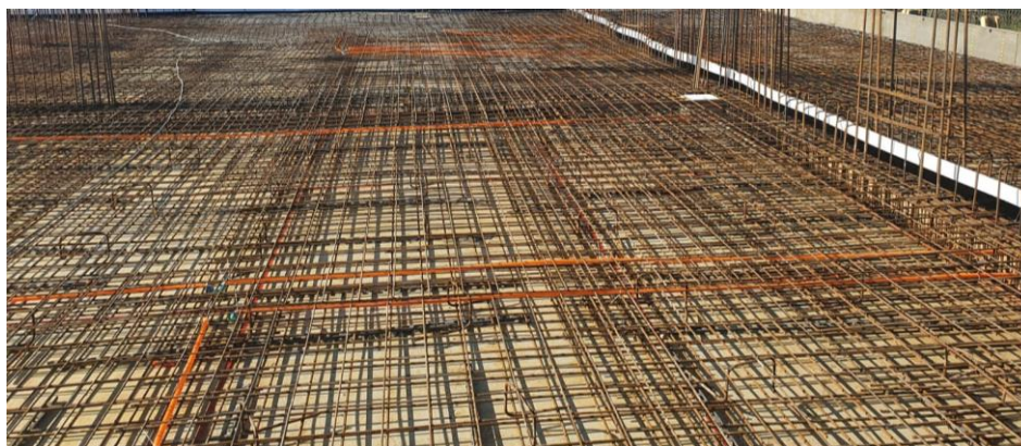
Slika 39. Postavljena armatura stropne ploče podruma na drugom dijelu
