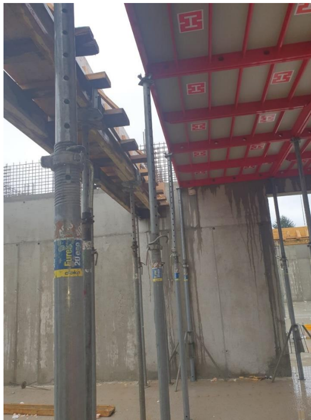
Slika 34. Postavljanje oplata greda i stropne ploče prizemlja prve polovine
