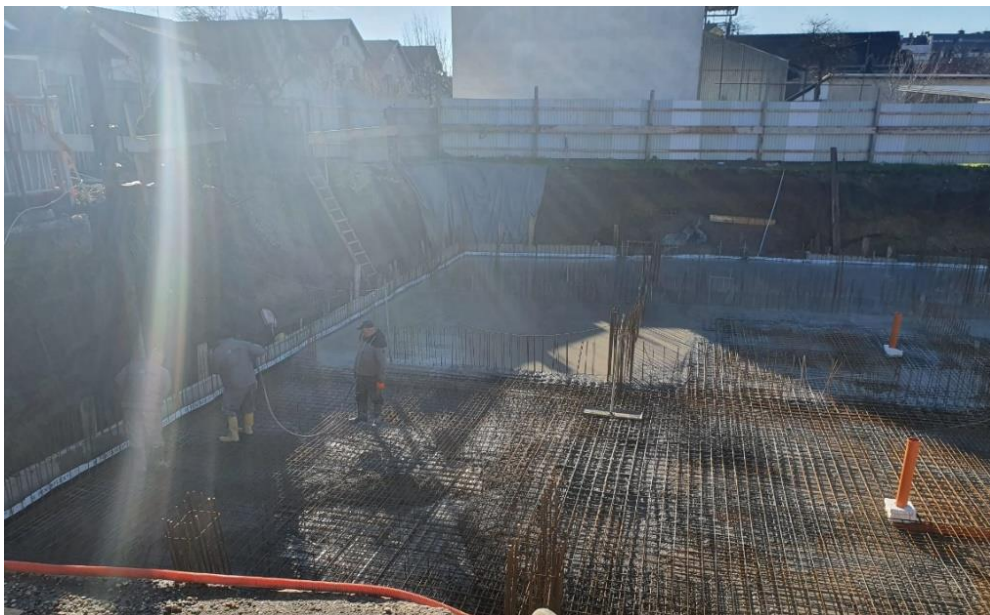
Slika 26. Betoniranje drugog dijela temeljne ploče ujutro
