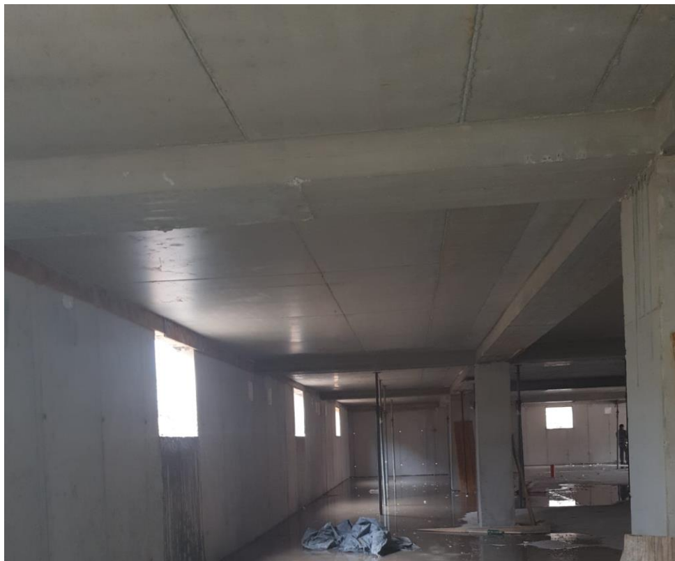
Slika 55. Izbetonirana podzemna garaža prvi dio
