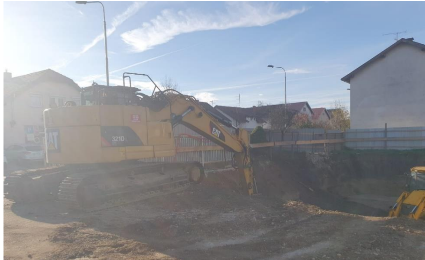
Slika 19. Bager prilikom iskopa građevne jame
