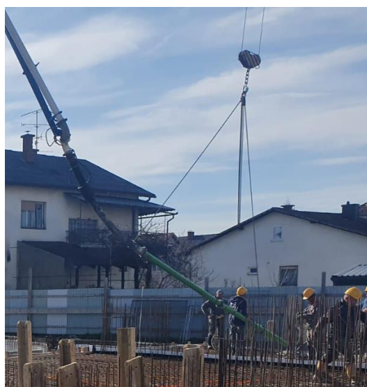
Slika 40. Betoniranje drugog dijela stropne ploče podruma - nadogradnja pumpe za ugradnju betona
