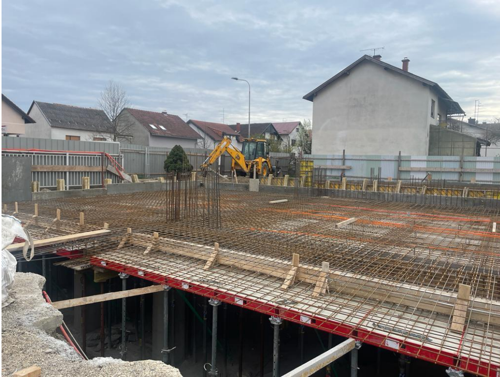
Slika 37. Postavljanje armature stropne ploče podruma (3/3) zajedno s postavljenom stropnom oplatom
