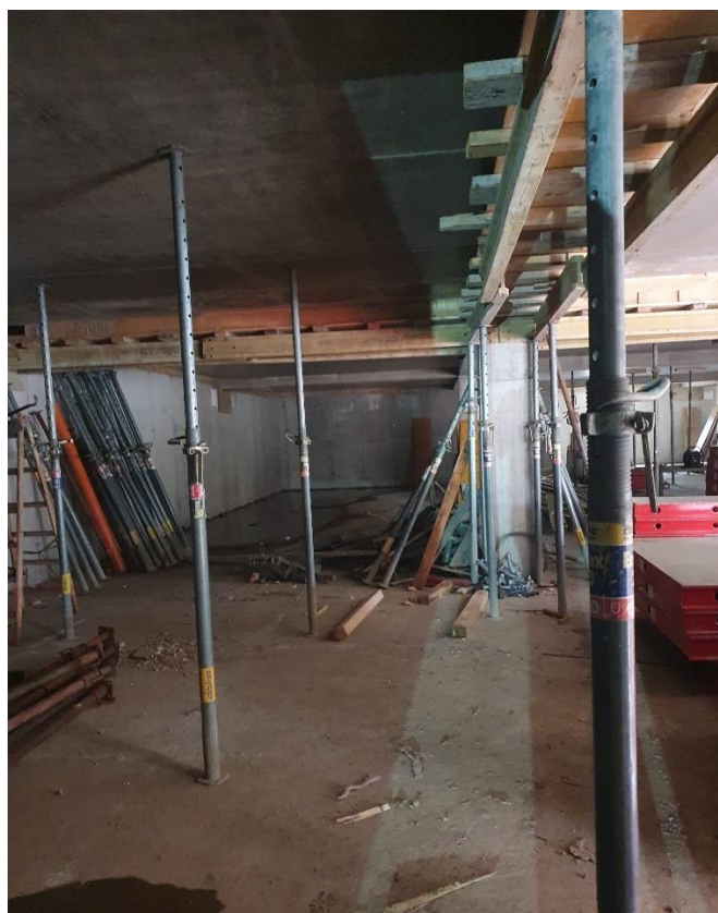
Slika 52. Skidanje stropne oplata na području podzemne garaže objekta - ostavljena oplata greda i podupirači
