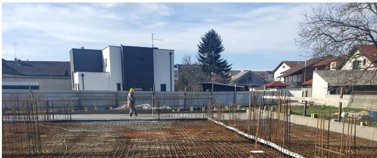
Slika 41. Betoniranje drugog dijela stropne ploče podruma
