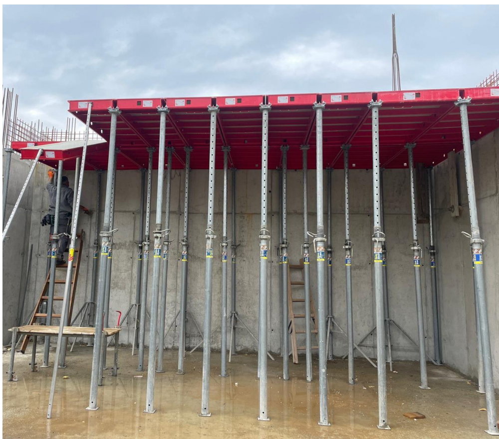
Slika 36. Postavljanje oplata stropne ploče prizemlja (2/2)
