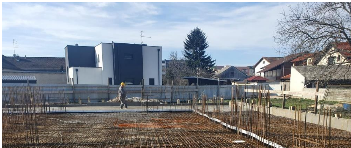
Slika 41. Betoniranje drugog dijela stropne ploče podruma
