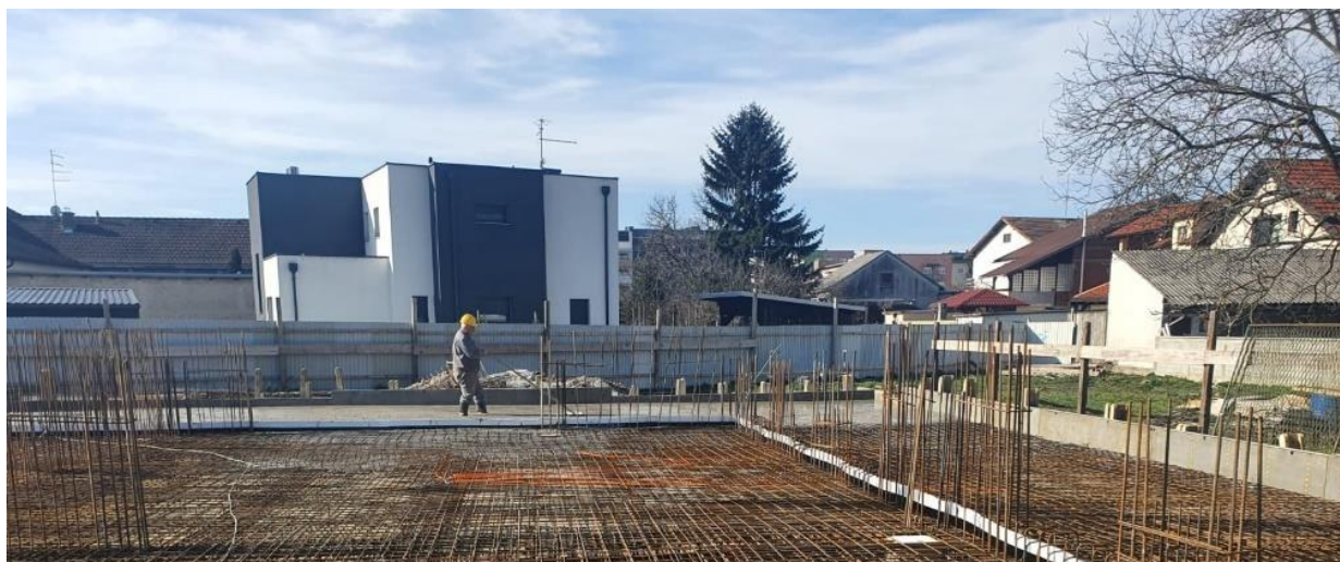
Slika 41. Betoniranje drugog dijela stropne ploče podruma
