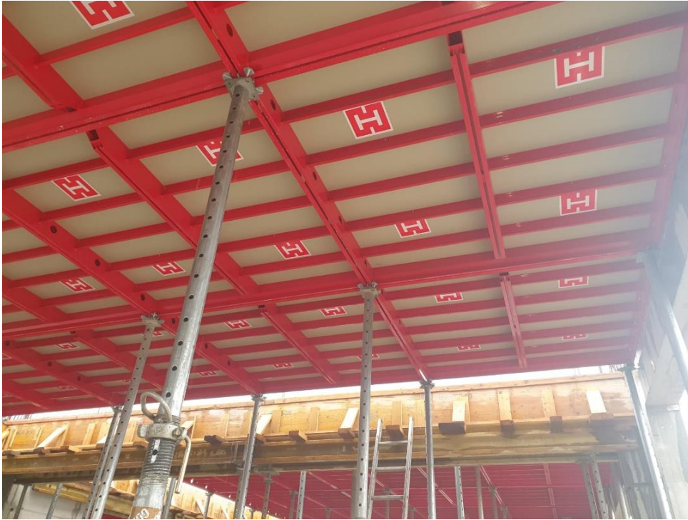
Slika 35. Postavljanje oplata stropne ploče prizemlja prve polovine
