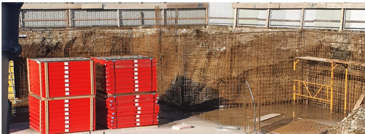
Slika 29. Postavljanje armature za vanjske zidove podzemne garaže
