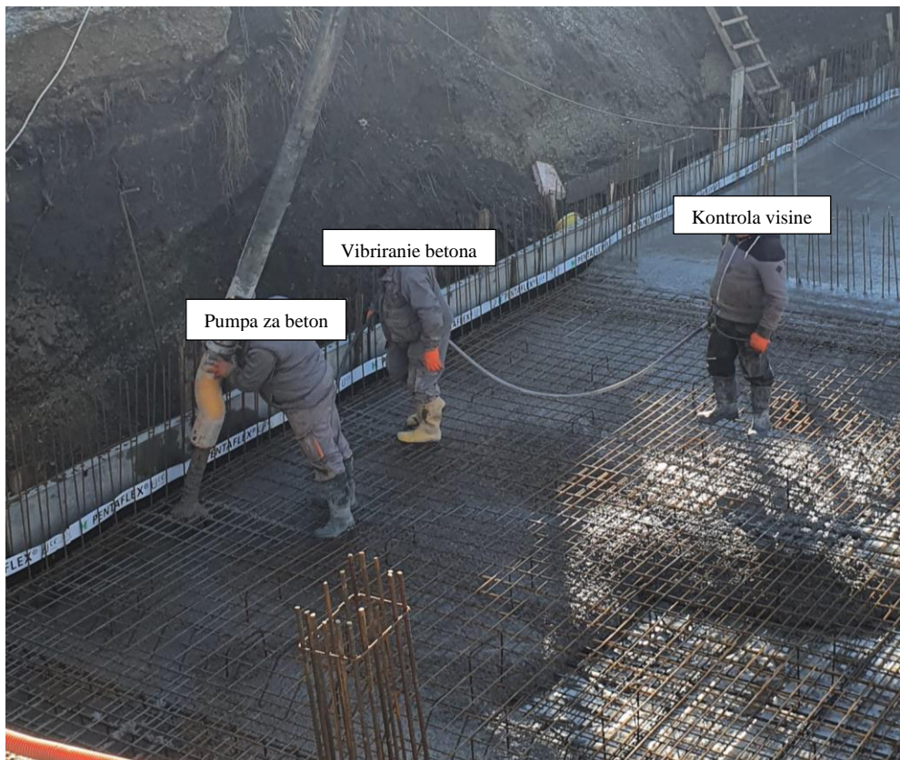
Slika 25. Betoniranje drugog dijela temeljne ploče ujutro
