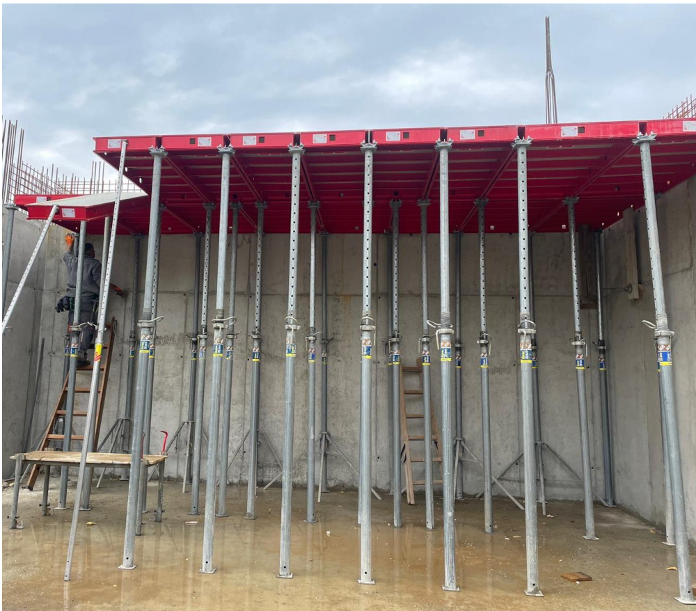
Slika 36. Postavljanje oplata stropne ploče prizemlja (2/2)
