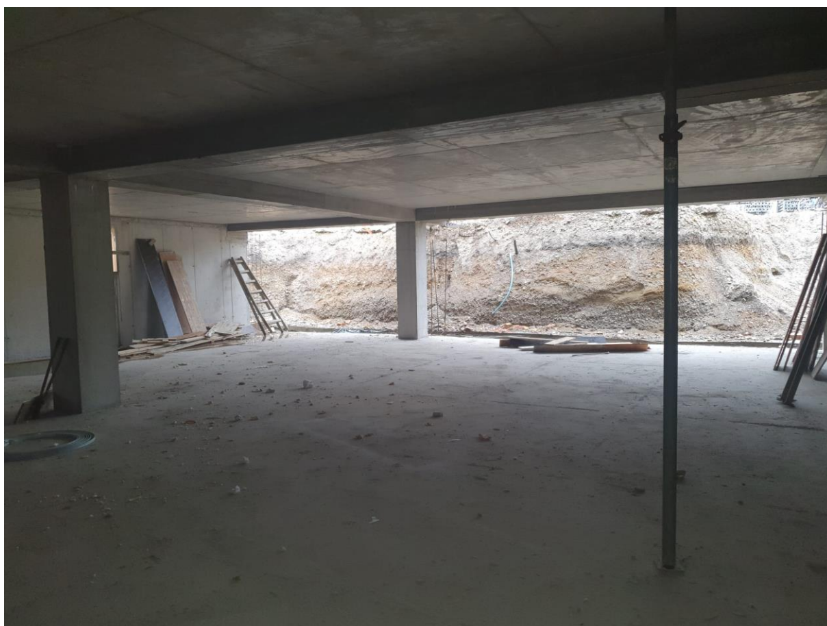
Slika 56. Izbetonirana podzemna garaža prvi dio
