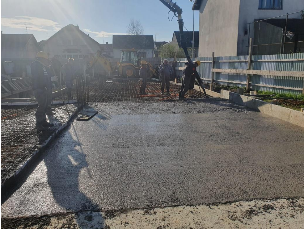
Slika 49. Nastavak betoniranja stropne ploče podruma
