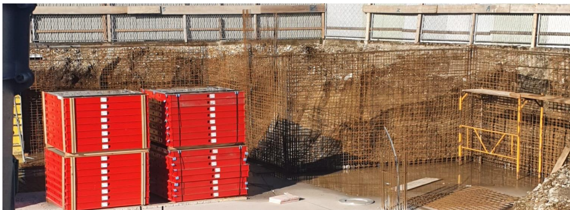
Slika 29. Postavljanje armature za vanjske zidove podzemne garaže
