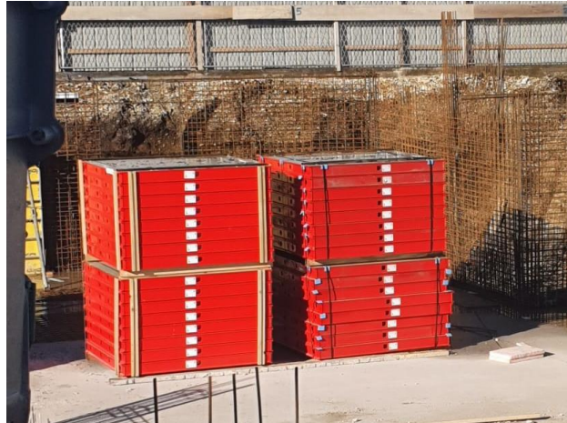
Slika 31. Stropna oplata Hünnebeck Topce
