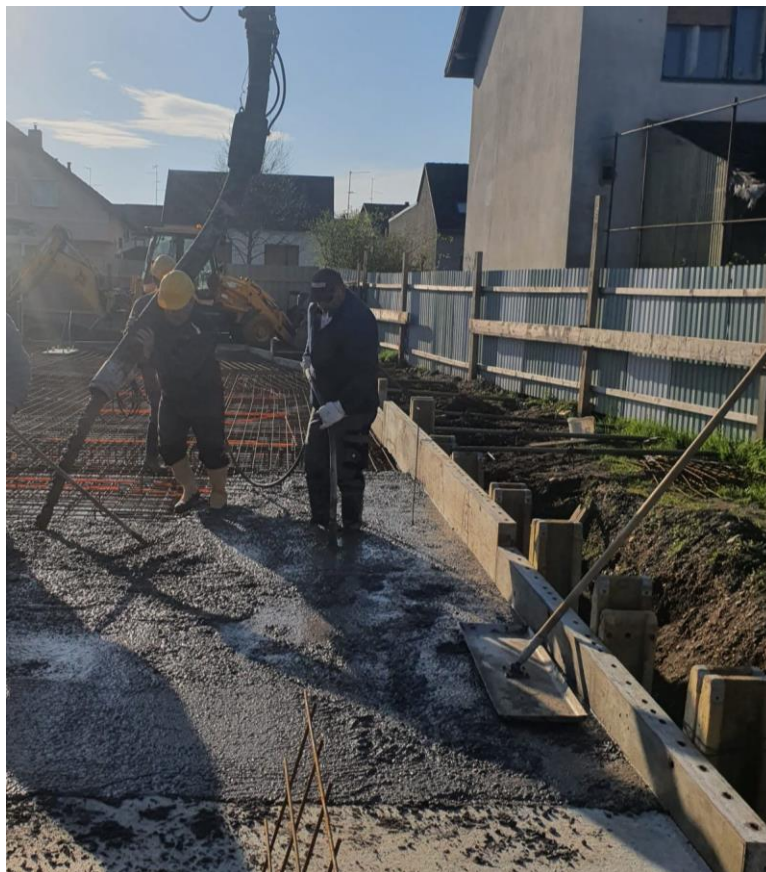
Slika 45. Vibriranje betonske mase
